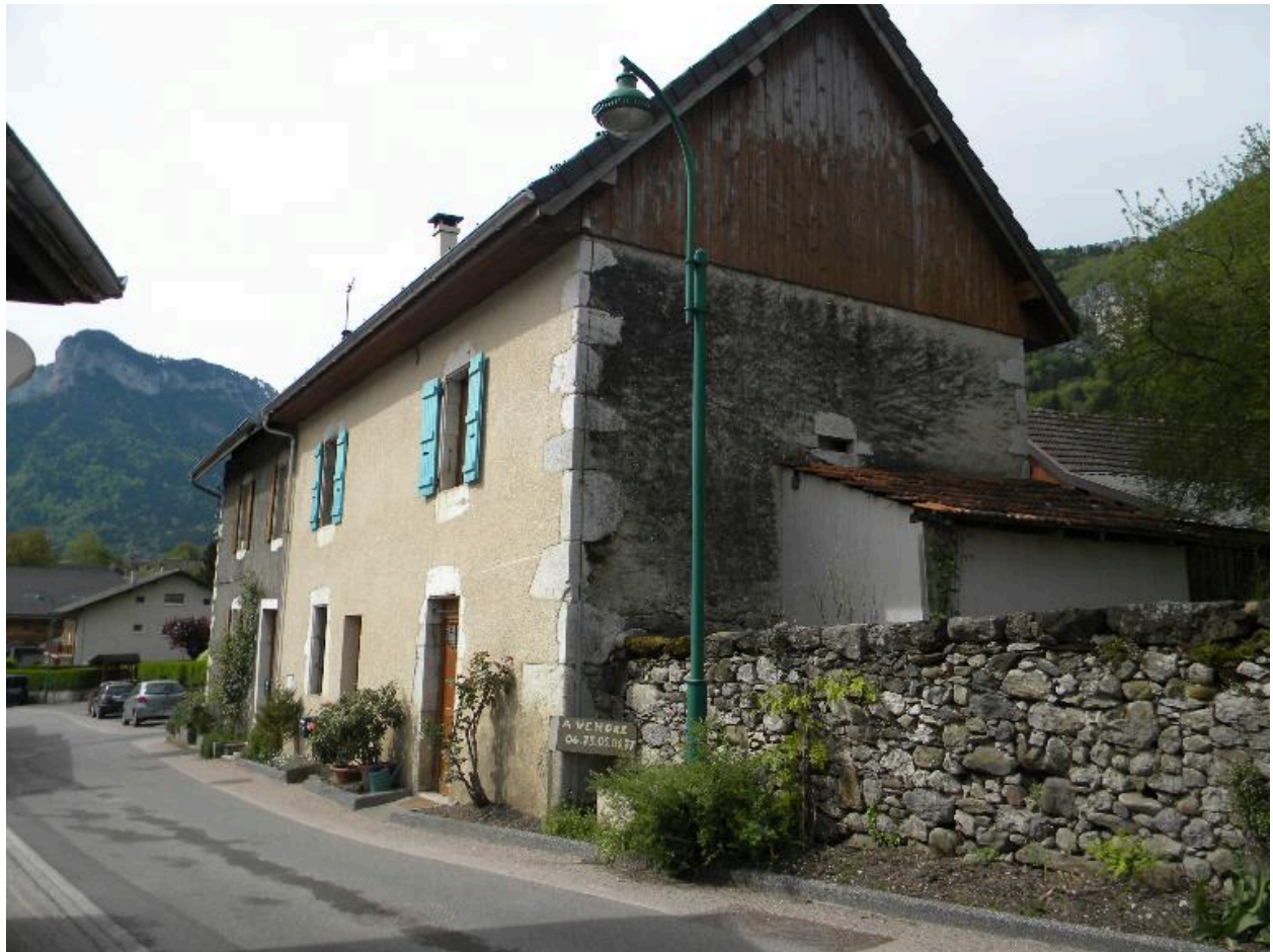
Vue d'une ancienne maison depuis le nord (2008 A5 827, 828, 829, 830).
