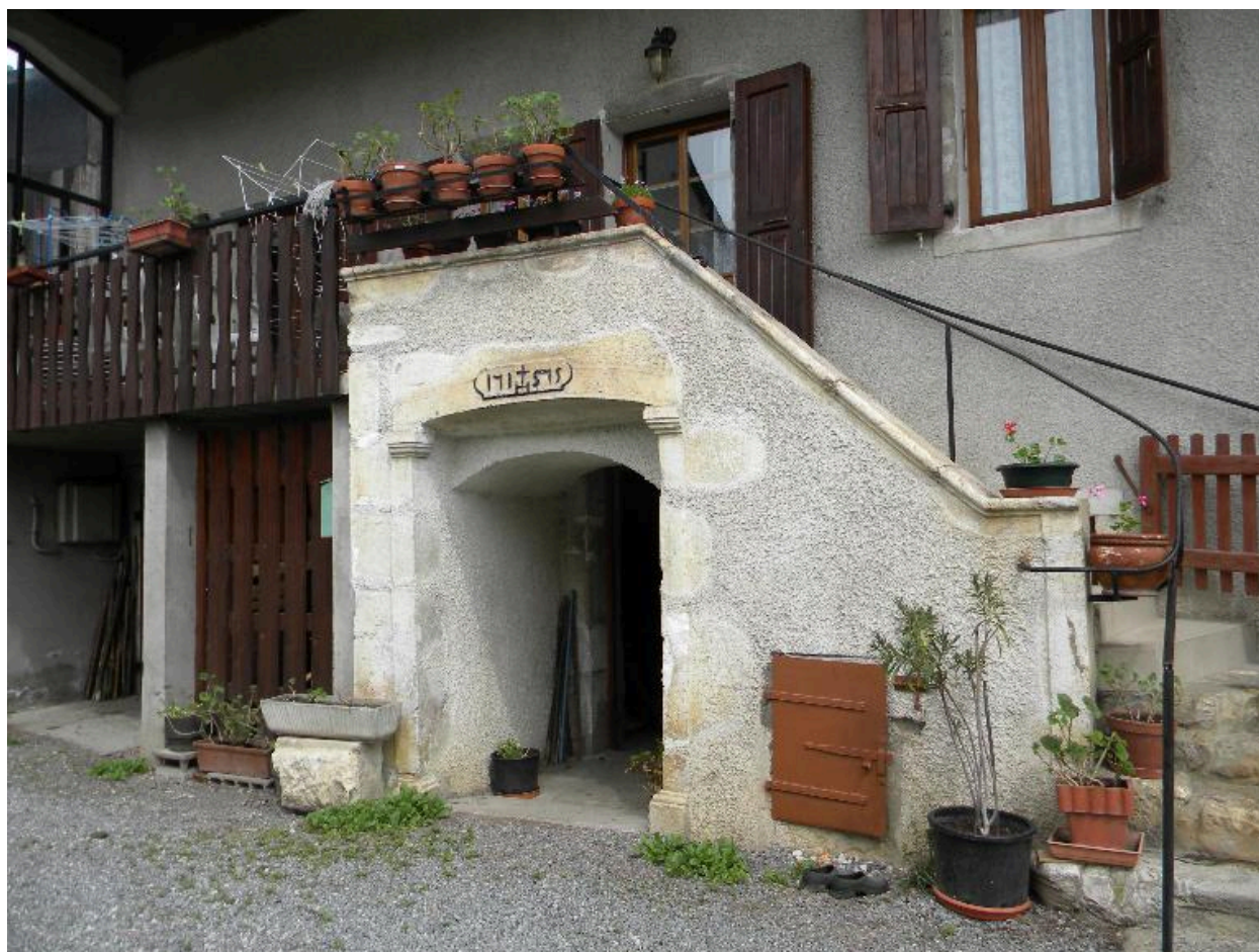
Vue d'un encadrement de porte ouvragé sur la façade d'une ancienne ferme (2008 B2 1208).
