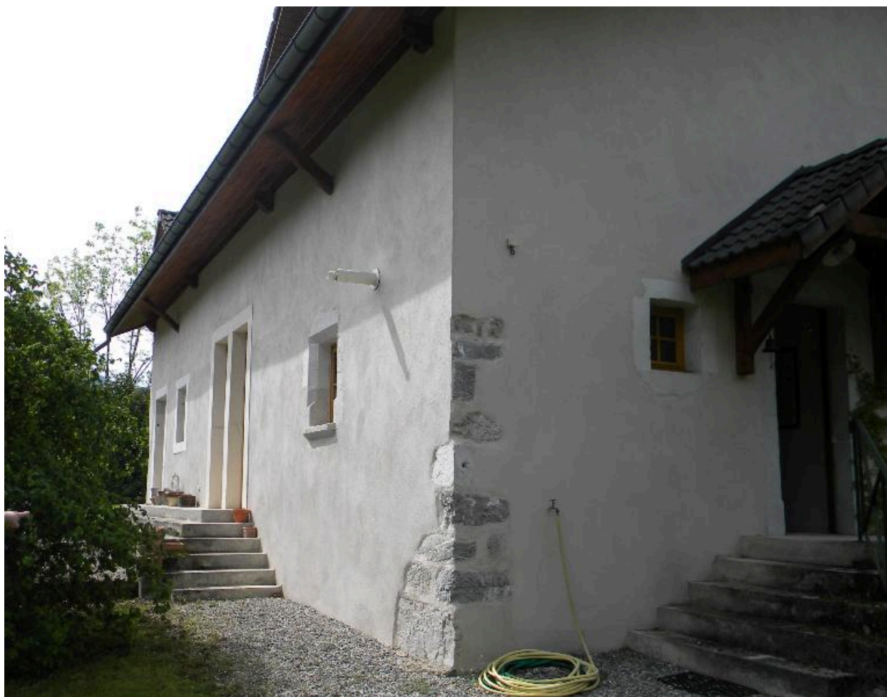
Vue de trois-quarts d'une ancienne grange transformée en chambre d'hôte (2008 B2 1937).
