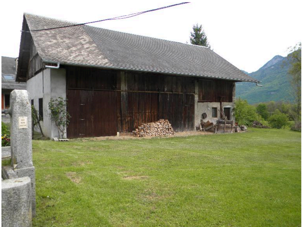
Vue d'une grange-étable (2008 B2 1211).
