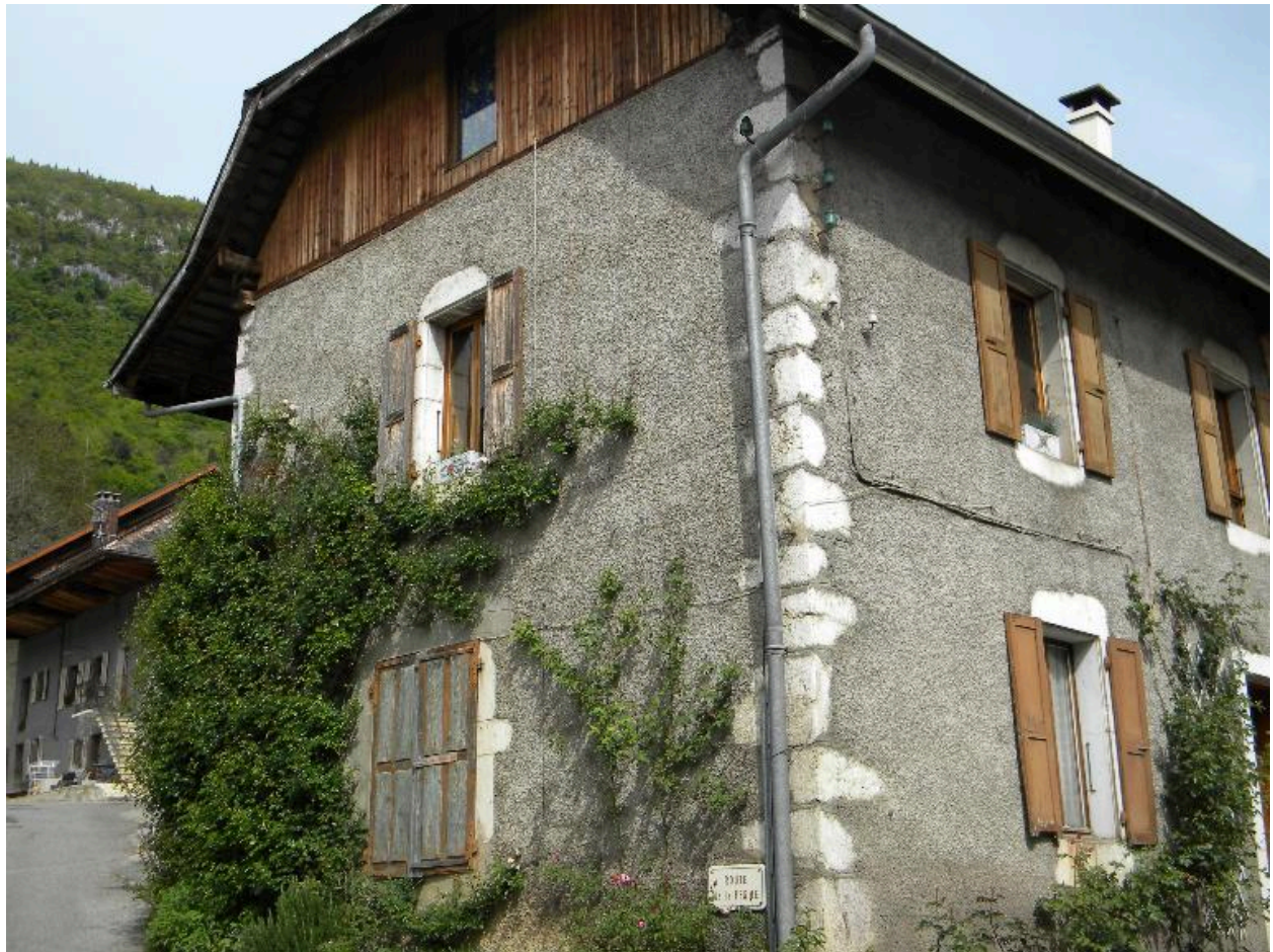
Vue d'une ancienne maison depuis le sud (2008 A5 827, 828, 829, 830)
