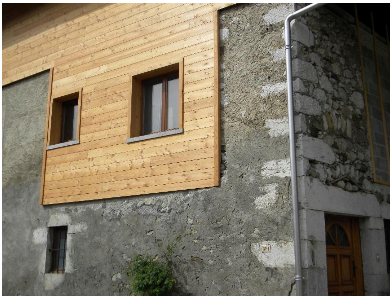
Détail d'une reprise en façade d'une ancienne grange (2008 A5 834)
