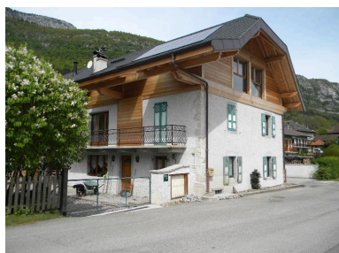
Façade principale d'une ferme transformée (2008 B2 1849) Phot. Jérôme Daviet IVR82_20147400232NUCA
