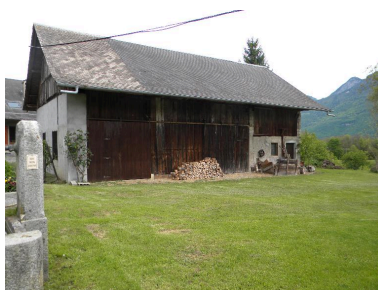
Vue d'une grange-étable (2008 B2 1211). Phot. Jérôme Daviet IVR82_20147400249NUCA
