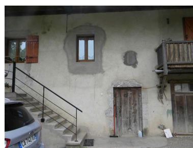
Vue de l'entrée de l'ancienne étable (2008 B2 1316, 1914). Phot. Jérôme Daviet IVR82_20147400247NUCA
