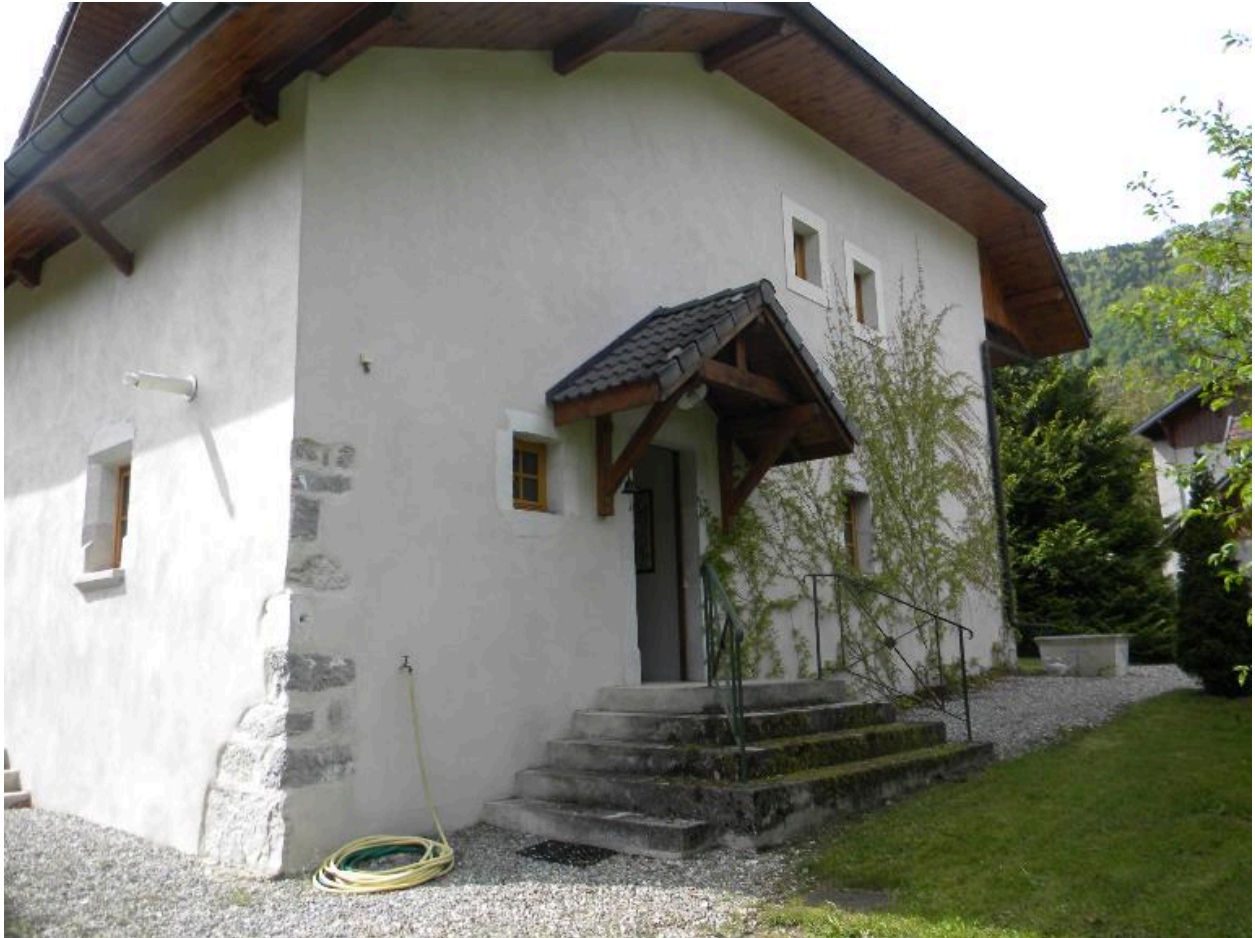
Vue du pignon d'une ancienne grange transformée en chambre d'hôte (2008 B 1937)
