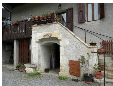
Vue d'un encadrement de porte ouvragé sur la façade d'une ancienne ferme (2008 B2 1208). Phot. Jérôme Daviet IVR82_20147400251NUCA
