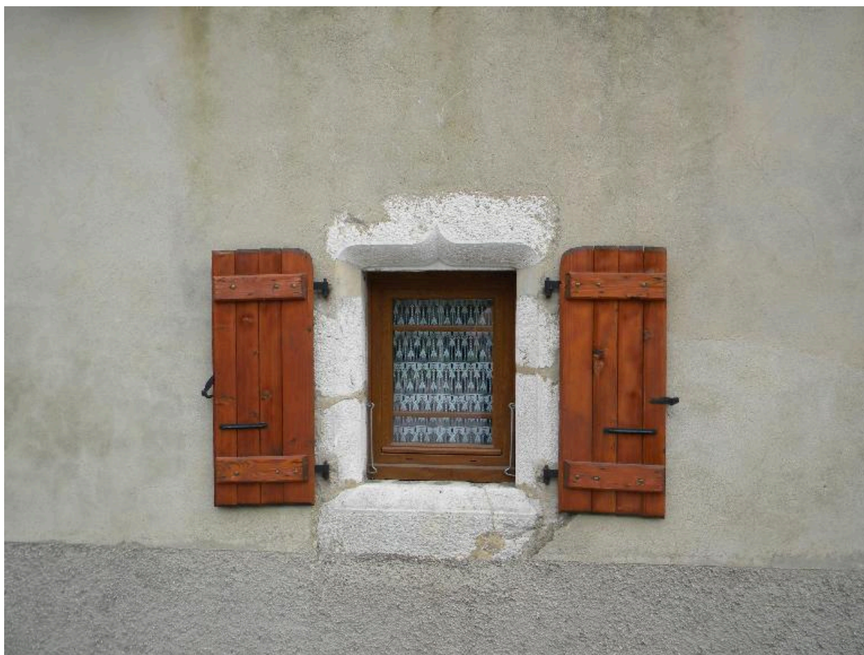
Vue d'une fenêtre à accolade sur une ancienne scierie (2008 B2 1999).
