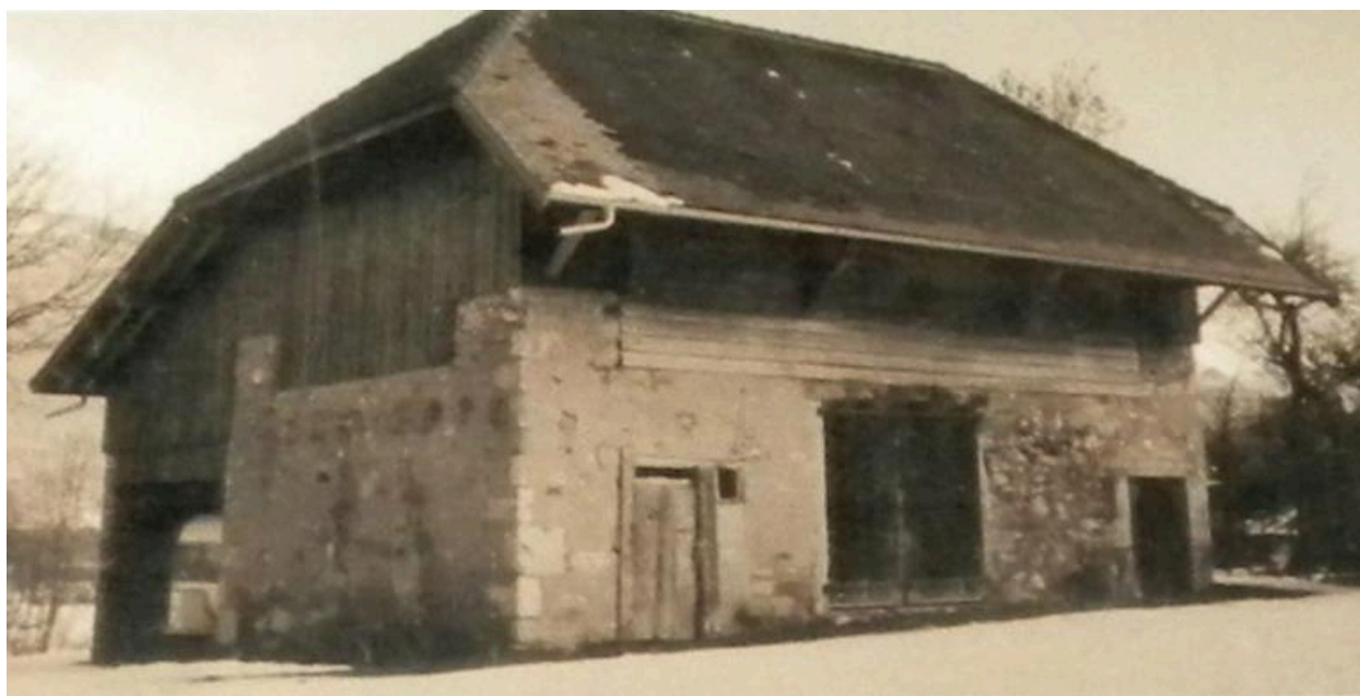
Vue de la grange dans son état initial (2008 B2 1937)
