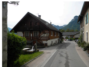
Vue d'une ancienne ferme transformée (2008 A5 826). Phot. Jérôme Daviet IVR82_20147400231NUCA
