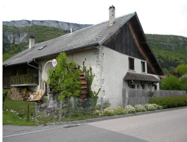
Vue d'ensemble d'une ancienne scierie (2008 B2 1999). Phot. Jérôme Daviet IVR82_20147400255NUCA
