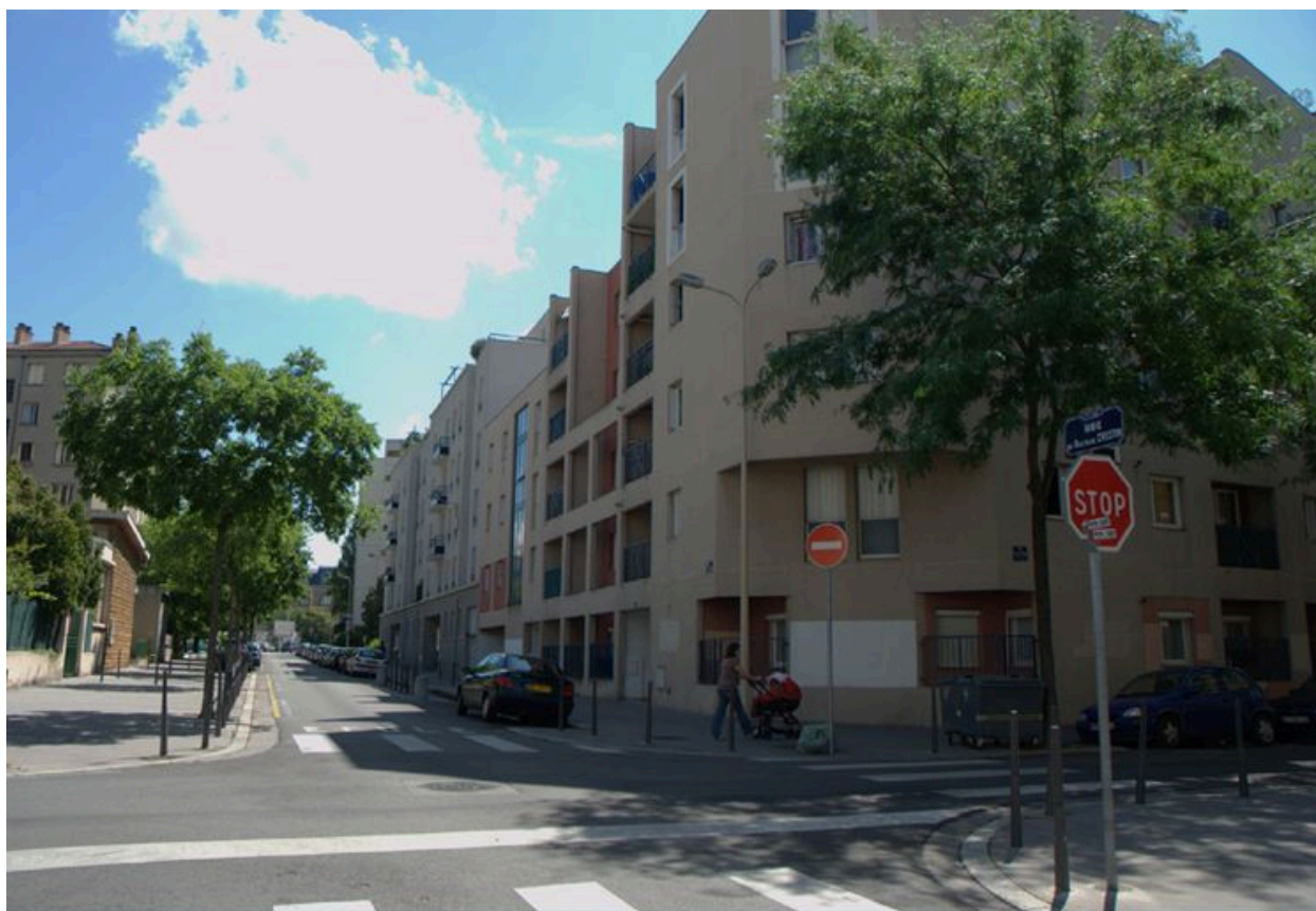
Elévation rue Docteur-Crestin depuis l'ouest
