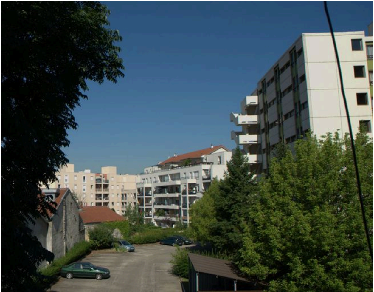
Elévations postérieures depuis le 38 boulevard des Tchécoslovaques
