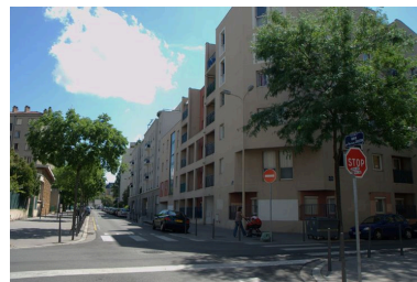
Elévation rue Docteur-Crestin depuis l'ouest Phot. Maryannick Chalabi IVR82_20086900885NUCA
