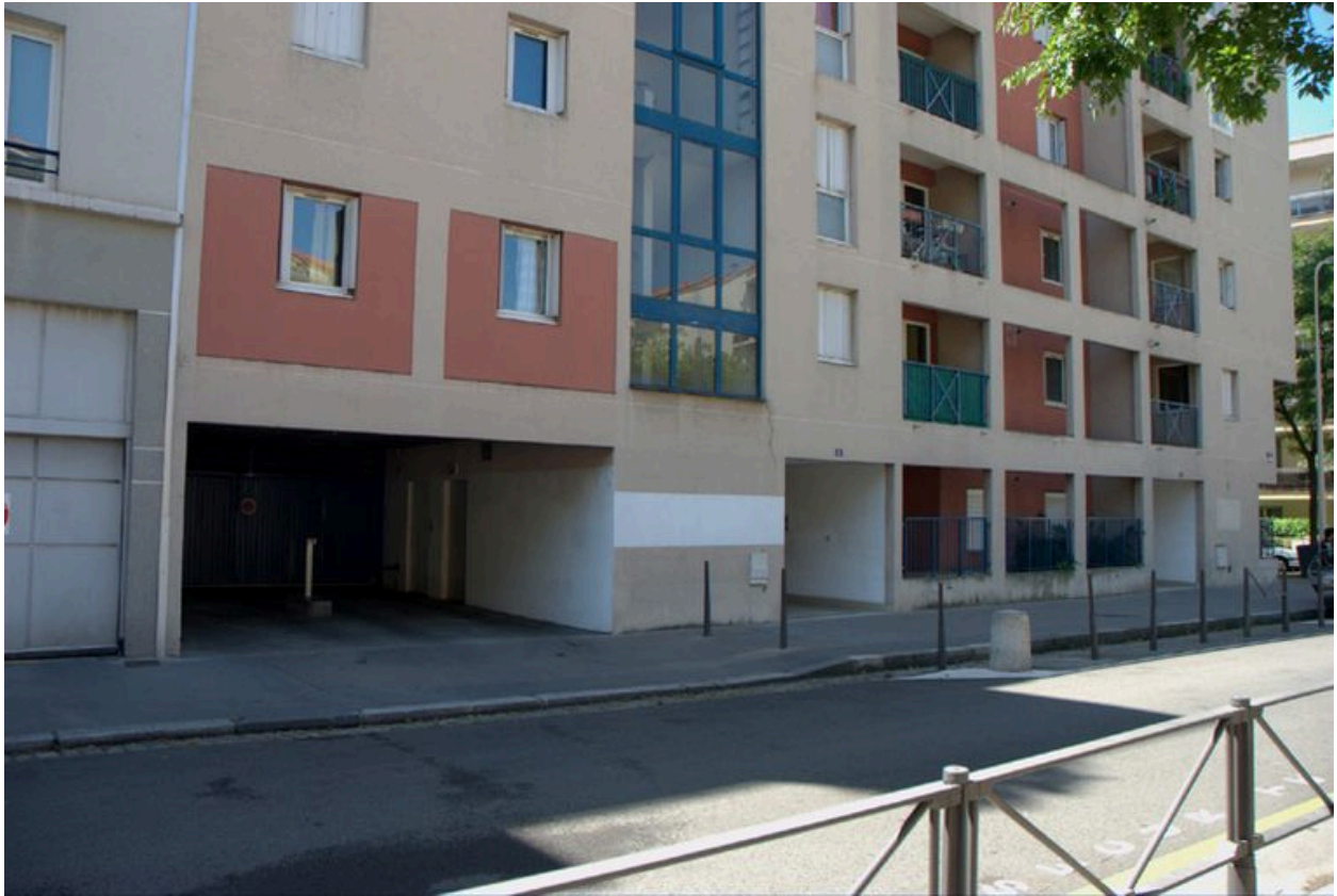
Élévation rue Docteur-Crestin depuis le nord-est
