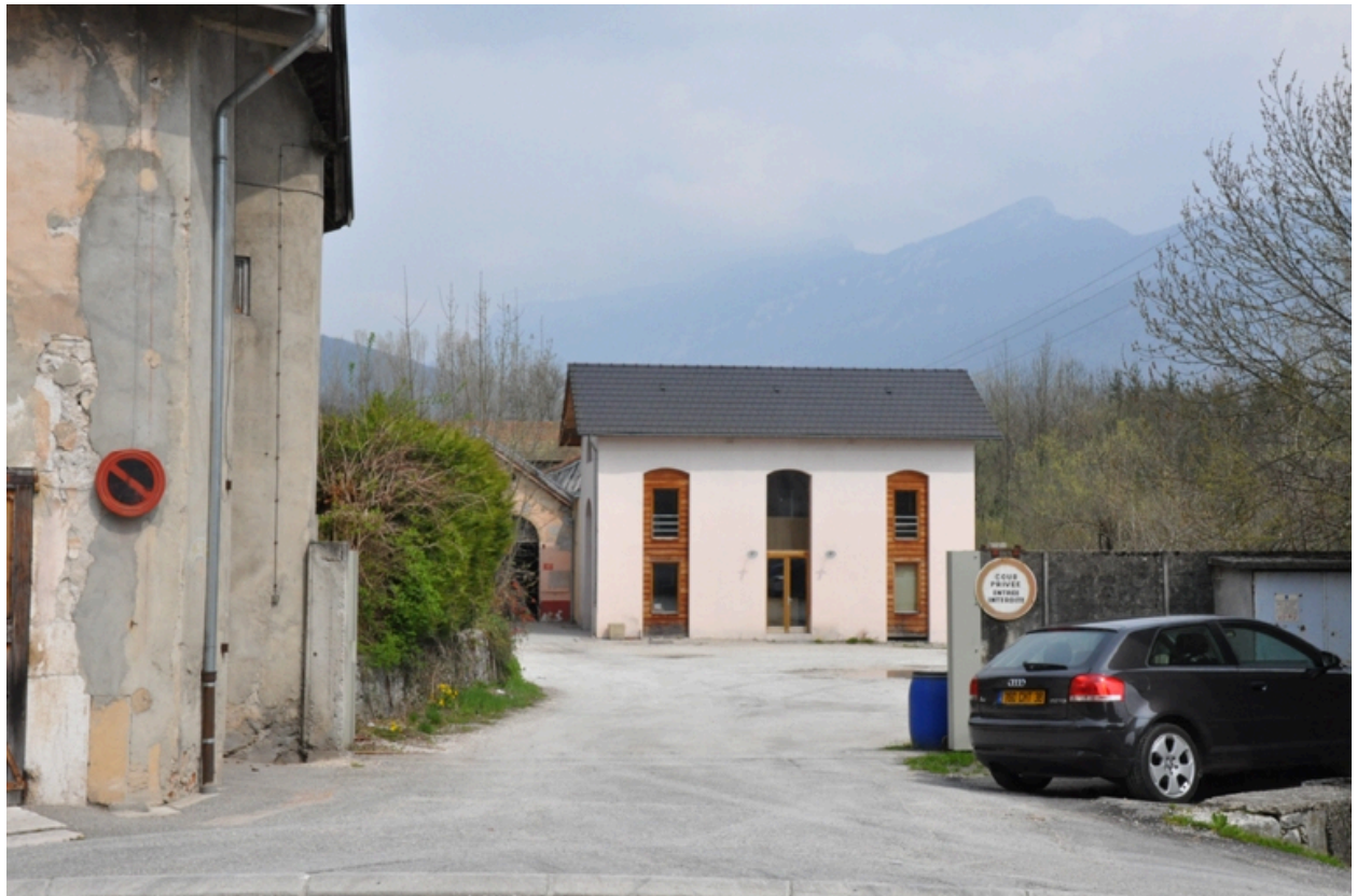
Vue de l'entrée de la corderie, au second plan le bâtiment d'accueil
