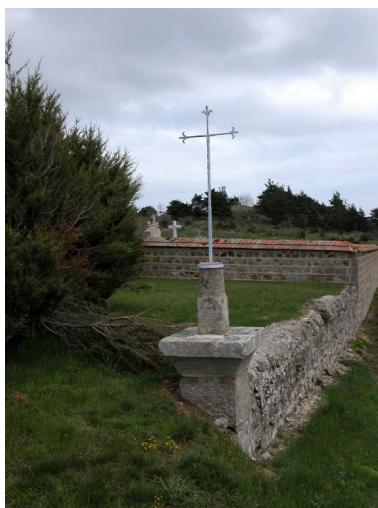
Vue générale. Phot. Thierry Monnet IVR82_20114201769NUCA
