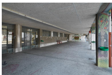
Préau, depuis le nord Phot. Thierry Leroy IVR82_20153800261NUCAQ
