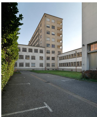
Bâtiment D, depuis l'ouest Phot. Thierry Leroy IVR82_20153800253NUCAQ
