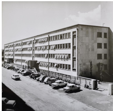
Vue de l'élévation principale, depuis le nord-est (1966, AC Grenoble 3 FI 88) Repro. Catherine Guégan, Autr. auteur inconnu IVR84_20163800221NUCB
