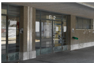
Préau : détail des serrureries (portes et fenêtres) Phot. Thierry Leroy IVR82_20153800351NUCA
