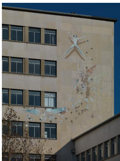
Bâtiment D, détail de la peinture murale Phot. Thierry Leroy IVR82_20153800307NUCAQ
