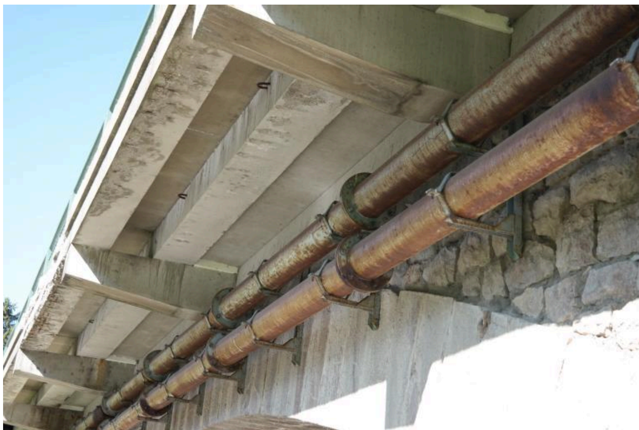
Pont de Vers l'Usine, détail de l'élargissement du tablier
