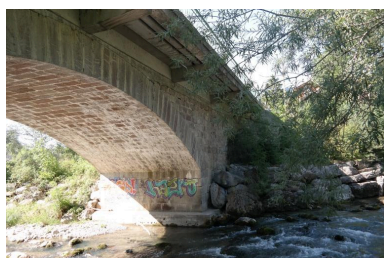
Pont de Vers l'Usine, vue du dessous Phot. Pascale Renard IVR84_20207401048NUCA
