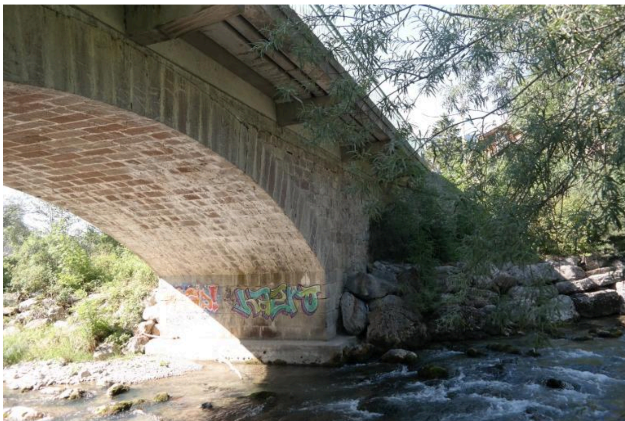
Pont de Vers l'Usine, vue du dessous
