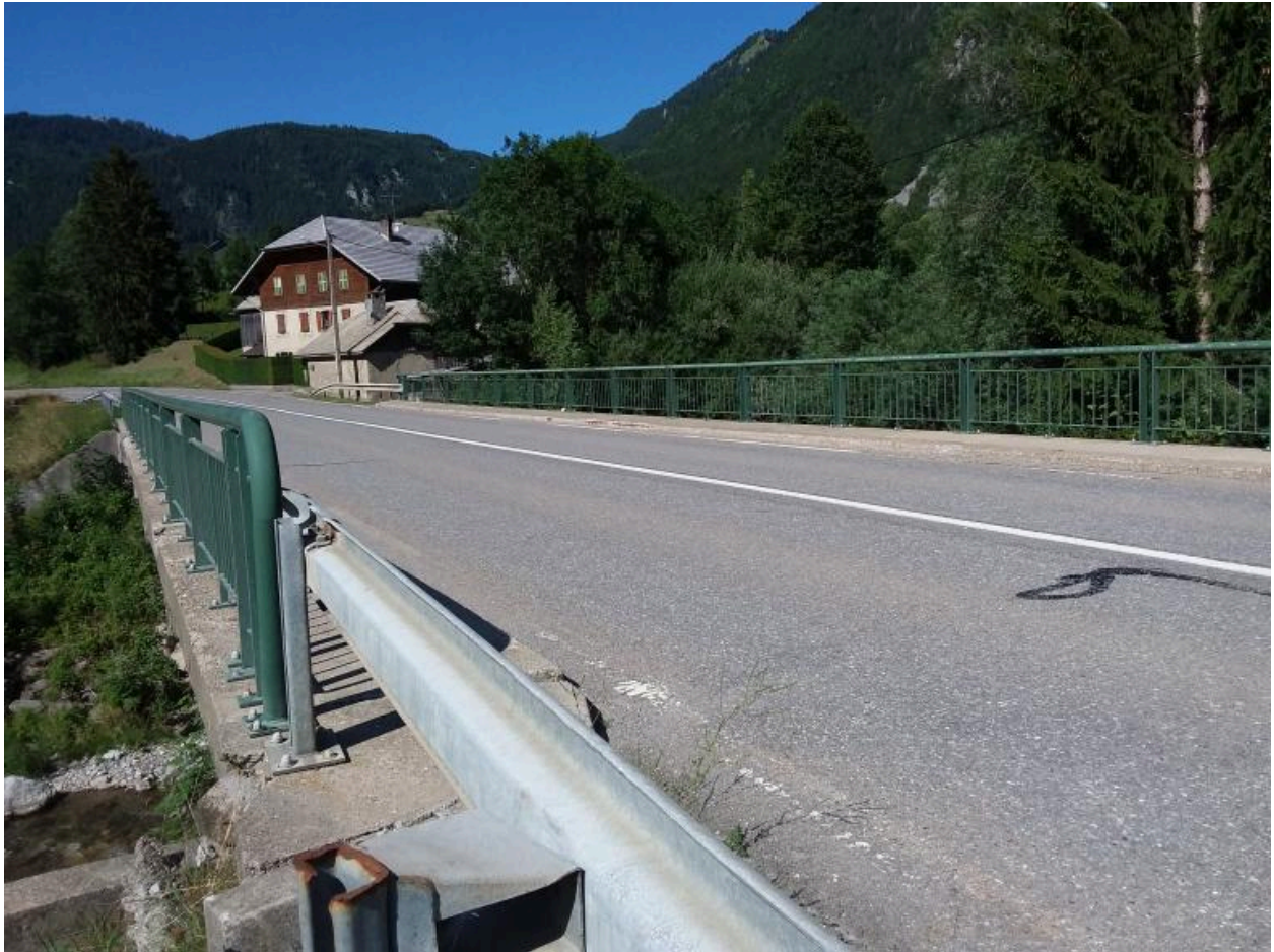
Pont de Vers l'Usine, chaussée et garde-corps
