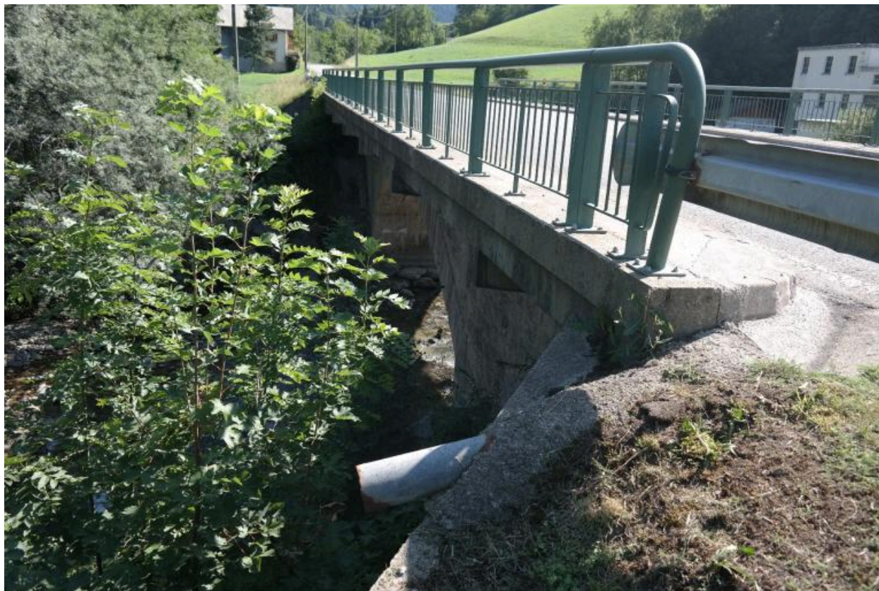
Pont de Vers l'Usine, vue de la face amont
