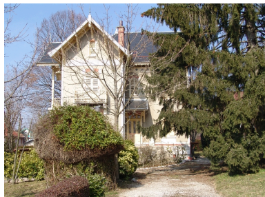
Vue d'ensemble Phot. François Fouger IVR82_20067300581NUCA
