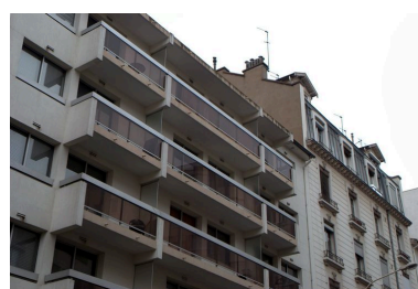
Immeuble 6 rue Victorien-Sardou. Détail des étages supérieurs Phot. Maryannick Chalabi IVR82_20086900747NUCA
