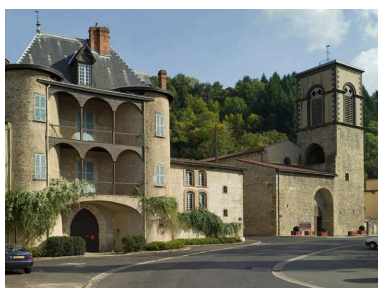
Les bâtiments de l'abbaye encore visibles : le logis abbatial à gauche et l'église Saint-Symphorien à droite. Phot. Jean-Michel Périn IVR83_20116301109NUC4A
