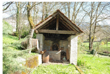
Vue d'ensemble du four à pain. Phot. Thierry Monnet IVR84_20187400062NUCA
