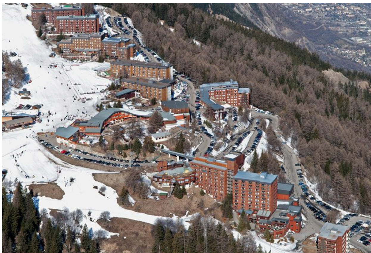
Vue aérienne depuis le sud. Le Foyer la Turra au centre, à droite
