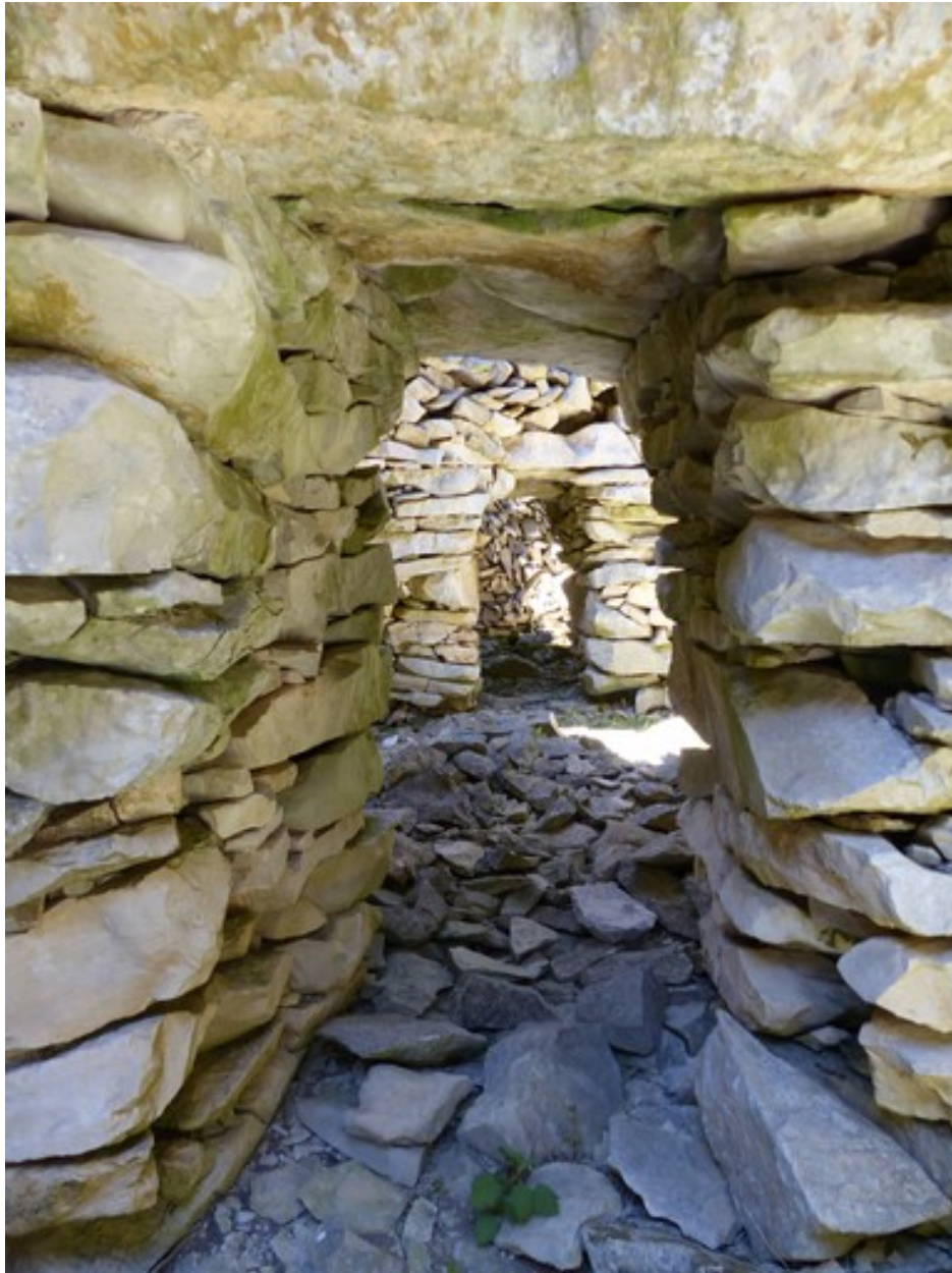
Vue des portes, en enfilade depuis la travée est.
