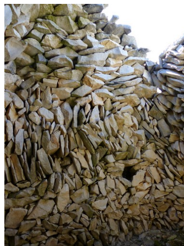
Travée ouest. Mur sud, coupole encorbellée sur départ clavé. Phot. Alexei Laurent IVR84_20162601226NUCA
