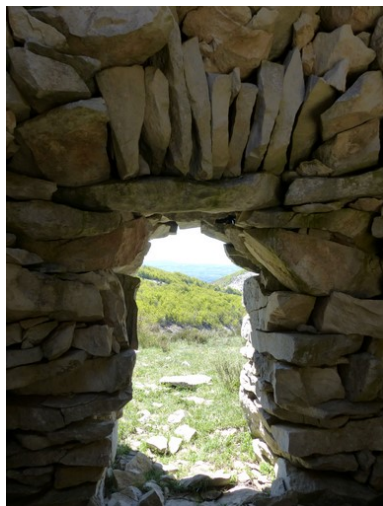
Travée centrale. Mur sud, porte. Phot. Alexei Laurent IVR84_20162601221NUCA
