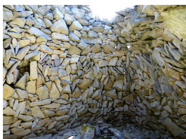
Travée est. Angle sud-est, coupole encorbellée sur maçonnerie clavée. Phot. Alexei Laurent IVR84_20162601227NUCA
