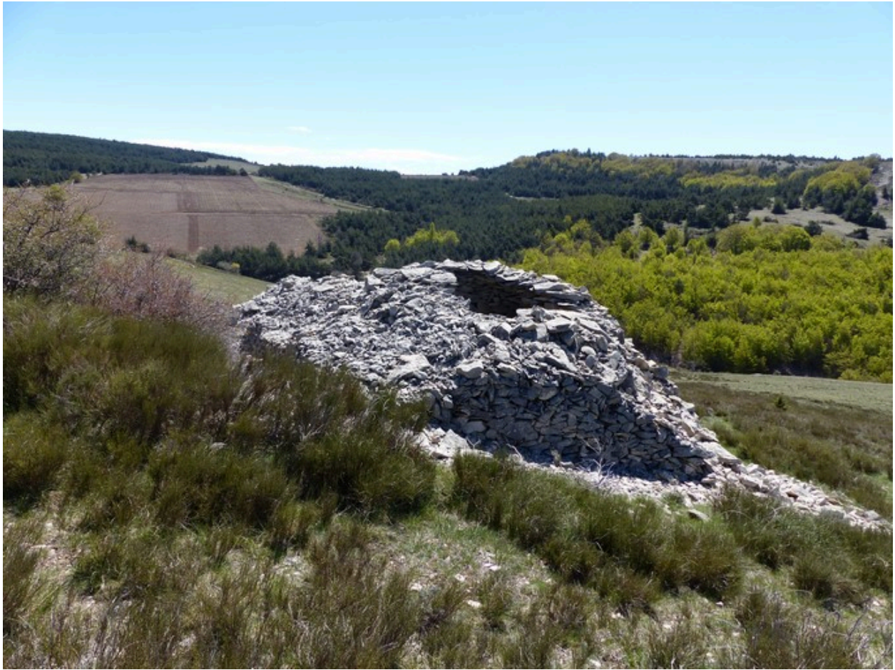
Vue d'ensemble prise du nord-ouest.
