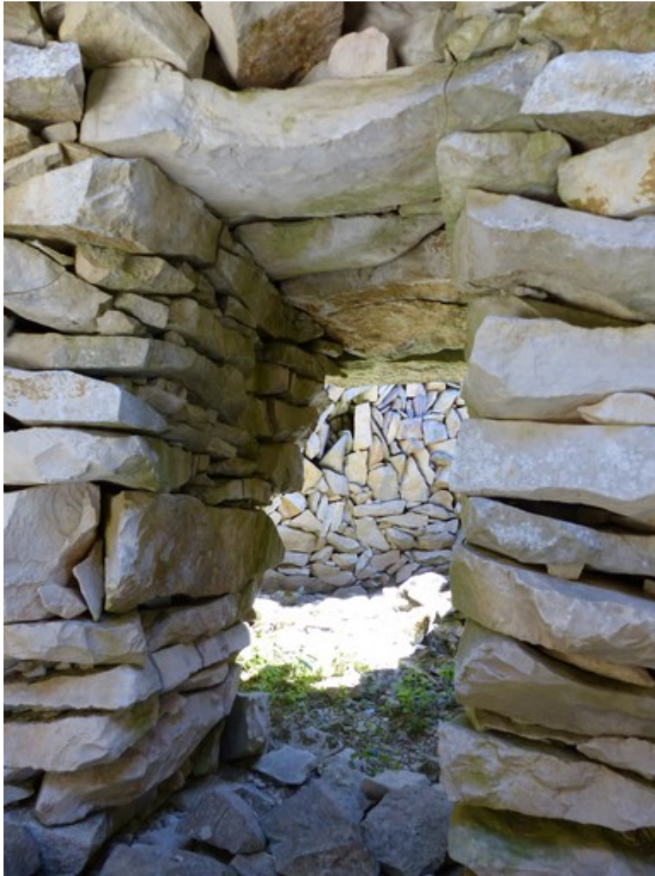
Travée centrale. Mur est, porte.
