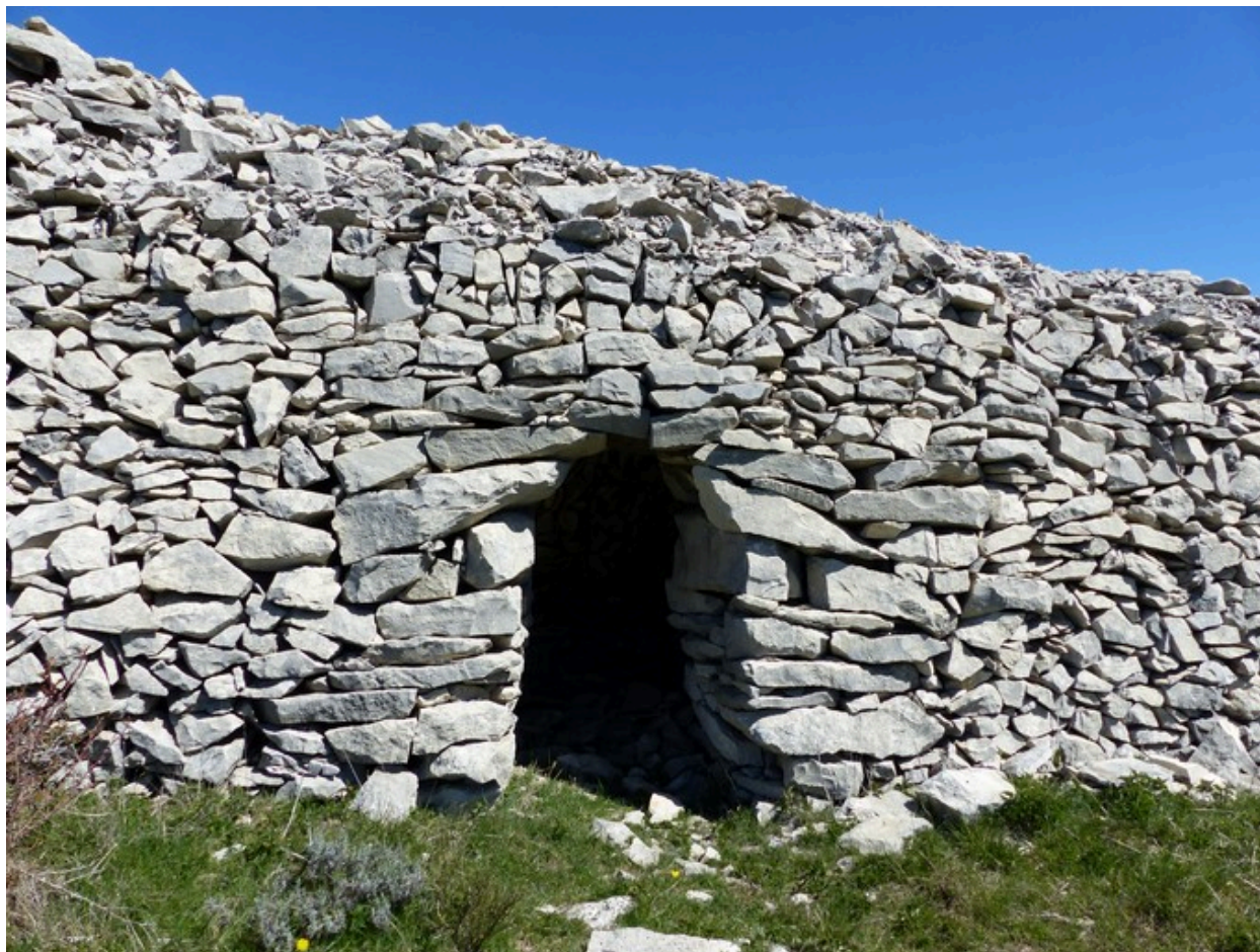
Elévation sud, partie centrale.
