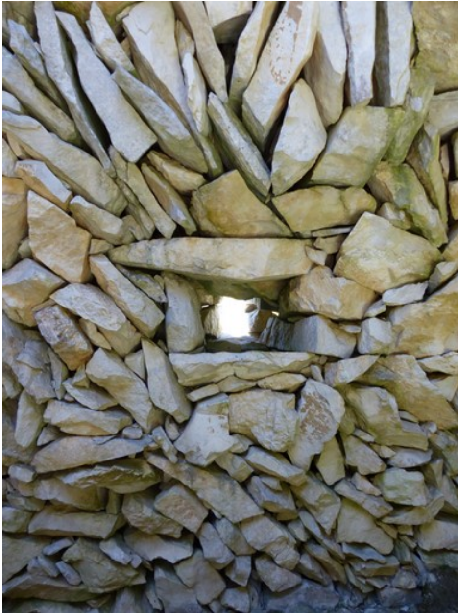
Travée est. Mur sud, jour.
