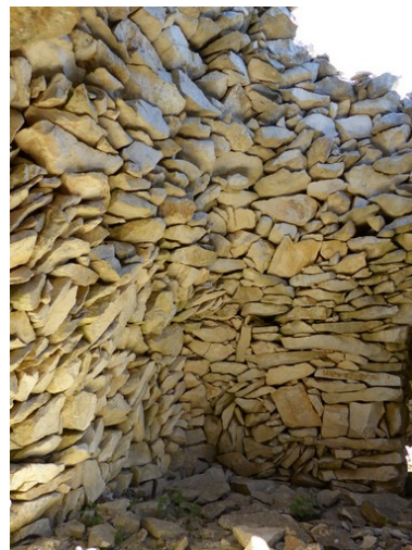
Travée centrale. Angle nord- est, coupole encorbellée sur maçonnerie clavée. Phot. Alexei Laurent IVR84_20162601223NUCA
