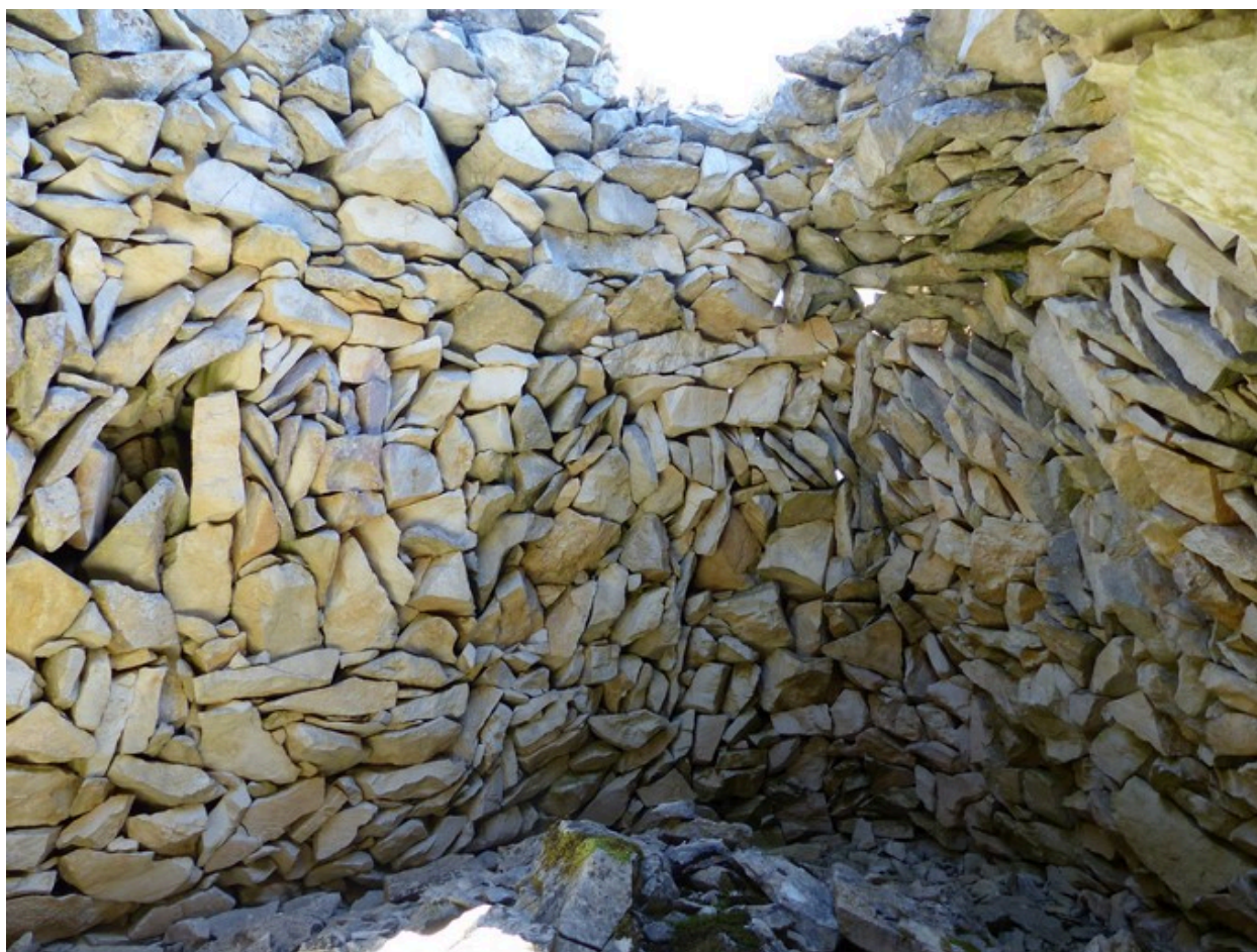
Travée est. Angle sud-est, coupole encorbellée sur maçonnerie clavée.
