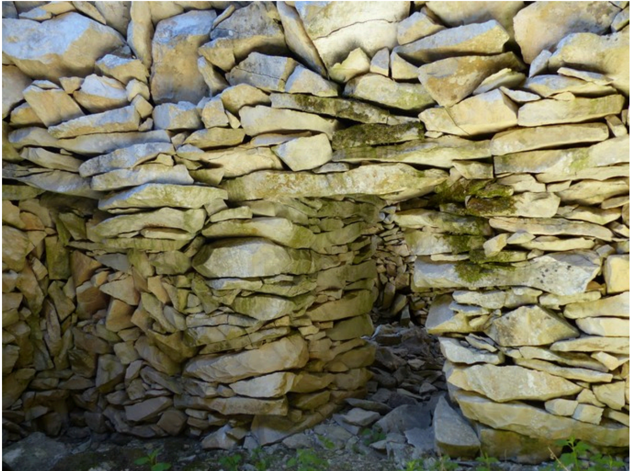
Travée est. Mur ouest.
