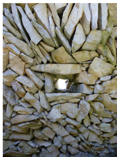
Travée ouest. Mur sud, coupole encorbellée sur départ clavé. Phot. Alexei Laurent IVR84_20162601226NUCA
