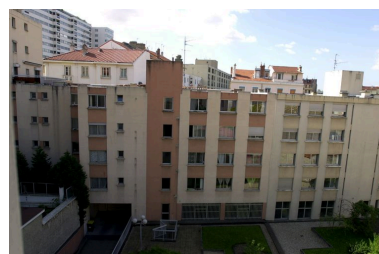
Élévation postérieure du corps de bâtiment rue Rachais Phot. Maryannick Chalabi IVR82_20076902060NUCA
