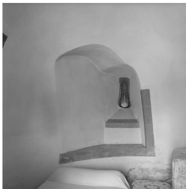
Tour ouest, détail d'une archère-canonnrière.
