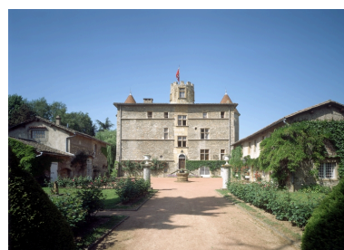
Elévation antérieure sur cour, et communs. Phot. Eric Dessert IVR82_19920100510PA
