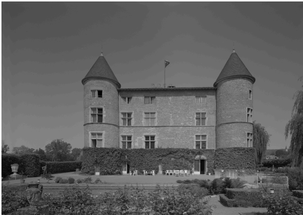
Elévation postérieure sur le parc.
