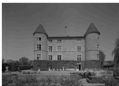
Elévation postérieure sur le parc. Phot. Eric Dessert IVR82_19920100512P
