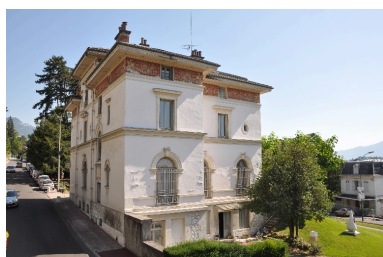
Vue générale depuis le nord Phot. François Fouger IVR82_20127300096NUCA
