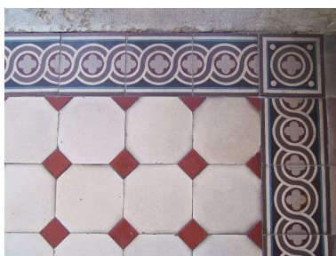
Détail du carrelage du hall Phot. François Fouger IVR82_20067300466NUCA
