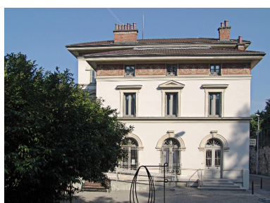
Elévation latérale sud Phot. François Fouger IVR82_20057300624NUCA
