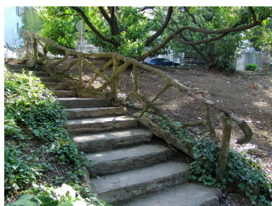
Escalier isolé Phot. François Fouger IVR82_20067300464NUCA
