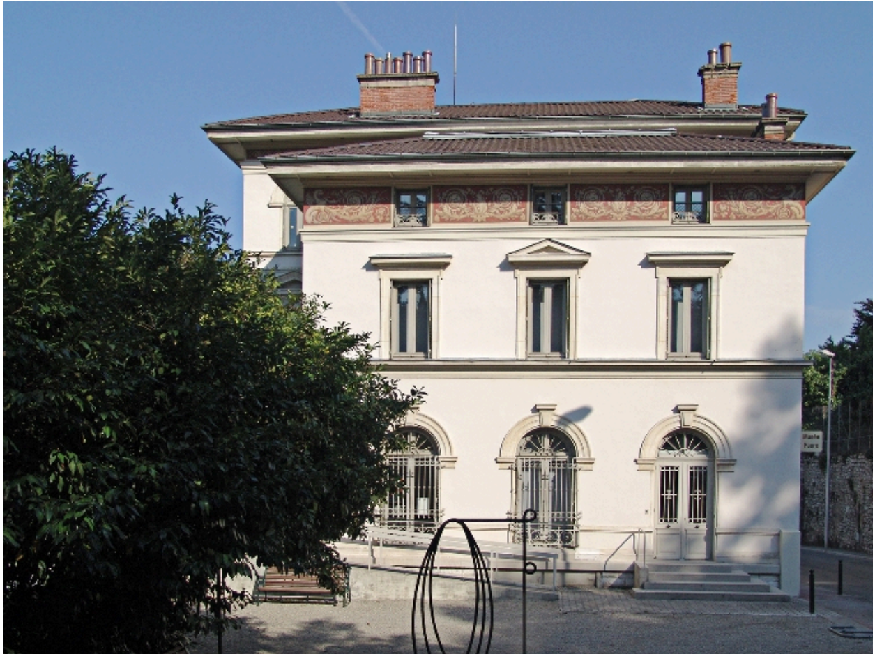
Elévation latérale sud
