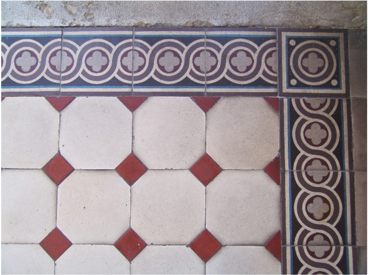
Détail du carrelage du hall
