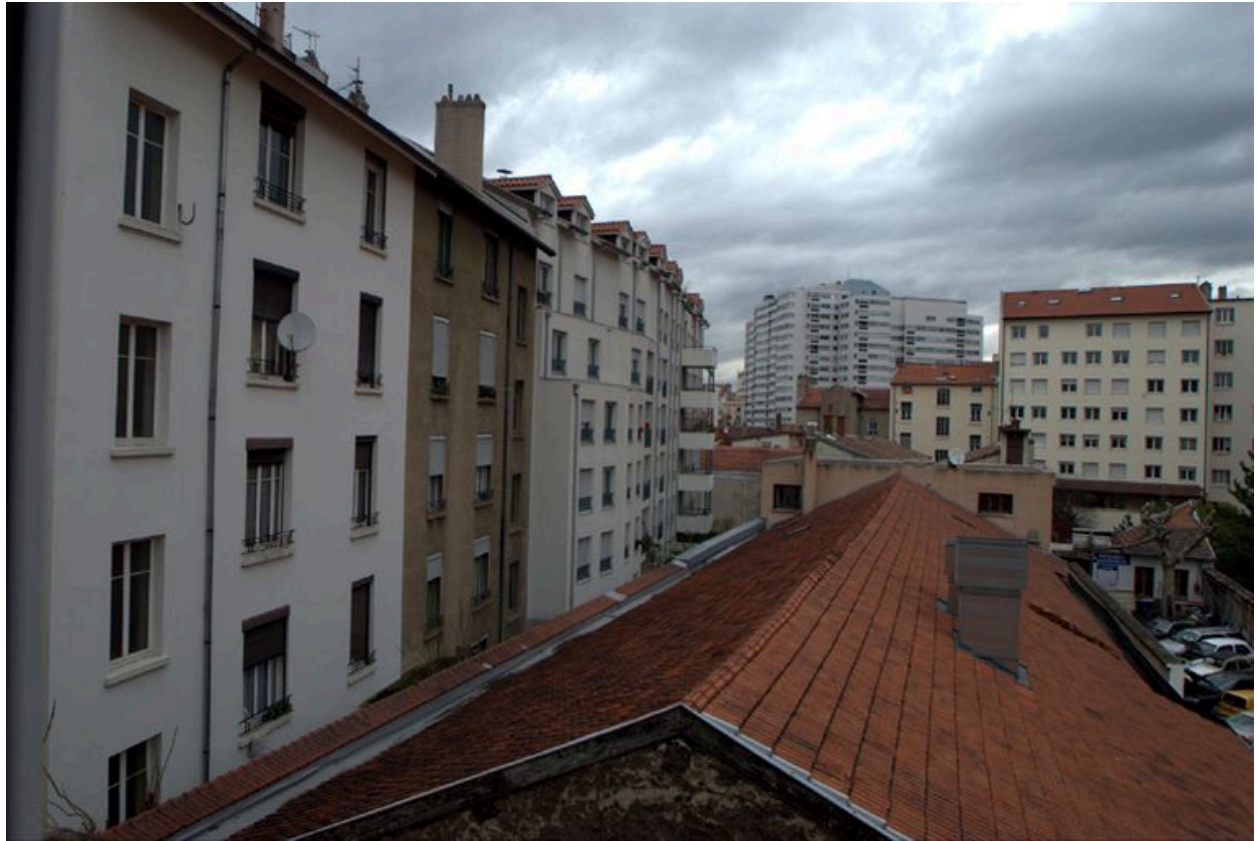
Vue de la toiture du bâtiment sud-ouest prolongé par le logement couvert d'un toit terrasse
