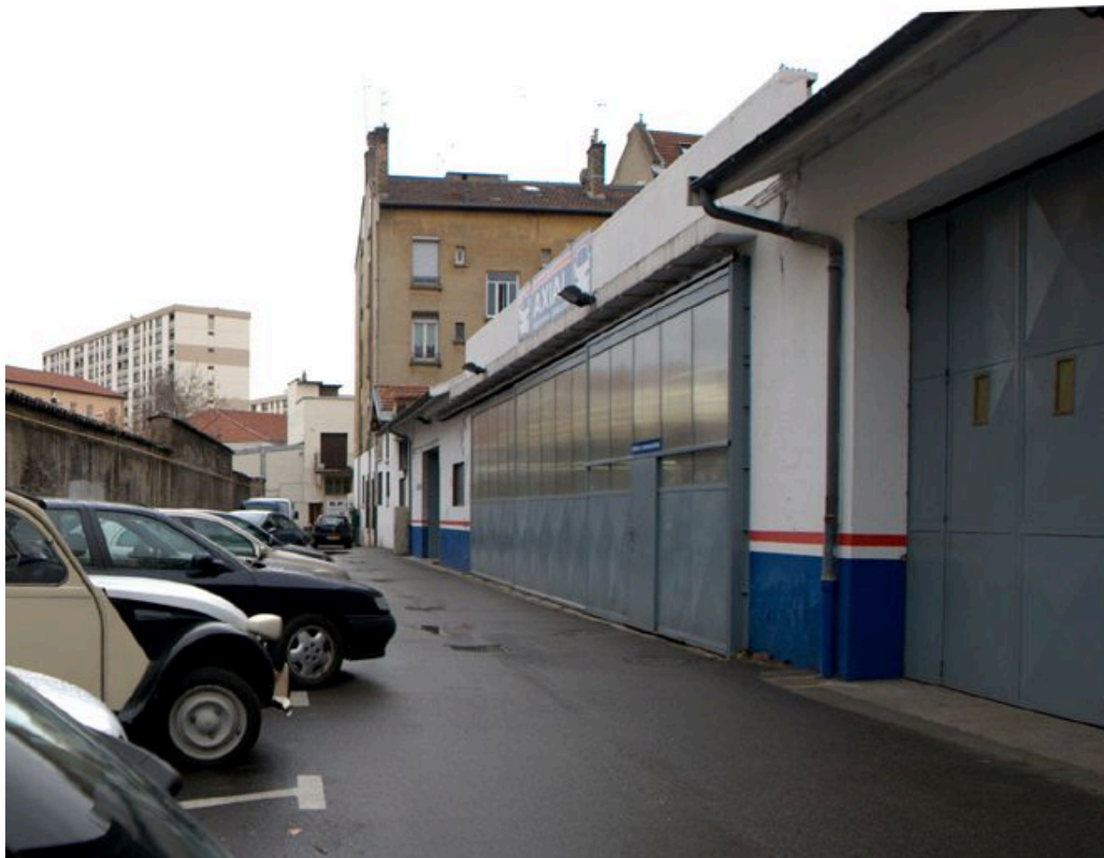
Vue générale des ateliers depuis le nord-est
