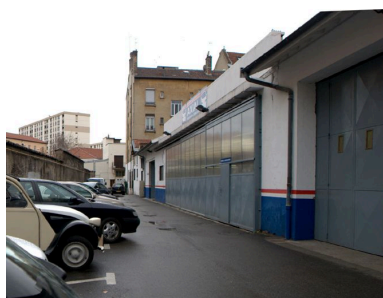
Vue générale des ateliers depuis le nord-est Phot. Maryannick Chalabi IVR82_20096901264NUCA
