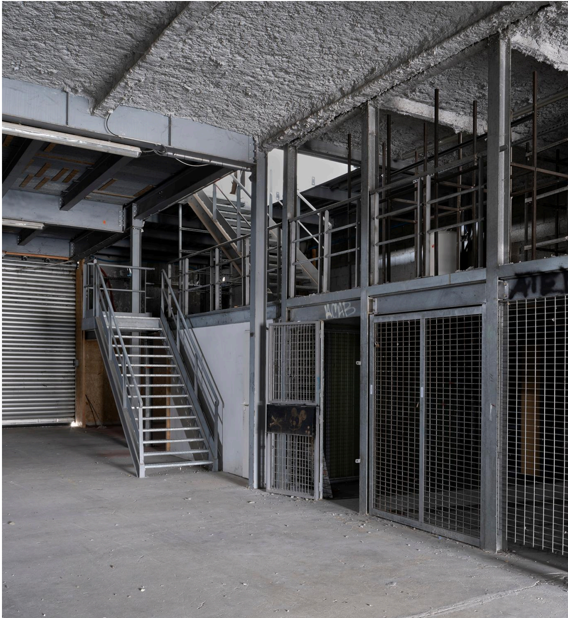
Vue intérieure niveau rez-de-chaussée
