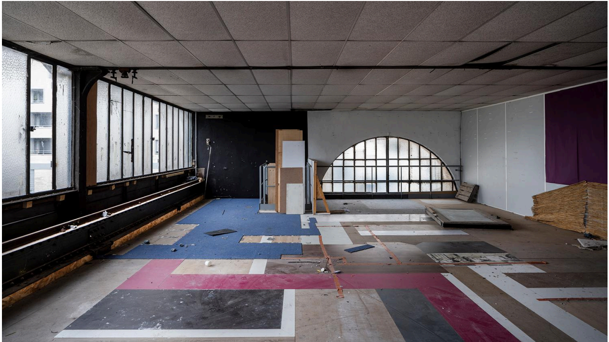
Vue intérieure niveau supérieur : détail baie avant démolition
