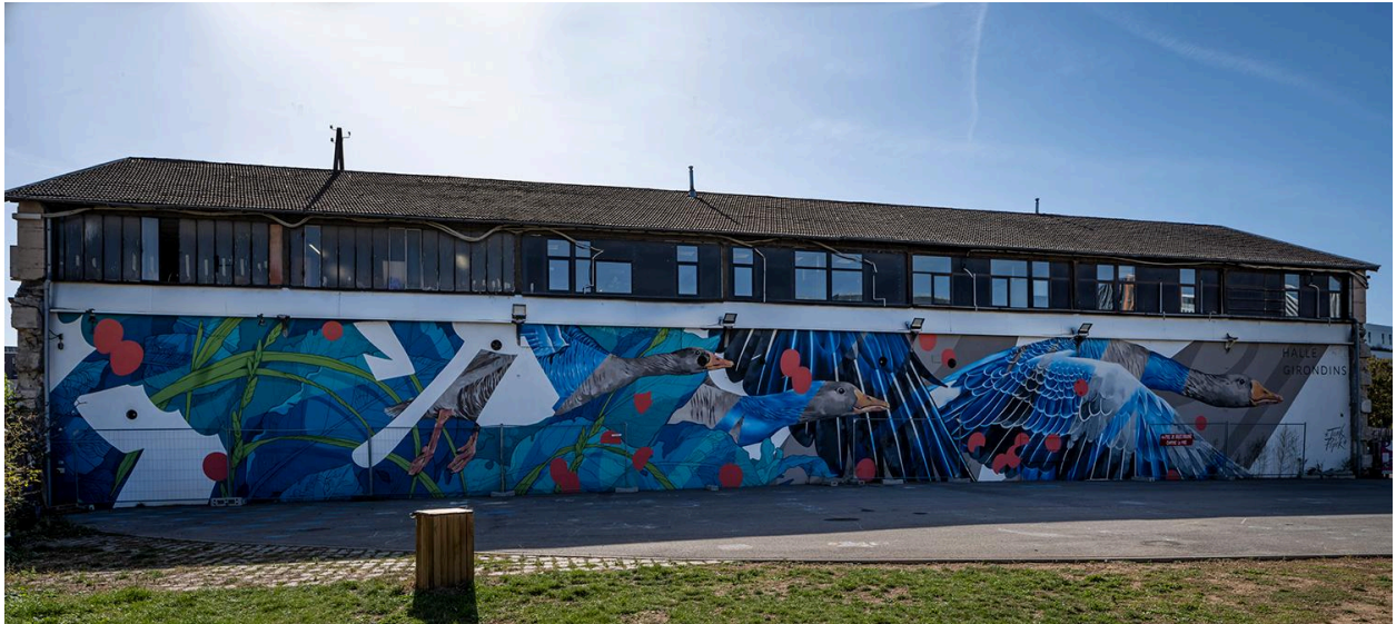
Façade ouest de la halle des Ets Weitz dite des Girondins
