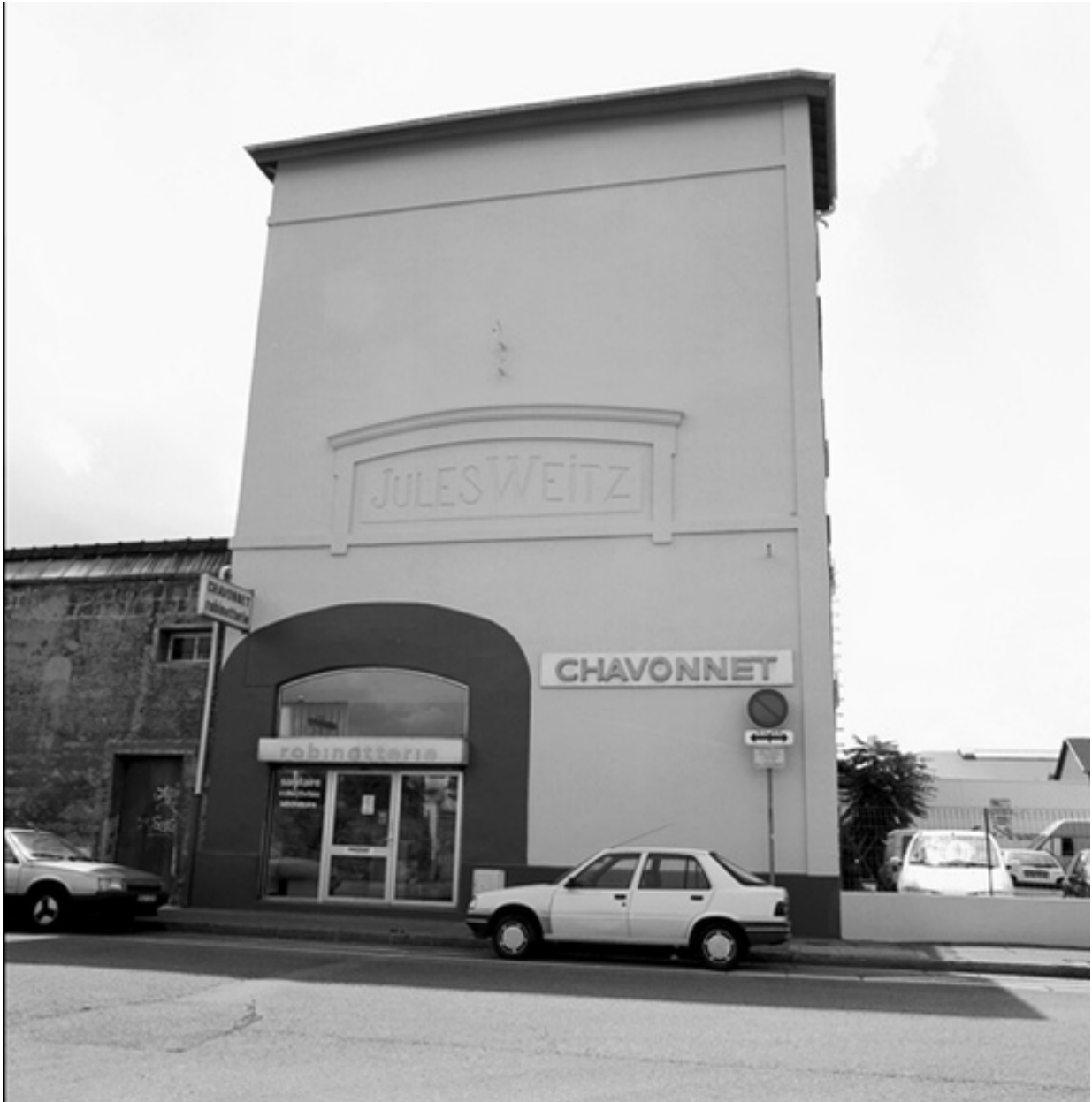
Vue générale façade nord
