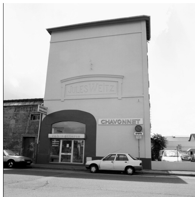
Vue générale façade nord Phot. Martial Couderette IVR82_20016903033X
