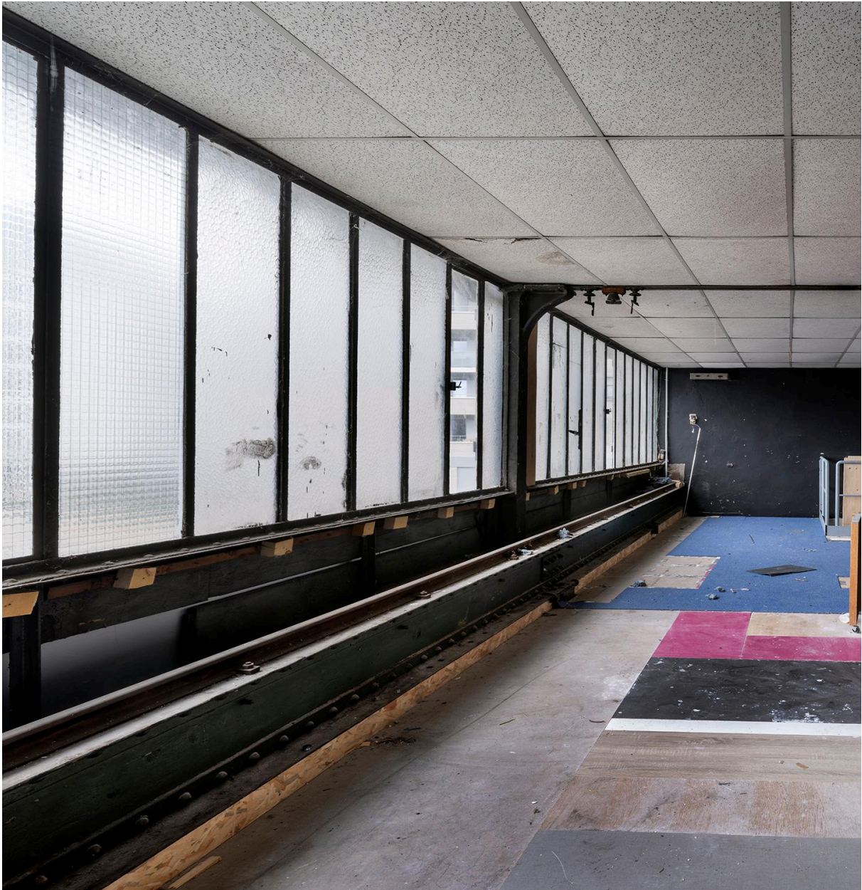
Vue intérieur niveau supérieur avant démolition
