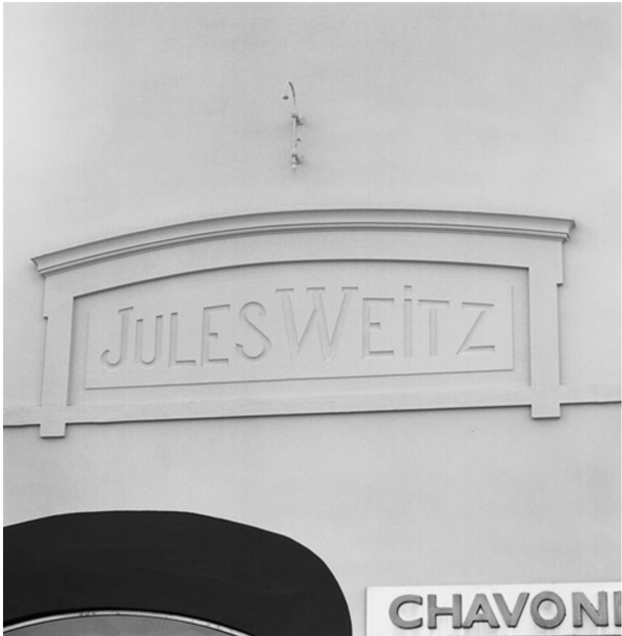
Détail façade enseigne
