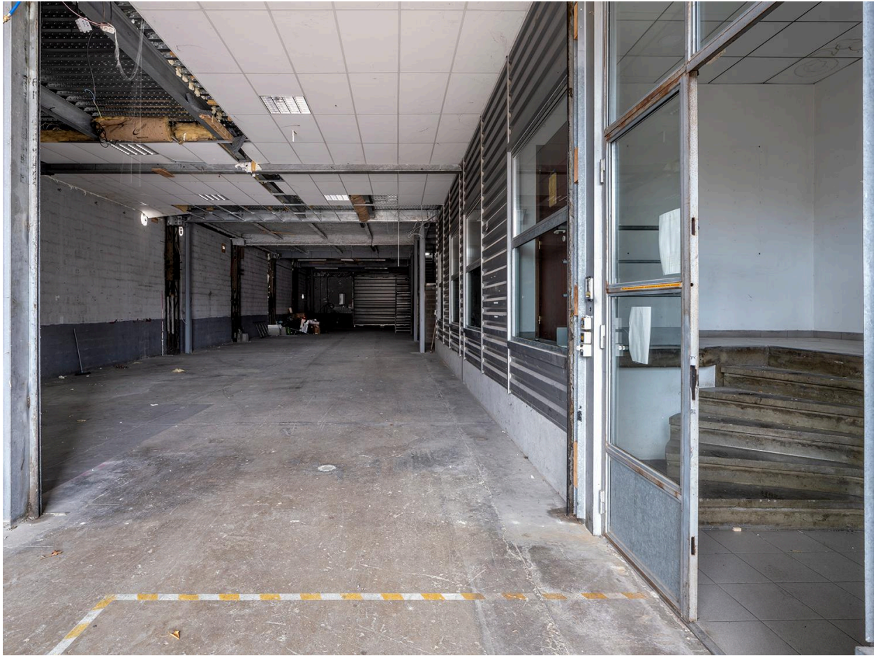
Vue intérieure avant démolition
