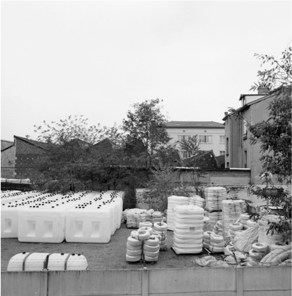
Vue façade nord-est
