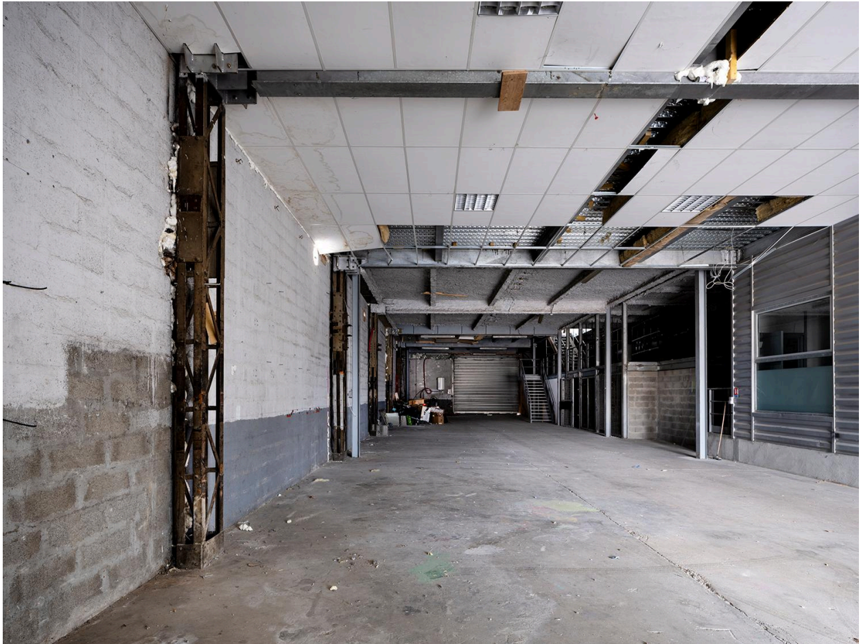
Vue intérieure avant démolition
