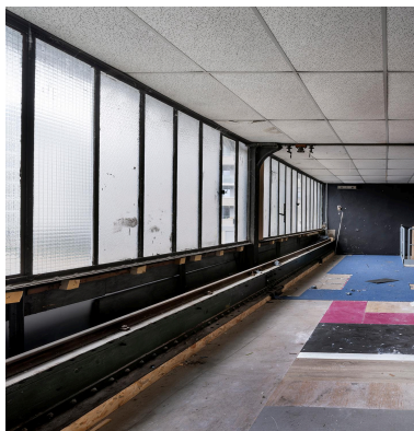
Vue intérieur niveau supérieur avant démolition Phot. Michel Pérès IVR84_20236900602NUCAQ
