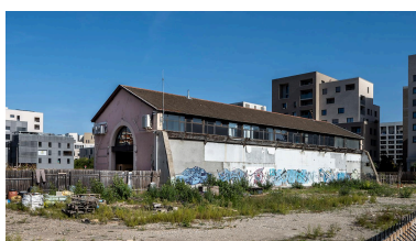
Vue sud-est de la halle des Ets Weitz dite des Girondins Phot. Michel Pérès IVR84_20236900548NUCA
