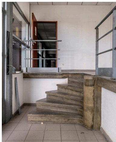
Escalier intérieur Phot. Michel Pérès IVR84_20236900605NUCA
