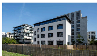
Ancien bâtiment administratif des Ets Weitz reconverti en bureaux Phot. Michel Pérès IVR84_20236900547NUCA
