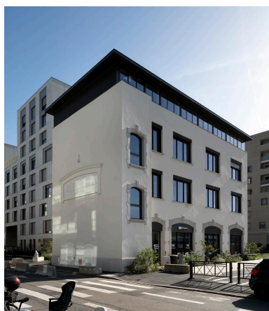
Ancien bâtiment administratif des Ets Weitz reconverti en bureaux Phot. Michel Pérès IVR84_20236900549NUCA
