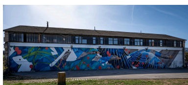
Façade ouest de la halle des Ets Weitz dite des Girondins Phot. Michel Pérès IVR84_20236900546NUCA
