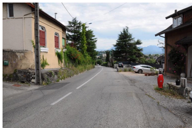
Vue vers le sud, à mi-parcours Phot. Denys Harreau IVR82_20147301196NUCA
