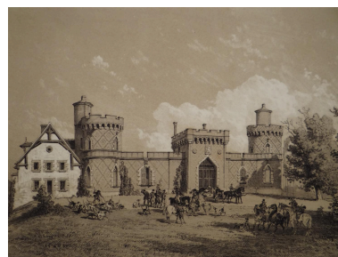
Détail Phot. Lionel Sauzade IVR84_20216301006NUCA
