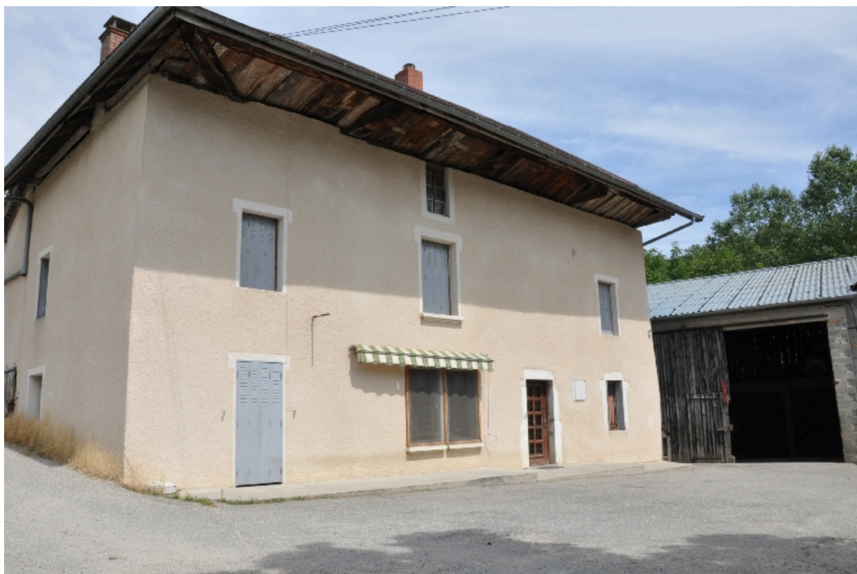
Vue générale, façade sud de l'aile occupée par un logement
