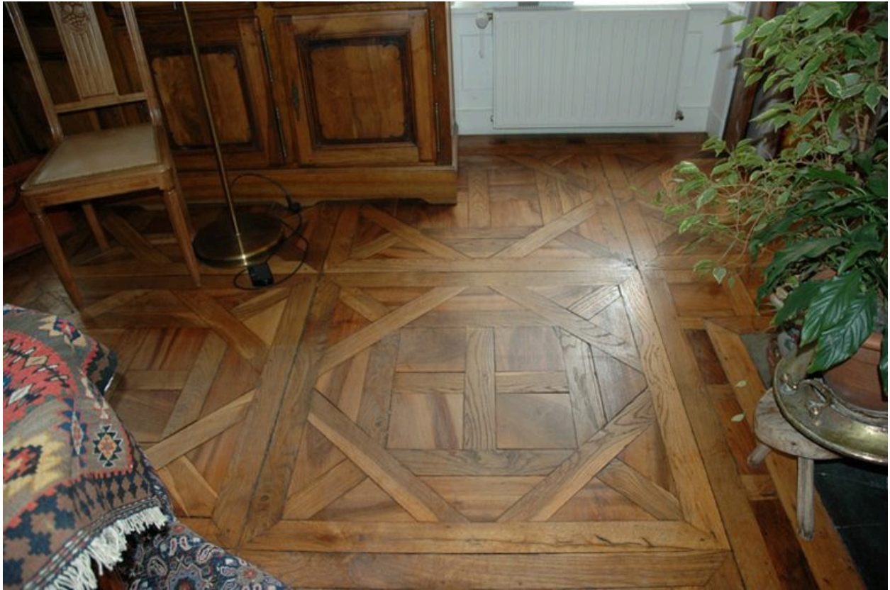
Parquet d'Aremberg situé dans l'un des appartements : les traverses sont en chêne et le remplissage en noyer
