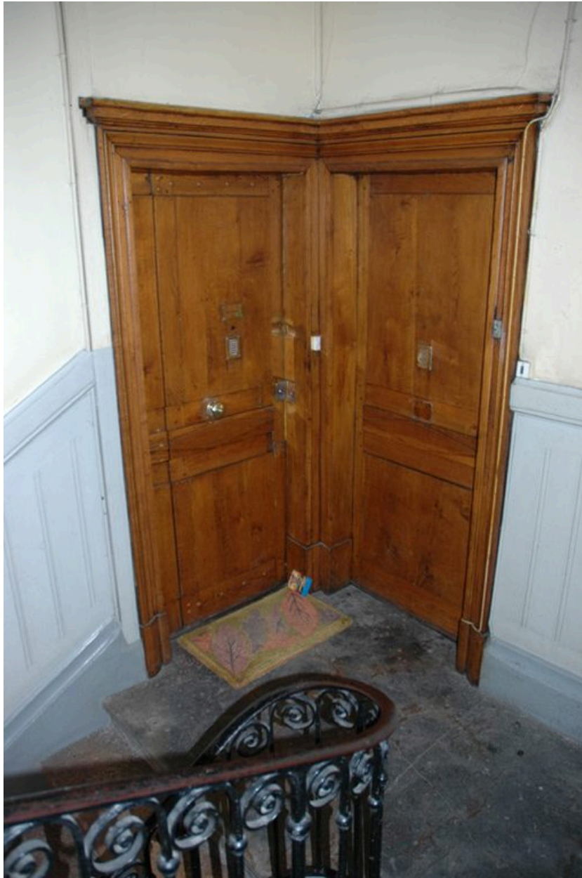
Portes palières jumelées dans l'angle
