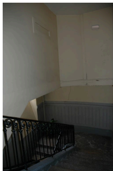
Cage d'escalier : dernier étage Phot. Véronique Belle IVR82_20066902691NUCA
