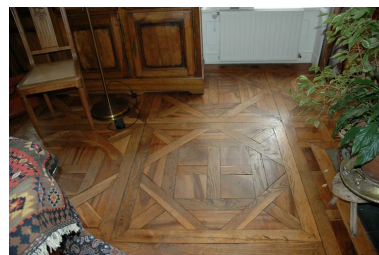
Parquet d'Aremberg situé dans l'un des appartements : les traverses sont en chêne et le remplissage en noyer Phot. Véronique Belle IVR82_20066902695NUCA
