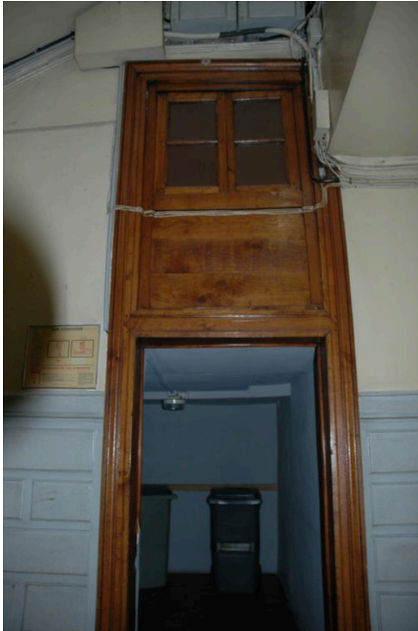
Entrée de la loge de concierge servant actuellement de local poubelles
