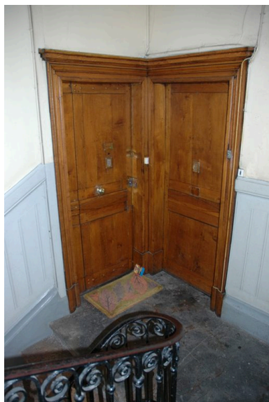
Portes palières jumelées dans l'angle Phot. Véronique Belle IVR82_20066902689NUCA
