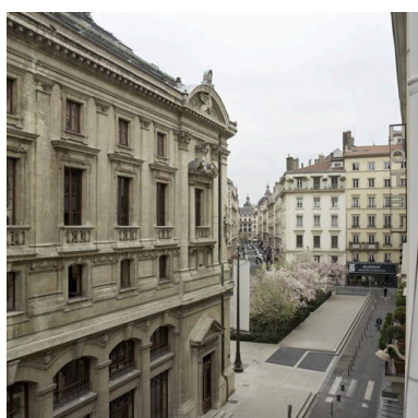
Vue de situation depuis la rue Gaspard-André (premier immeuble à partir de la droite)
