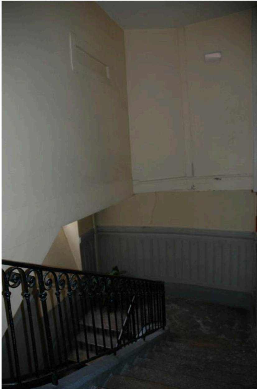
Cage d'escalier : dernier étage
