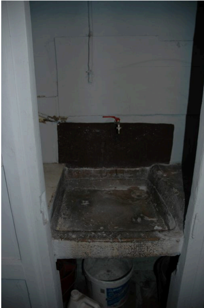
Evier situé dans l'ancienne loge de concierge
