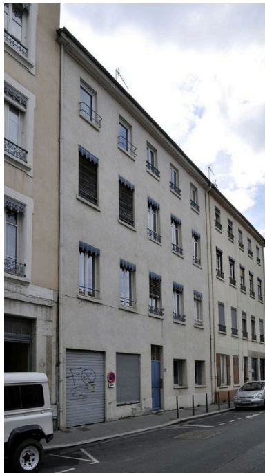
Vue générale Phot. Julien Defillon IVR82_20106900943NUCA
