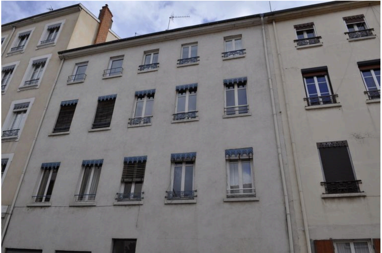
Façade antérieure : baies des étages supérieurs
