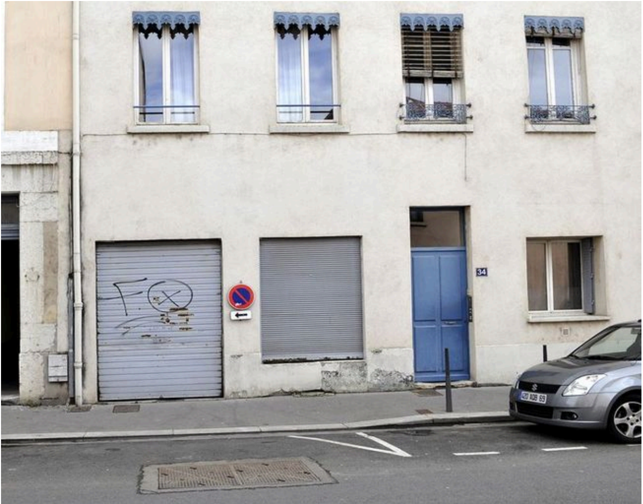
Façade antérieure : rez-de-chaussée et premier étage.
