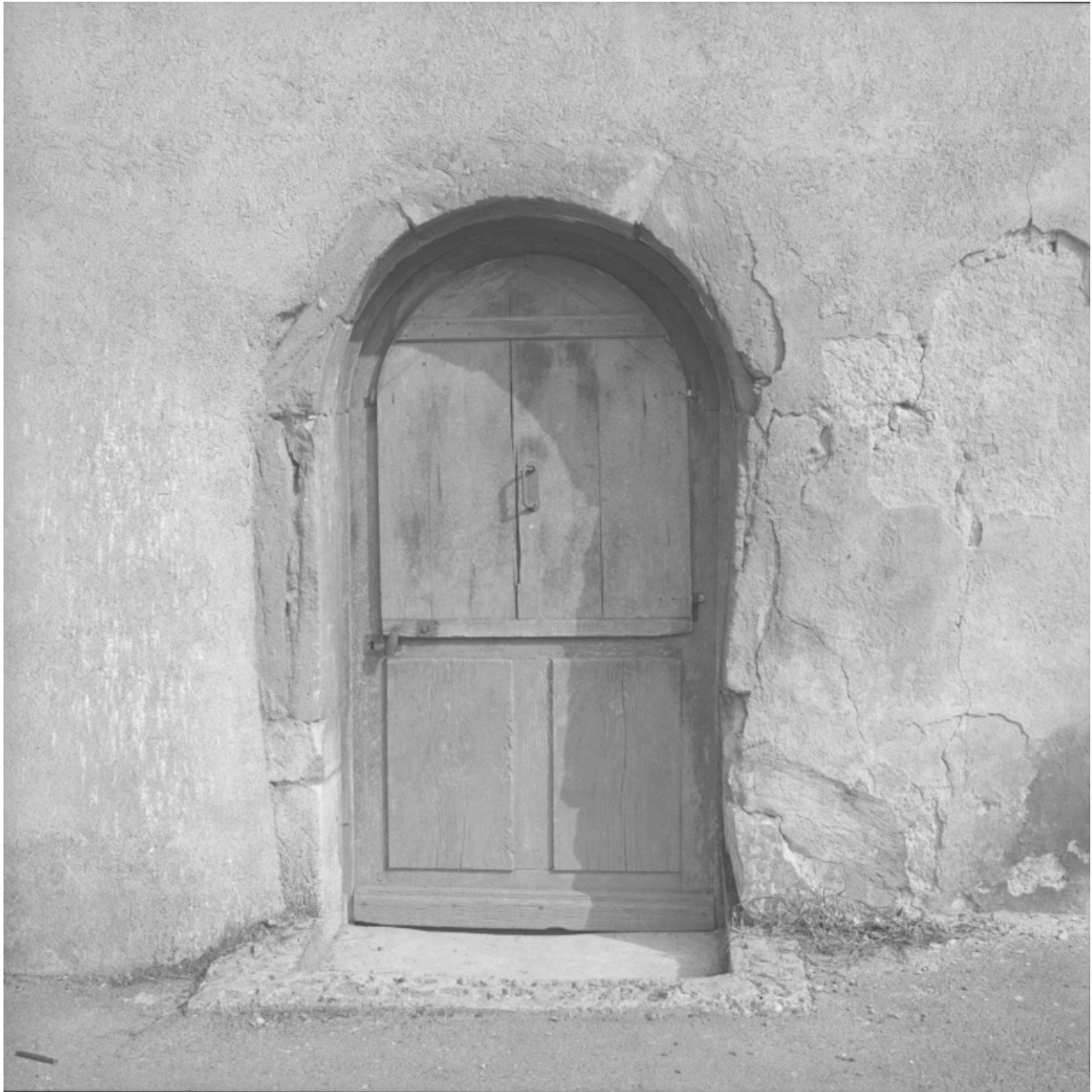
Porte piétonne sur l'élévation principale d'une maison située rue Jules Ferry (parcelle A 83).
