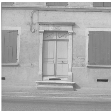
Date 1841 sur le linteau de la porte piétonne (parcelle A 162) Phot. Jean-Marie Refflé IVR82_19870100335X
