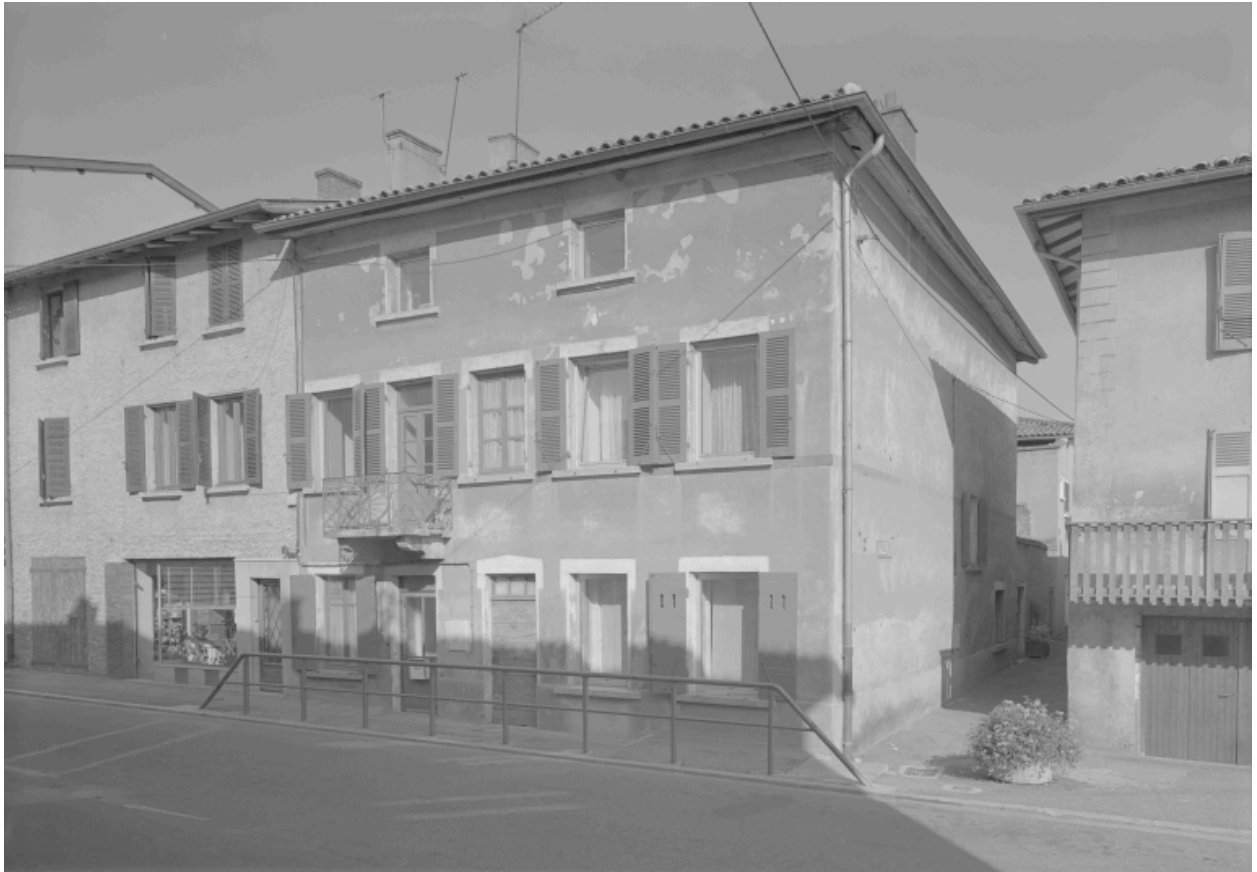
Maison reconstruite après l'inondation de 1840. Porte la date 1842 sur le garde corps en ferronnerie du balcon au 2 e niveau (parcelle A 67-225)
