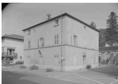
Maison achetée par la municipalité pour servir de Mairie. Vue du sud-ouest, du côté de l'entrée. Phot. Jean-Marie Refflé IVR82_19870100327P
