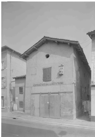
Vierge de pitié en remploi sur la façade d'un édifice public (parcelle A77). Phot. Jean-Marie Refflé IVR82_19870100332P
