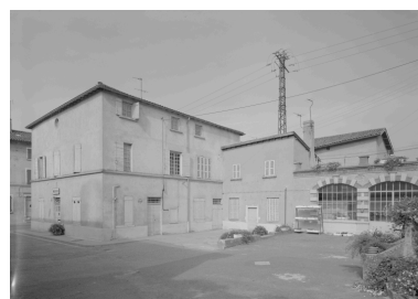
Vue de la Mairie du côté du sud-est. Phot. Jean-Marie Refflé IVR82_19870100328P
