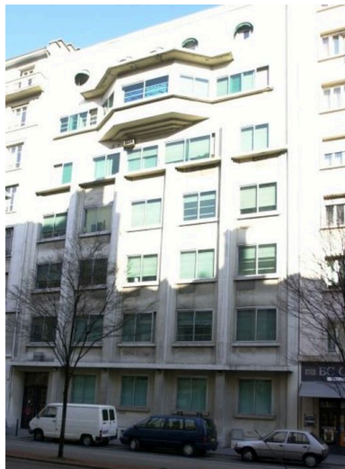
Vue générale de l'élévation sur rue Phot. Maryannick Chalabi IVR82_20046903135NUCA
