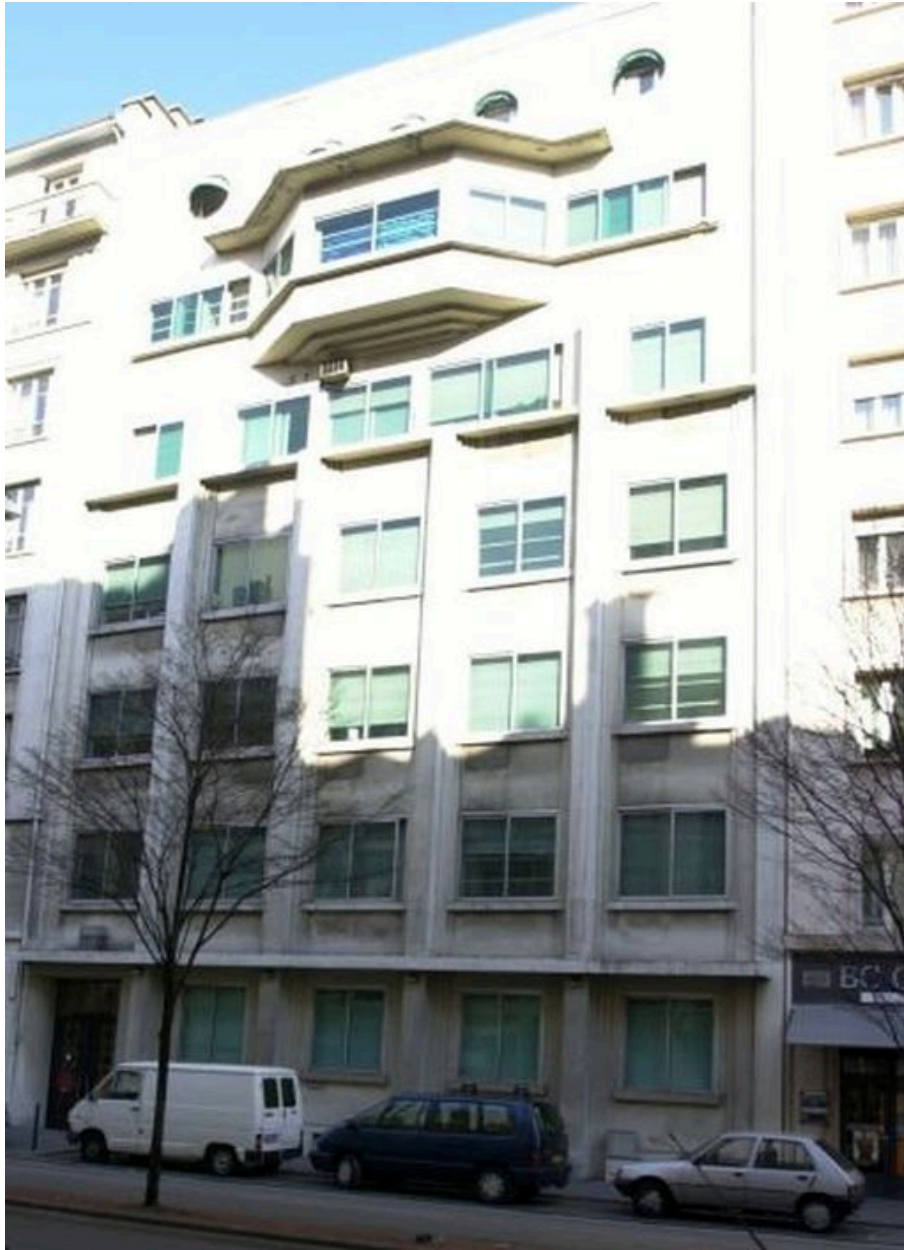
Vue générale de l'élévation sur rue
