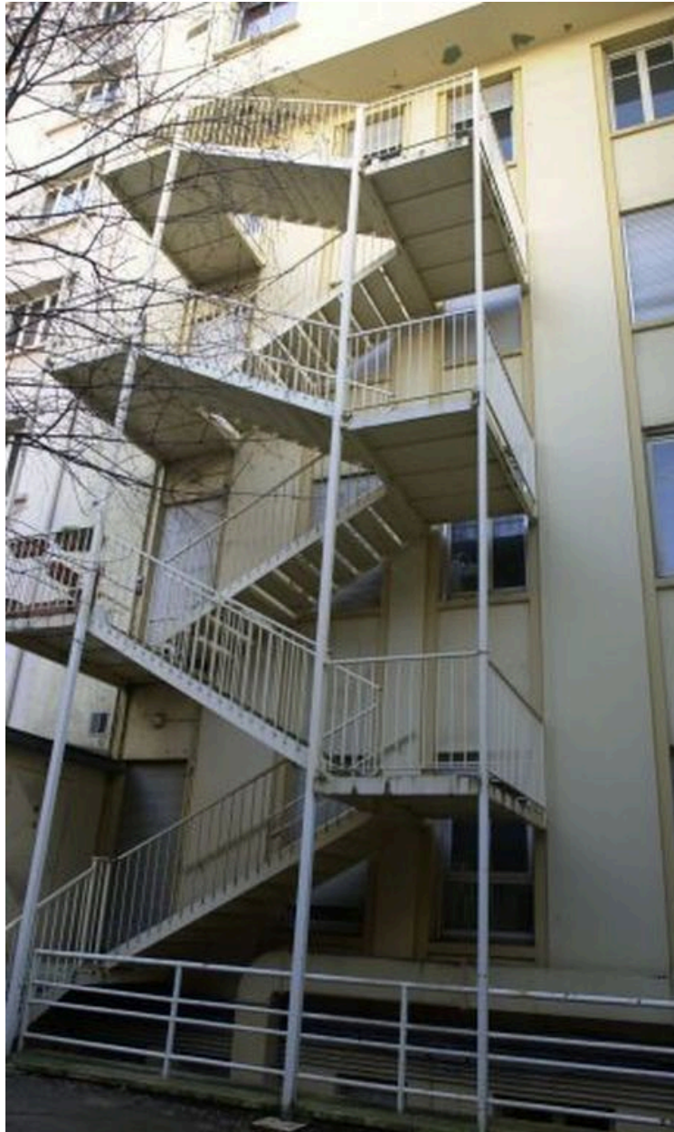
Vue de l'escalier de service en façade postérieure sur cour
