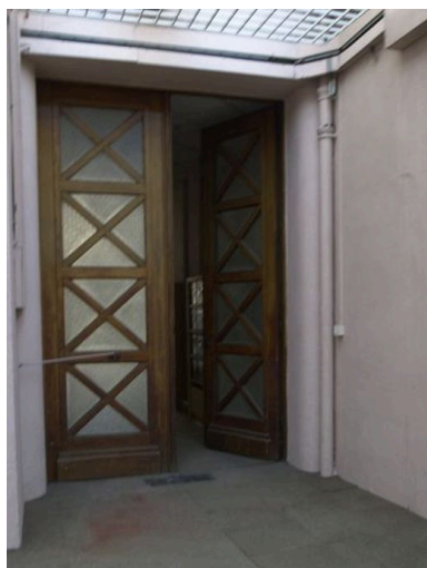
Vue de la porte qui sépare le vestibule d'entrée de la véranda Phot. Maryannick Chalabi IVR82_20046903138NUCA
