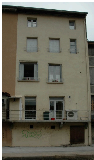
Elévation postérieure sur le quai du Vizézy. Phot. Simone Hartmann-Nussbaum IVR82_20134200549NUCA
