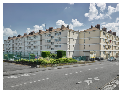
Ensemble collectif n°1, immeubles en bordure de la rue des Planchettes. Phot. Christian Parisey IVR84_20206300911NUC4A
