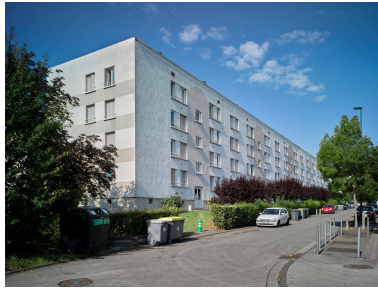
Immeuble collectif n°2 rue de la Fontcimagne, vu depuis le nord-est. Phot. Christian Parisey IVR84_20206300902NUC4A
