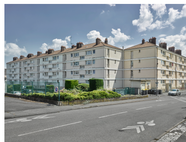
Ensemble collectif n°1, immeubles en bordure de la rue des Planchettes. Phot. Christian Parisey IVR84_20206300911NUC4A
