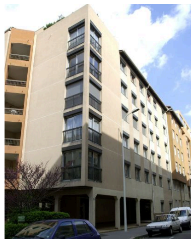
Elévation rue Delandine depuis le sud Phot. Chantal Archer-Galéa IVR82_20016901749NUCA
