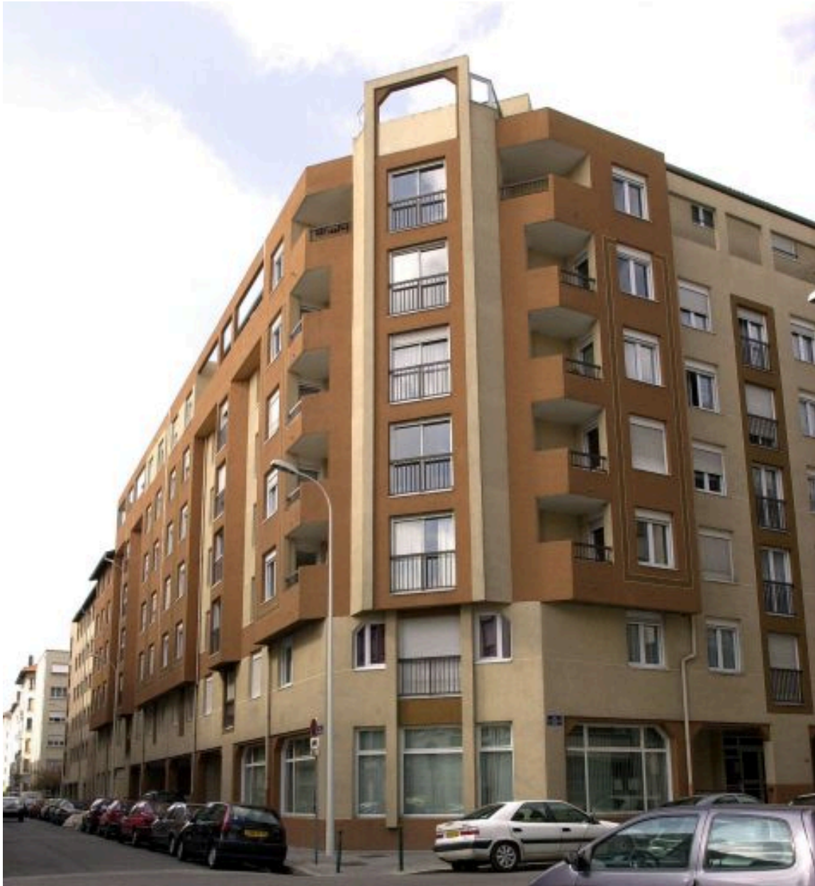
Elévation rue Delandine depuis le nord
