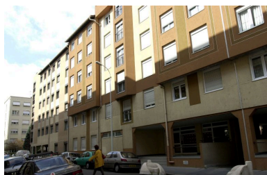
Elévation rue Delandine depuis le nord Phot. Chantal Archer-Galéa IVR82_20016901747NUCA
