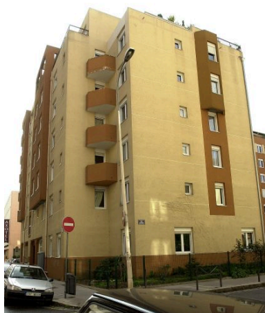
Elévation à l'angle des rues Quivogne et Marc-Antoine- Petit depuis le nord-ouest Phot. Chantal Archer-Galéa IVR82_20016901744NUCA
