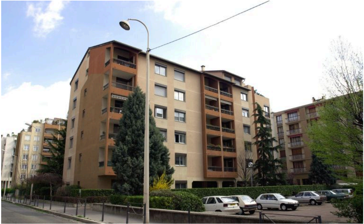
Vue d'ensemble rue Quivogne depuis le sud
