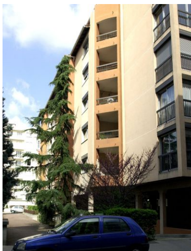
Elévation rue Quivogne Phot. Chantal Archer-Galéa IVR82_20016901748NUCA
