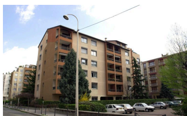
Vue d'ensemble rue Quivogne depuis le sud Phot. Chantal Archer-Galéa IVR82_20016901753NUCA
