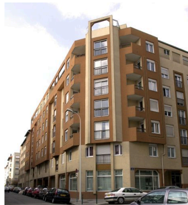
Elévation rue Delandine depuis le nord Phot. Chantal Archer-Galéa IVR82_20016901746NUCA
