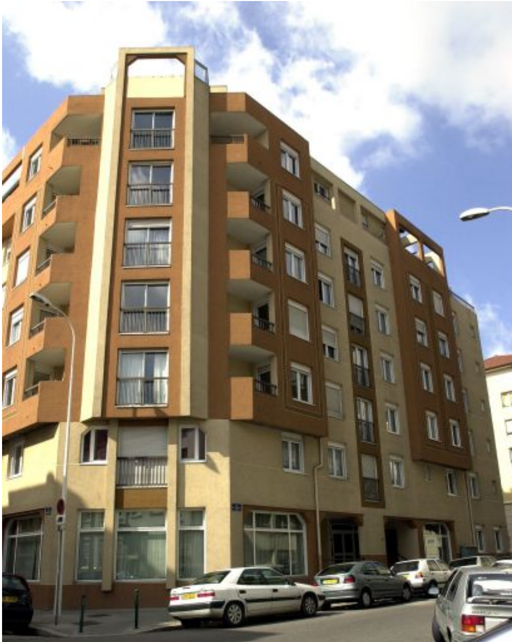
Elévation à l'angle des rues Delandine et Marc-Antoine-Petit depuis le nord-est
