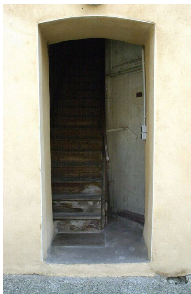
Corps de bâtiment est : entrée vers l'escalier Phot. Maryannick Chalabi IVR82_20096901164NUCA
