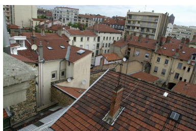
Façade postérieure depuis le sud-est Phot. Maryannick Chalabi IVR82_20096901117NUCA
