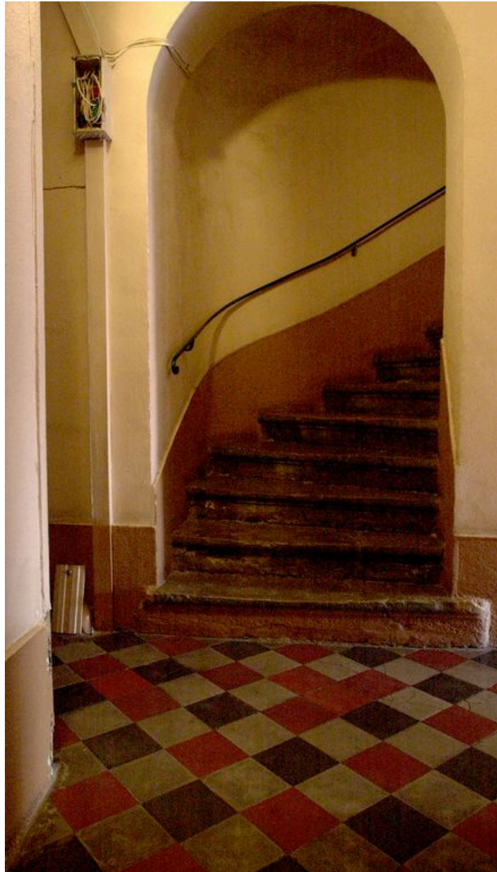
Vue de l'escalier, au niveau du 1er étage
