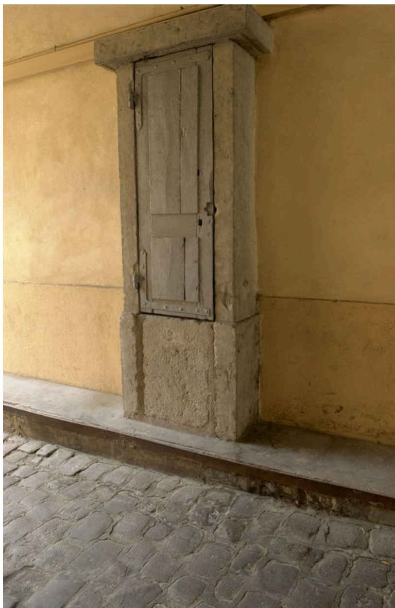
Vue du puits construit sous le passage cocher
