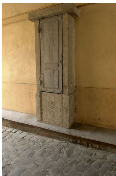
Vue du puits construit sous le passage cocher Phot. Maryannick Chalabi IVR82_20096901166NUCA
