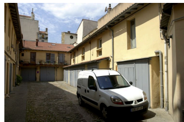
Le corps de bâtiment ouest et le bâtiment en fond de cour Phot. Maryannick Chalabi IVR82_20096901162NUCA
