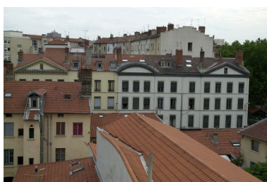
Elévation postérieure depuis le sud Phot. Maryannick Chalabi IVR82_20096901149NUCA
