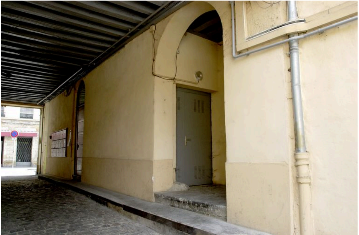
Entrée ouvrant sur l'escalier, sous le passage couvert
