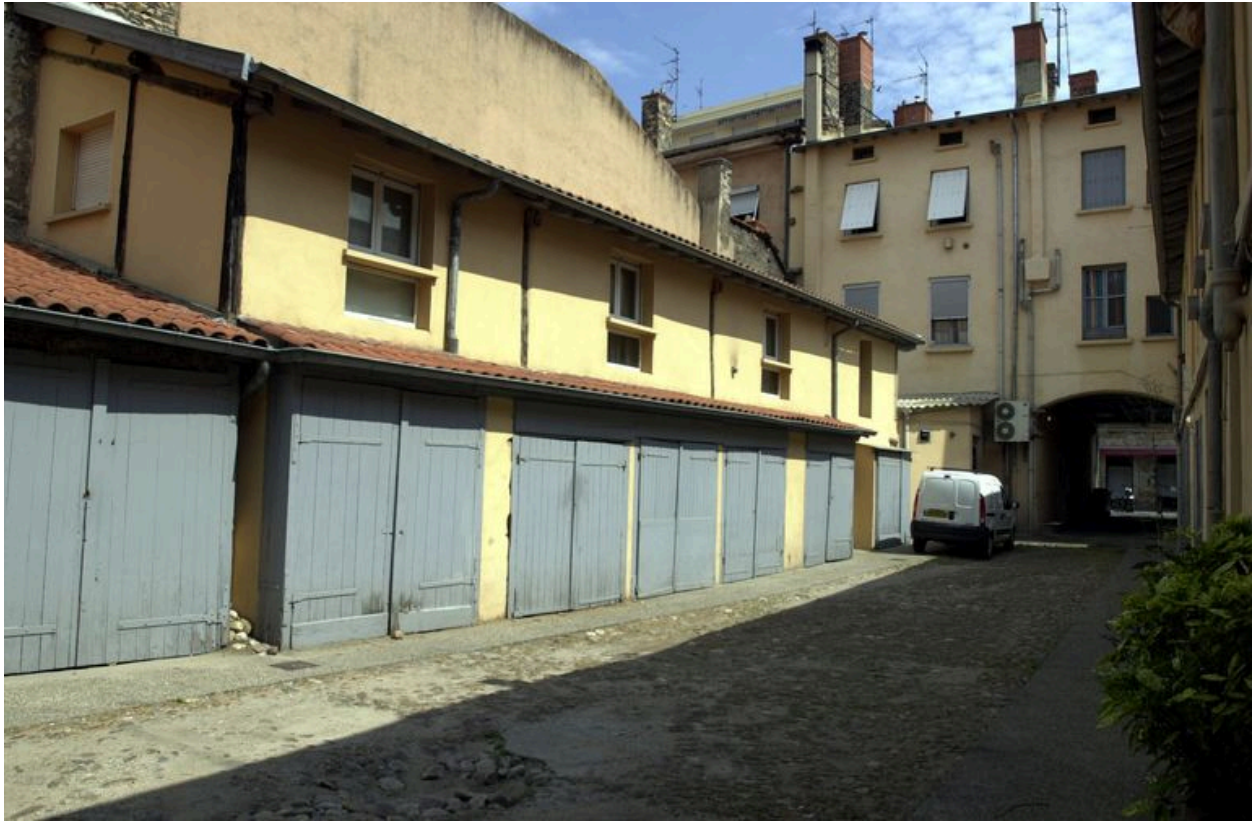
Le corps de bâtiment ouest et l'élévation postérieure du bâtiment sur rue
