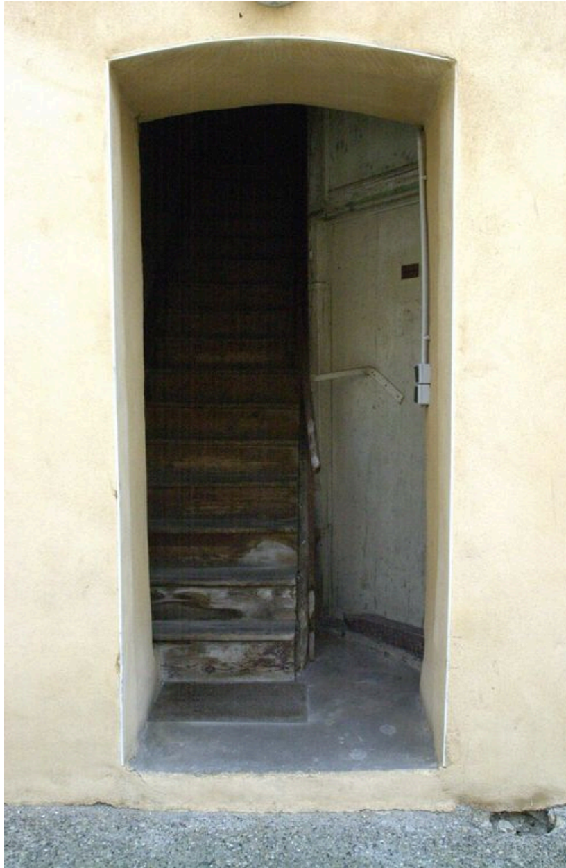
Corps de bâtiment est : entrée vers l'escalier
