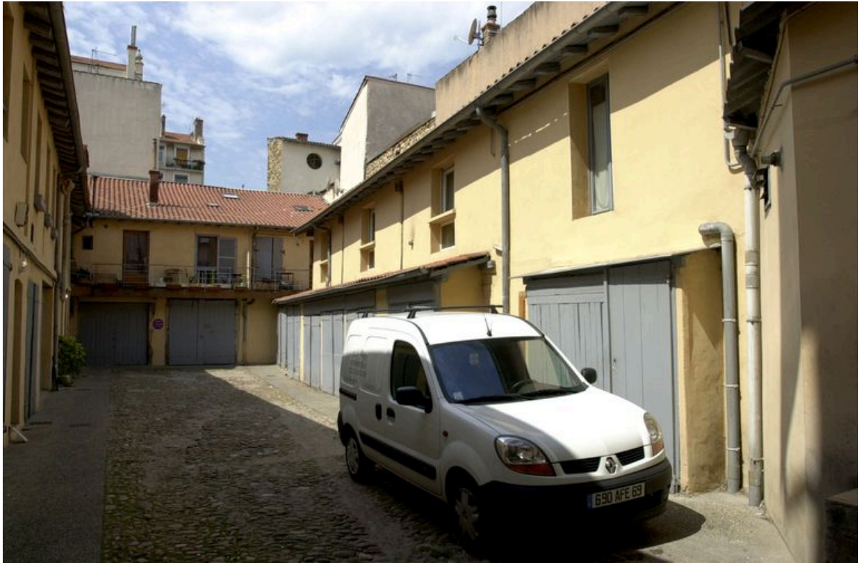
Le corps de bâtiment ouest et le bâtiment en fond de cour
