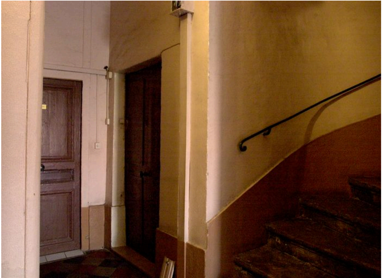
L'escalier et les portes palières du 1er étage
