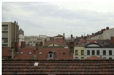
Vue de toiture depuis le sud Phot. Maryannick Chalabi IVR82_20096901150NUCA
