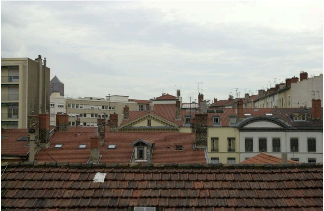
Vue de toiture depuis le sud
