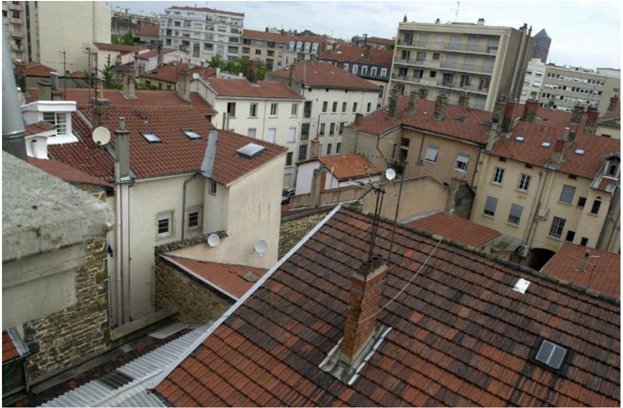
Façade postérieure depuis le sud-est
