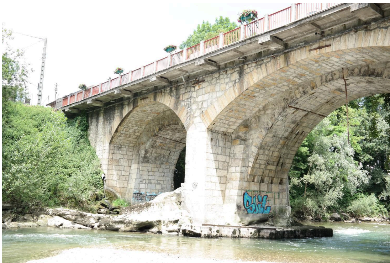
Pont de Tasset, détail des voûtes et de la pile
