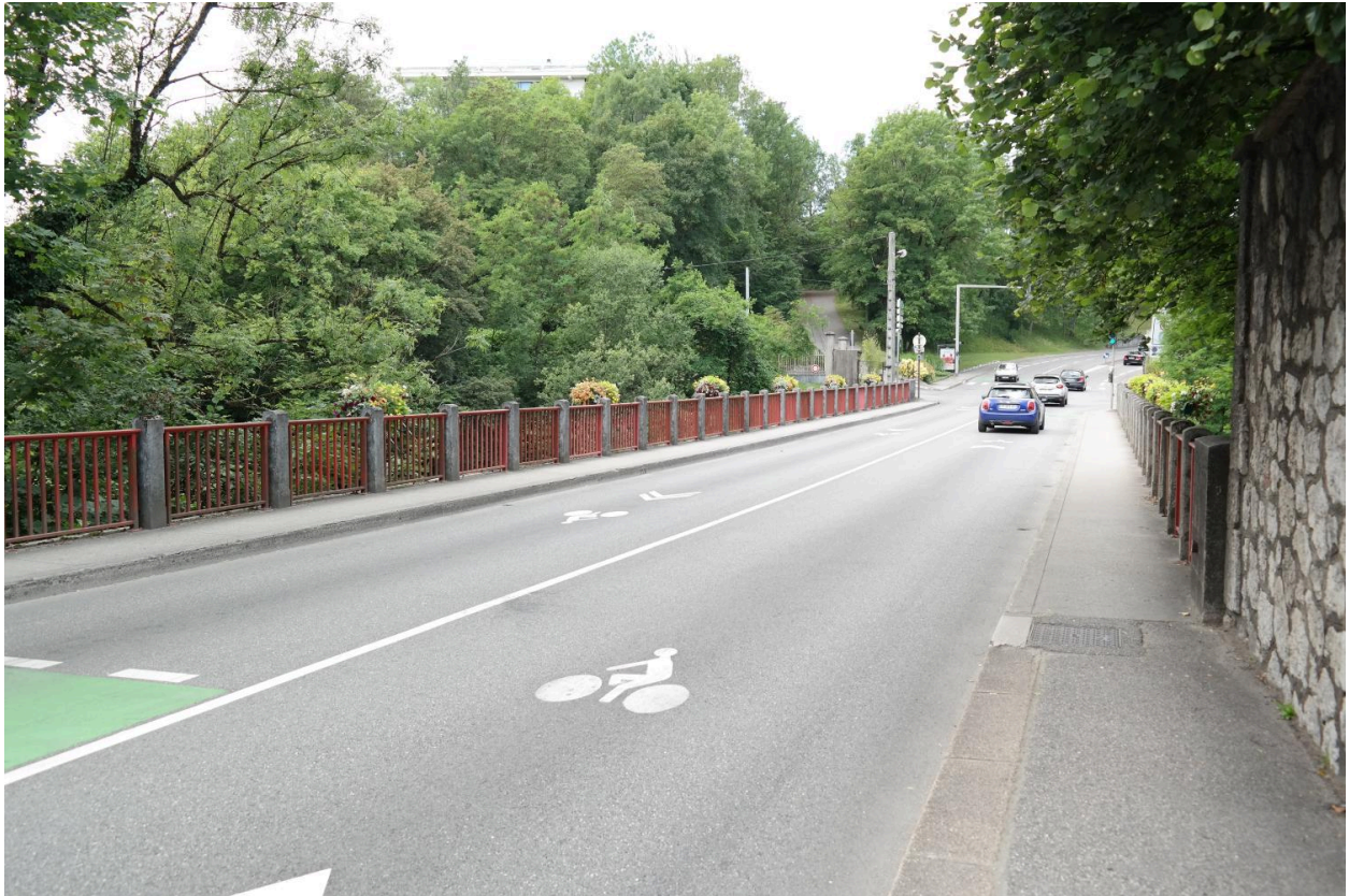
Pont de Tasset, vue de la chaussée
