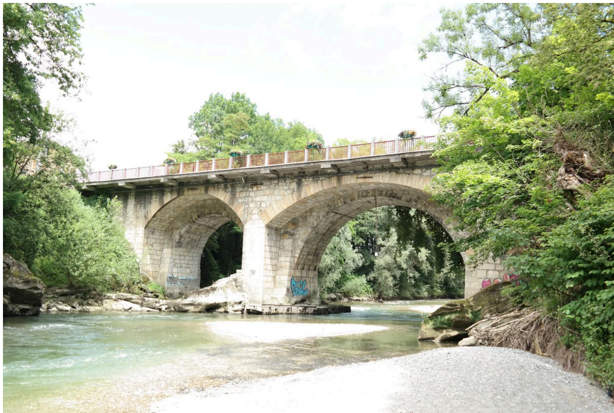
Pont de Tasset, vue de la face aval
