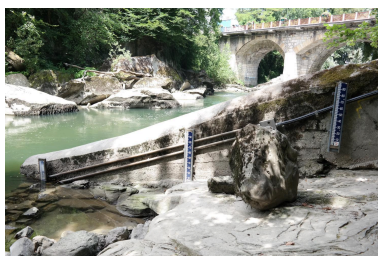
Pont des Tassetes, détail des échelles de niveau d'eau Phot. Pascale Renard IVR84_20207403870NUCA
