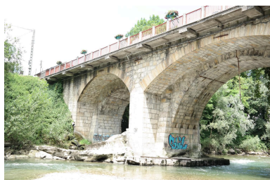
Pont de Tasset, détail des voûtes et de la pile Phot. Pascale Renard IVR84_20207403869NUCA
