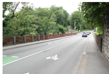
Pont de Tasset, vue de la chaussée Phot. Pascale Renard IVR84_20207403868NUCA
