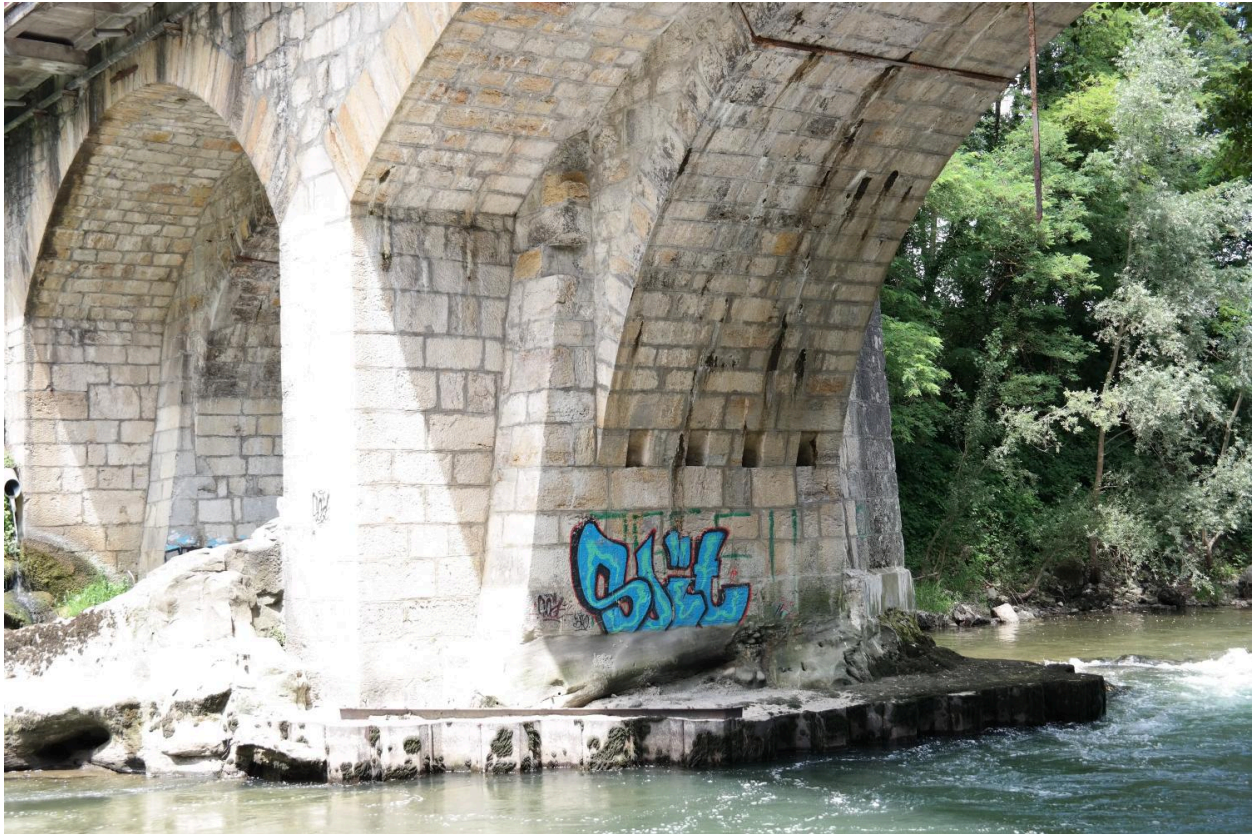
Pont de Tasset, détail de la pile centrale
