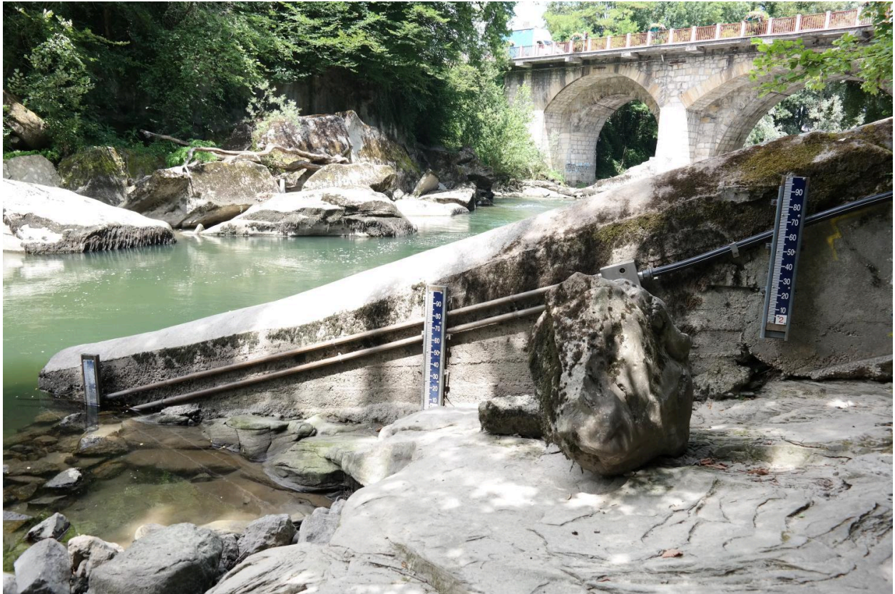
Pont des Tassetes, détail des échelles de niveau d'eau
