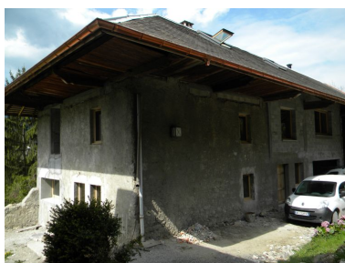
Goutterau de l'ancienne ferme de la maison Blain. Phot. Jérôme Daviet IVR82_20107400840NUCA
