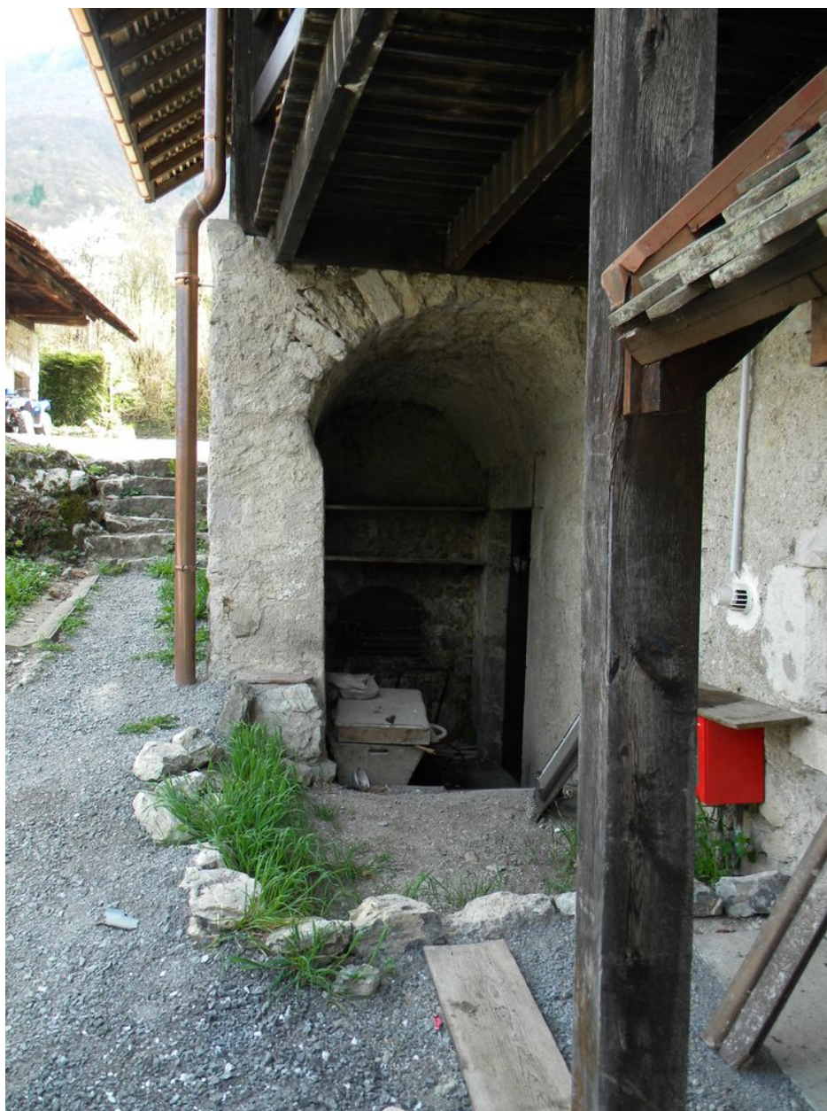
Loge en façade nord sous le perron d'entrée secondaire avec une ouverture en forme de bouche de four à pain.
