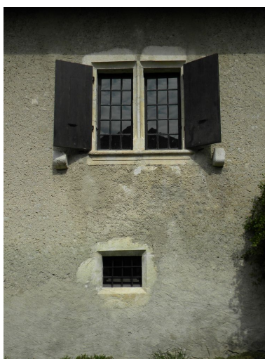
Fenêtre à meneau en façade sud. Phot. Jérôme Daviet IVR82_20107400831NUCA
