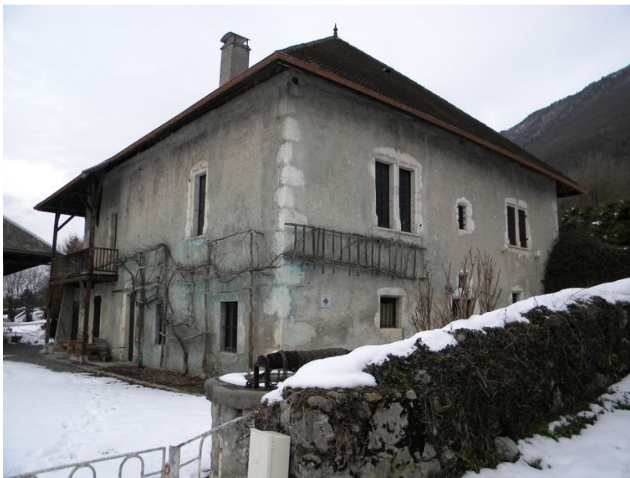
Vue générale de trois-quarts, façades sud et ouest.
