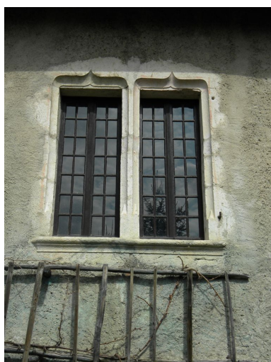
Fenêtre à meneau en façade sud. Phot. Jérôme Daviet IVR82_20107400830NUCA
