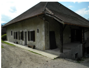
Façades est et nord, vue de trois-quarts. Phot. Jérôme Daviet IVR82_20107400828NUCA
