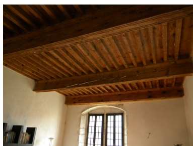
Plafond à la française. Phot. Jérôme Daviet IVR82_20107400833NUCA
