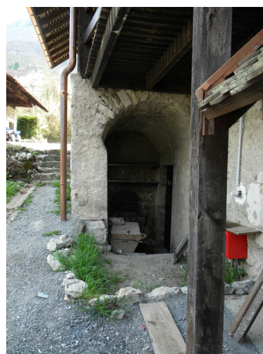
Loge en façade nord sous le perron d'entrée secondaire avec une ouverture en forme de bouche de four à pain. Phot. Jérôme Daviet IVR82_20107400832NUCA
