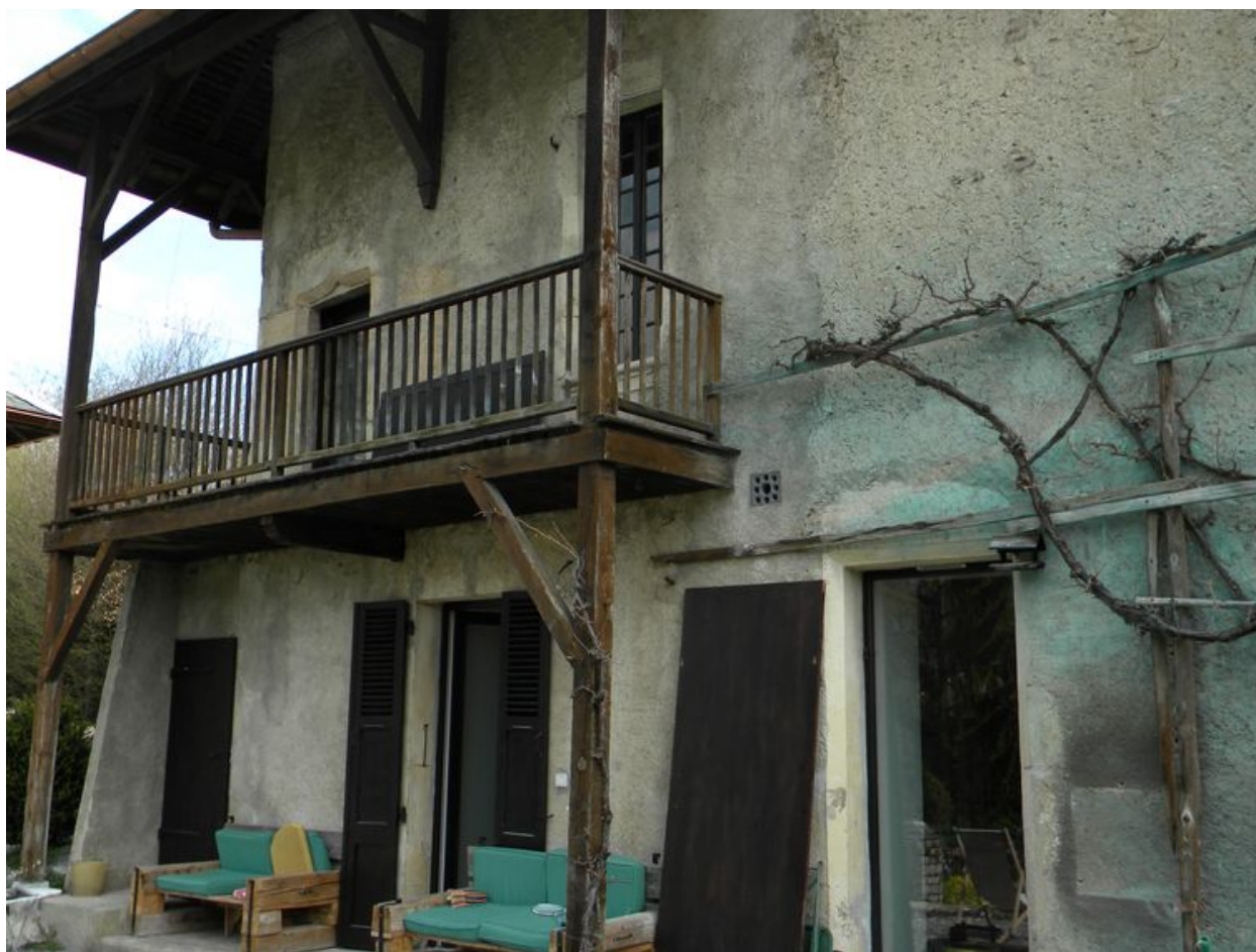
Façade ouest avec porte d'entrée actuelle et petit balcon.
