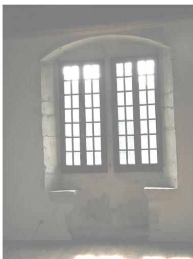
Fenêtre à meneau avec coussiège. Phot. Jérôme Daviet IVR82_20107400834NUCA
