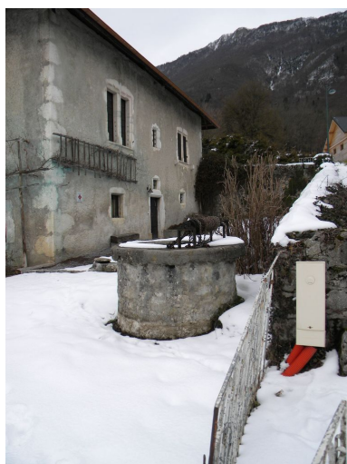
Vue de la façade sud et du puits. Phot. Jérôme Daviet IVR82_20107400824NUCA
