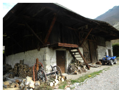
Grange de la maison Blain. Phot. Jérôme Daviet IVR82_20107400841NUCA
