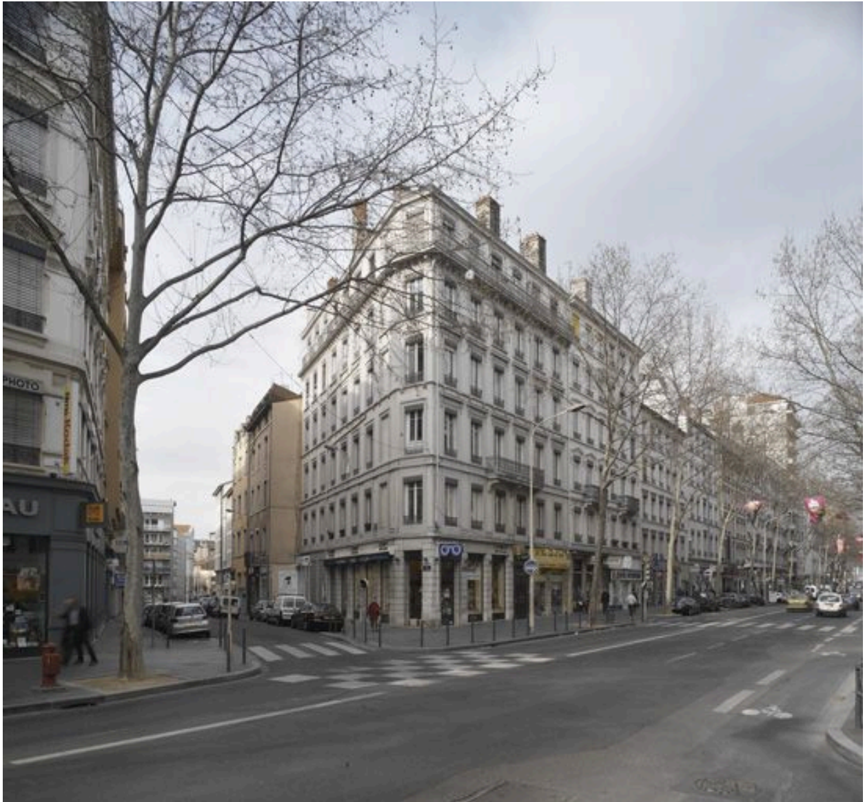
Vue générale de l'angle du cours Gambetta et de la rue Louis-Dansard
