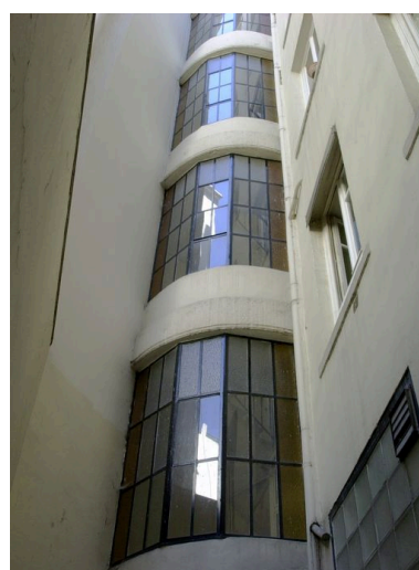
Vue de la cage d'escalier demi-hors-oeuvre Phot. V. Baud IVR82_20046904733NUCA
