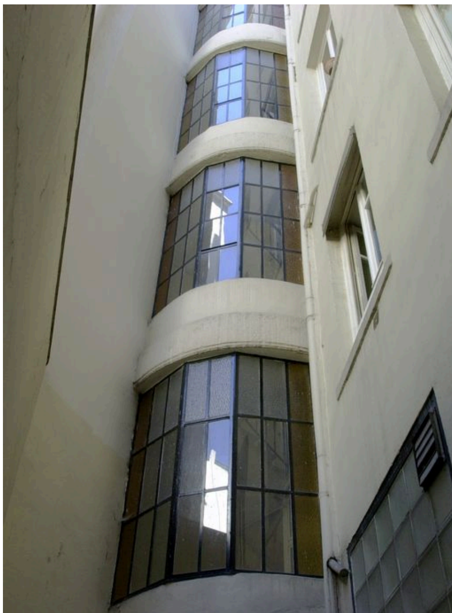
Vue de la cage d'escalier demi-hors-oeuvre
