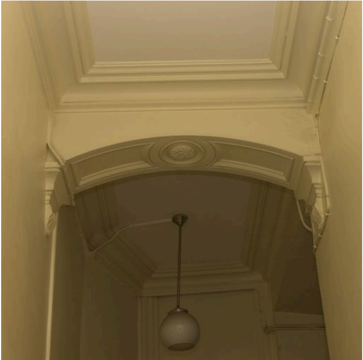
Détail de l'étrésillonement du vestibule
