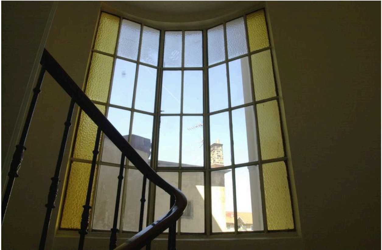
Vue des baies éclairant l'escalier
