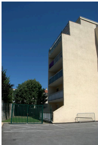
Vue de l'élévation depuis le sud ouest Phot. Maryannick Chalabi IVR82_20116901573NUCA
