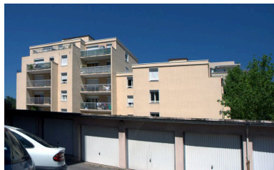
Vue générale depuis le sud est Phot. Maryannick Chalabi IVR82_20116901570NUCA
