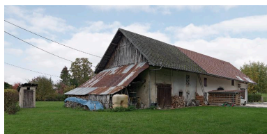
Vue d'ensemble des deux fermes mitoyennes (2015 A2 2313, repérée, et 1434). Phot. Eric Dessert IVR84_20167306661NUCA
