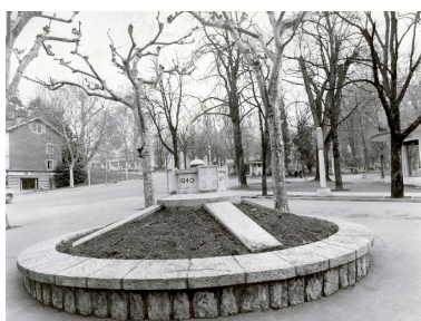
Vue du monument lors de son édification Repro. François Fouger IVR82_20097300458NUCB
