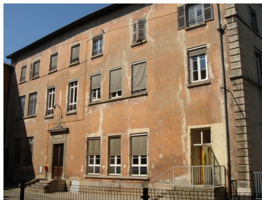
Façade sur cour Phot. Isabelle Dupuis IVR82_20123800185NUCA
