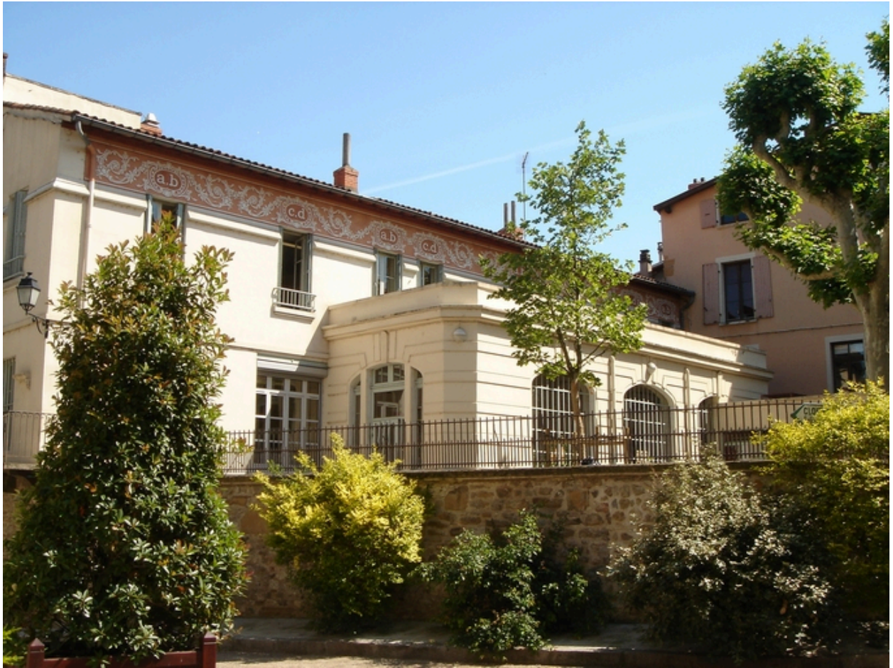
Façade sur la rue de la Table Ronde
