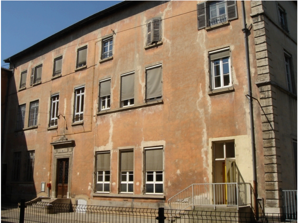
Façade sur cour
