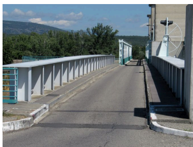
Pont sur la nouvelle passe navigable : chaussée du pont Phot. I. Havard IVR82_20102600132NUCA
