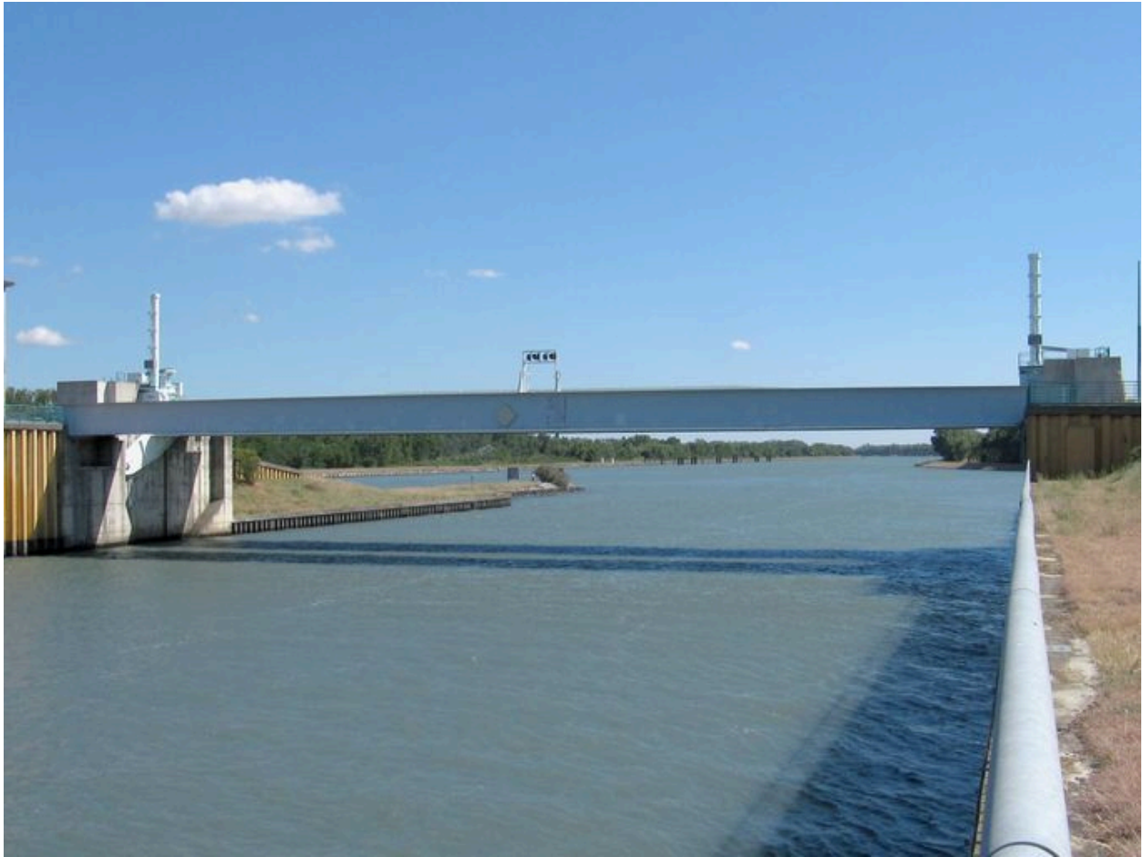
Pont sur la nouvelle passe navigable : vue générale, face amont
