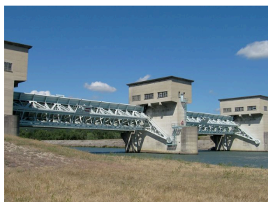
Barrage aval : vue générale, face aval Phot. I. Havard IVR82_20102600128NUCA
