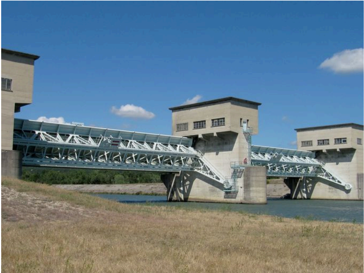
Barrage aval : vue générale, face aval
