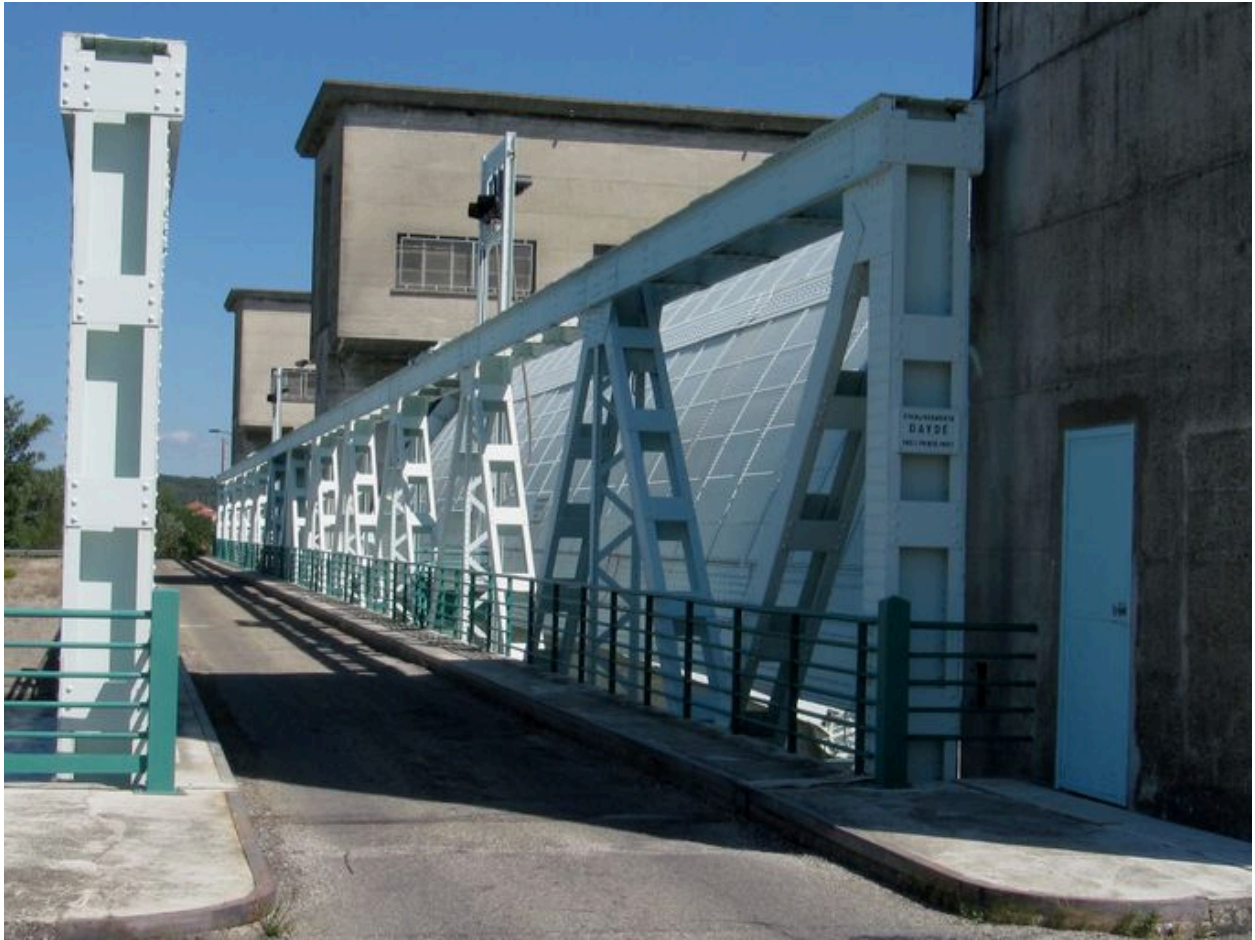
Barrage aval : chaussée du pont routier
