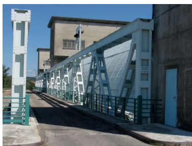
Barrage aval : chaussée du pont routier Phot. I. Havard
