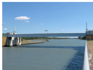
Pont sur la nouvelle passe navigable : vue générale, face amont Phot. I. Havard IVR82_20102600130NUCA
