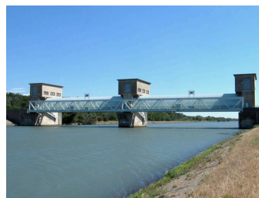
Barrage aval : vue générale, face amont Phot. I. Havard IVR82_20102600127NUCA
