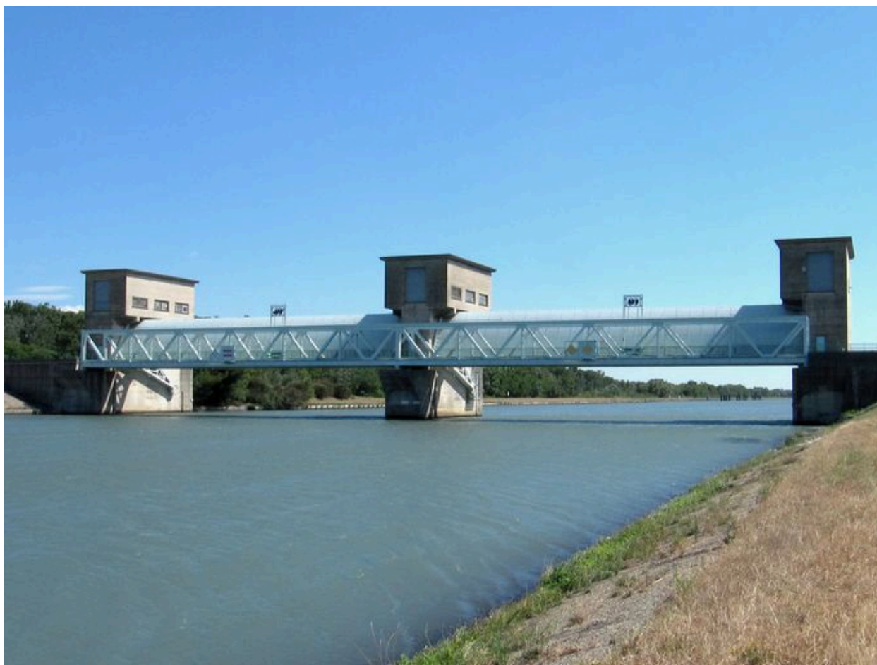
Barrage aval : vue générale, face amont
