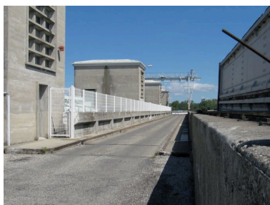
Barrage amont : chaussée du pont routier Phot. I. Havard IVR82_20102600126NUCA
