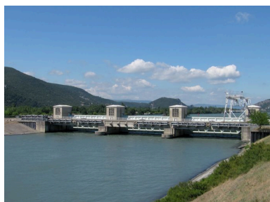
Barrage amont : vue générale, face aval Phot. I. Havard IVR82_20102600125NUCA
