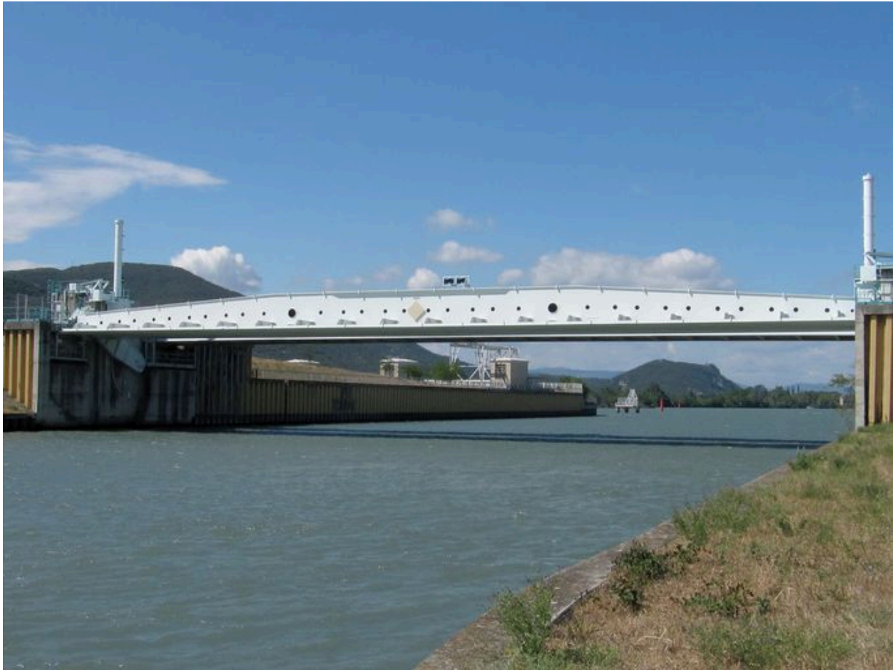
Pont sur la nouvelle passe navigable : vue générale, face aval
