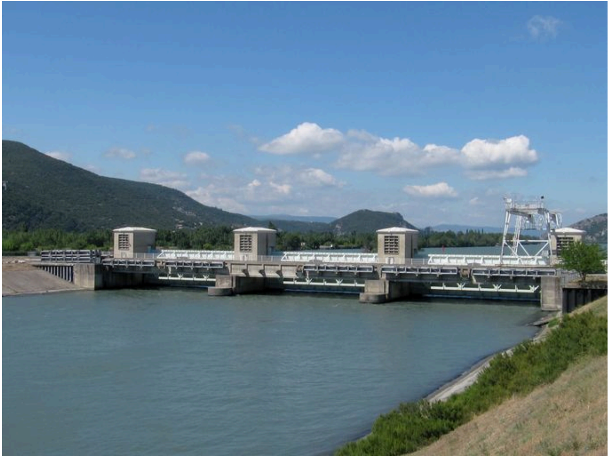
Barrage amont : vue générale, face aval
