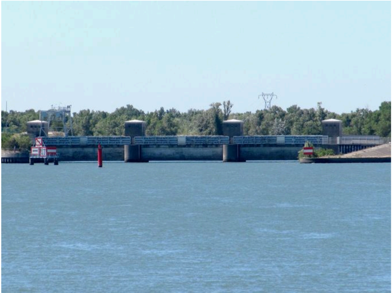
Barrage amont : vue générale, face amont
