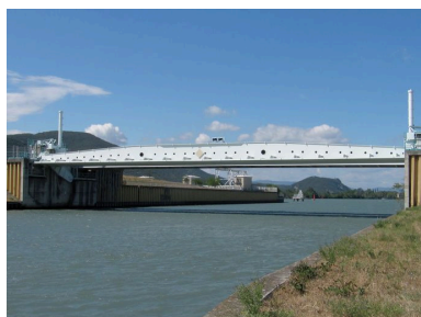
Pont sur la nouvelle passe navigable : vue générale, face aval Phot. I. Havard IVR82_20102600131NUCA
