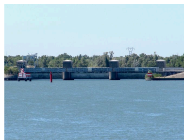
Barrage amont : vue générale, face amont Phot. I. Havard IVR82_20102600124NUCA
