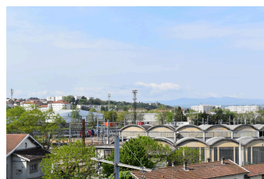
La rotonde des locomotives en 2022 vue depuis l'autopont Phot. Nadine Halitim-Dubois IVR84_20226900579NUCA
