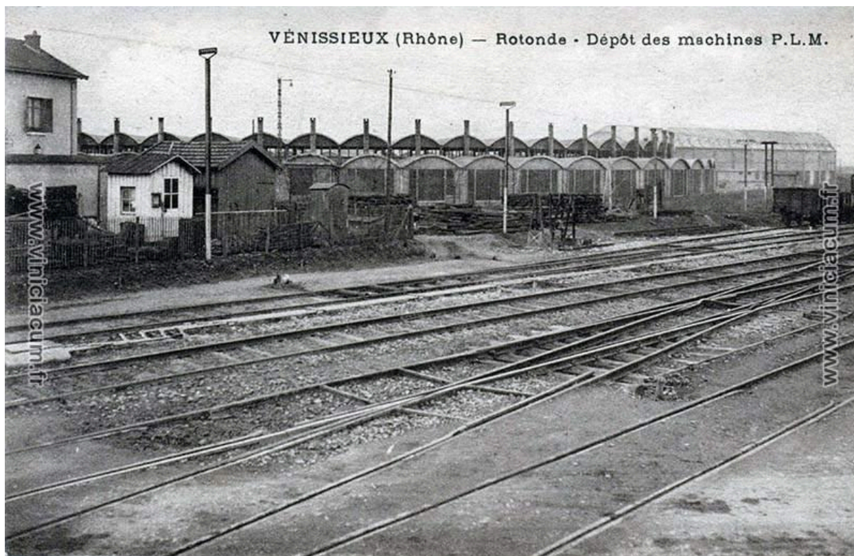
Vénissieux (Rhône) - Rotonde - Dépôt des machines P.L.M. (Association Viniciacum)
