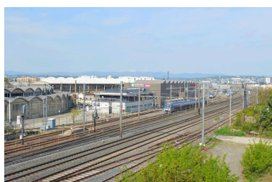
L'emprise SNCF la rotonde et la ligne de chemin de fer de Paris à Grenoble en 2022 vues depuis l'autopont Phot. Alice Giacovelli IVR84_20226900665NUCA
