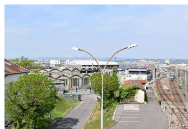
L'emprise SNCF et la rotonde des locomotives en 2022 à Vénissieux vues depuis l'autopont Phot. Nadine Halitim-Dubois IVR84_20226900584NUCA
