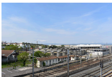
L'emprise SNCF et la rotonde de Vénissieux en 2022 vues depuis l'autopont Phot. Nadine Halitim-Dubois IVR84_20226900581NUCA
