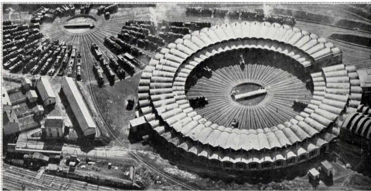
LES FANTAISIES DE LA PHOTOGRAPHIE AÉRIENNE A BASSE ALTITUDE : LA DOUBLE ROSACE D'ACIER DU DÉPÔT DE LOCOMOTIVES DE VÉNISSEUX (RHÔNE)
