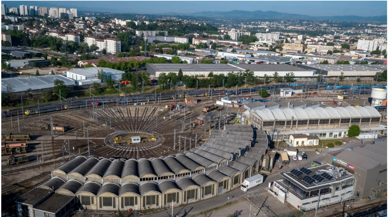
La Rotonde des locomotives - vue aérienne depuis l'autopont
