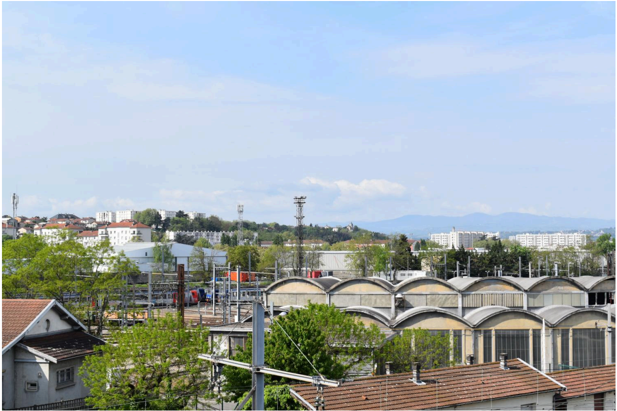
La rotonde des locomotives en 2022 vue depuis l'autopont
