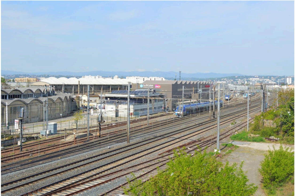
L'emprise SNCF la rotonde et la ligne de chemin de fer de Paris à Grenoble en 2022 vues depuis l'autopont
