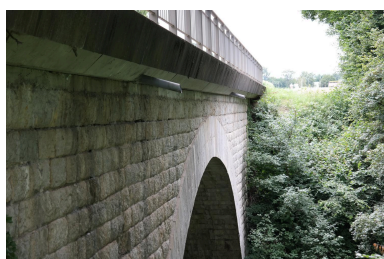
Pont de la Ravoire, détail de la face aval Phot. Pascale Renard IVR84_20207403096NUCA
