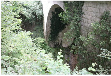
Pont de la Ravoire, détail de la pile en rive gauche face amont Phot. Pascale Renard IVR84_20207403098NUCA
