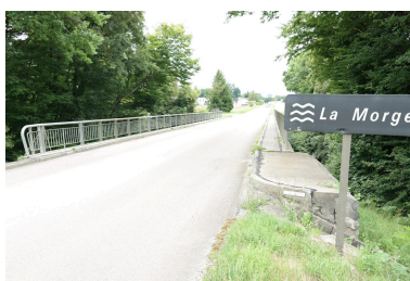
Pont de la Ravoire, chaussée et gardes-corps Phot. Pascale Renard IVR84_20207403097NUCA
