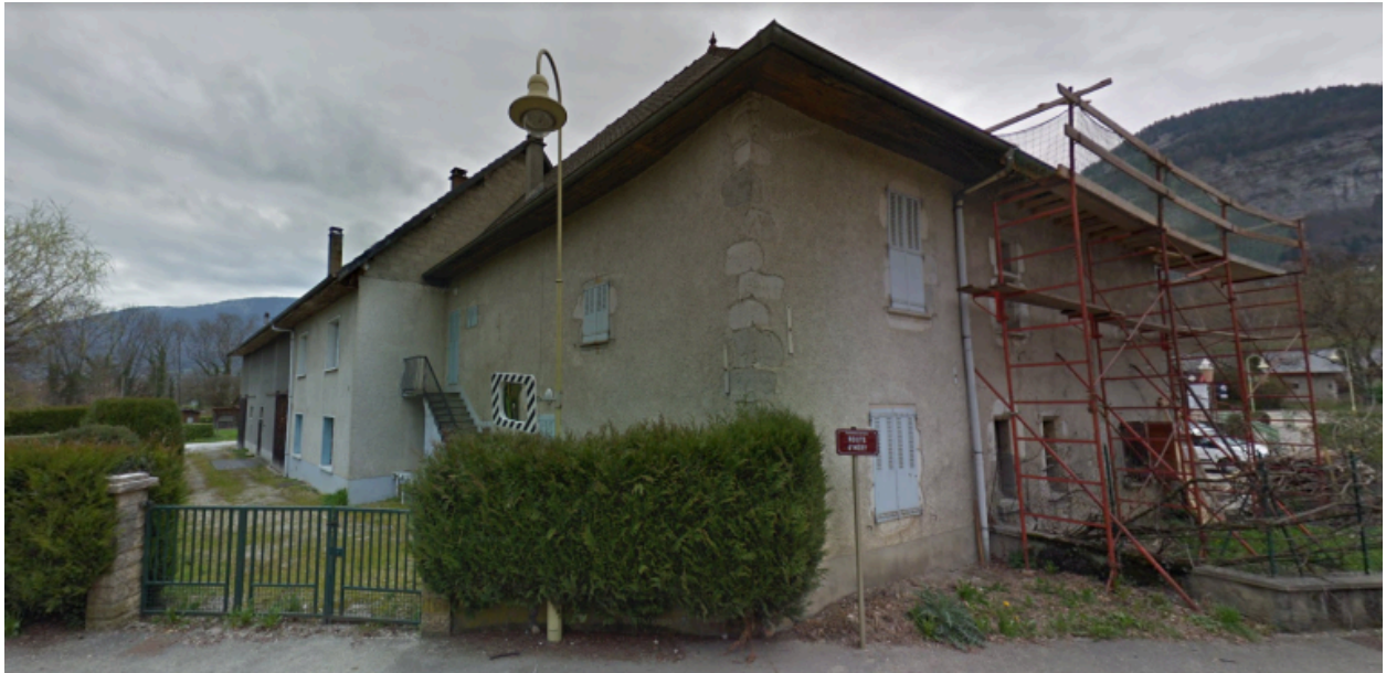
Vue d'ensemble des façades arrières de la ferme
