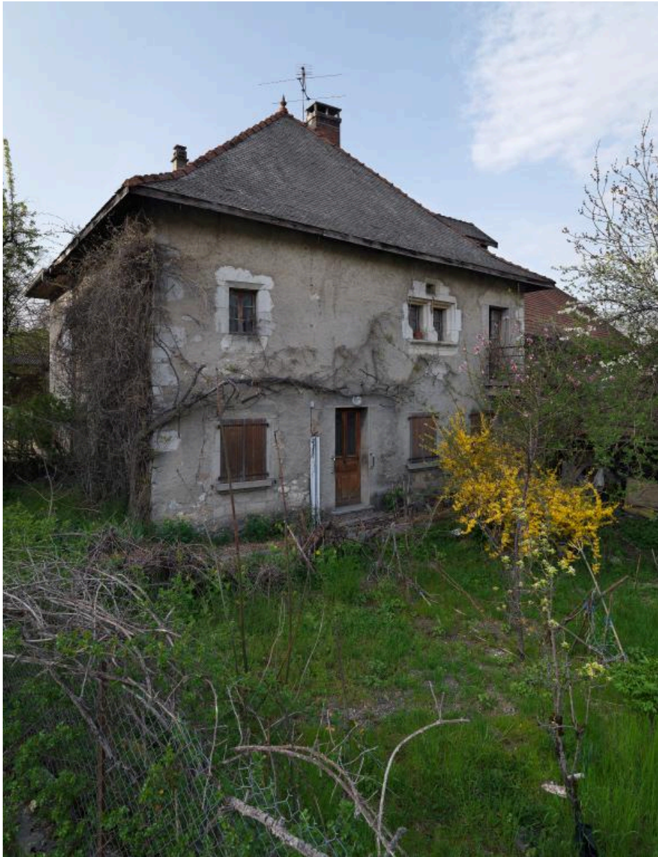
Vue d'ensemble de trois-quarts avant gauche.
