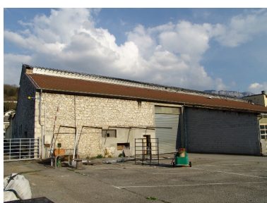
Façade antérieure de la grande halle Phot. François Fouger IVR82_20077300511NUCA
