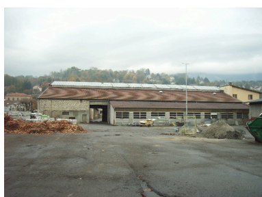
Grande halle, élévation sur la deuxième cour Phot. François Fouger IVR82_20087300911NUCA
