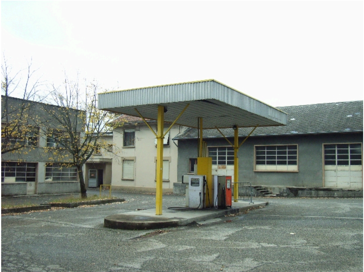
Station de carburant, première cour
