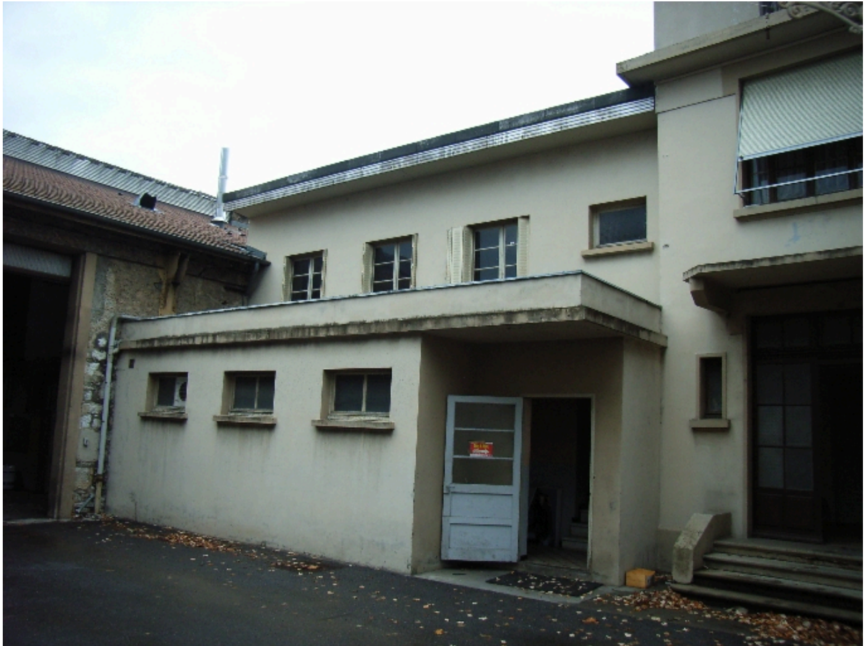
Bâtiment avec vestiaire, première cour
