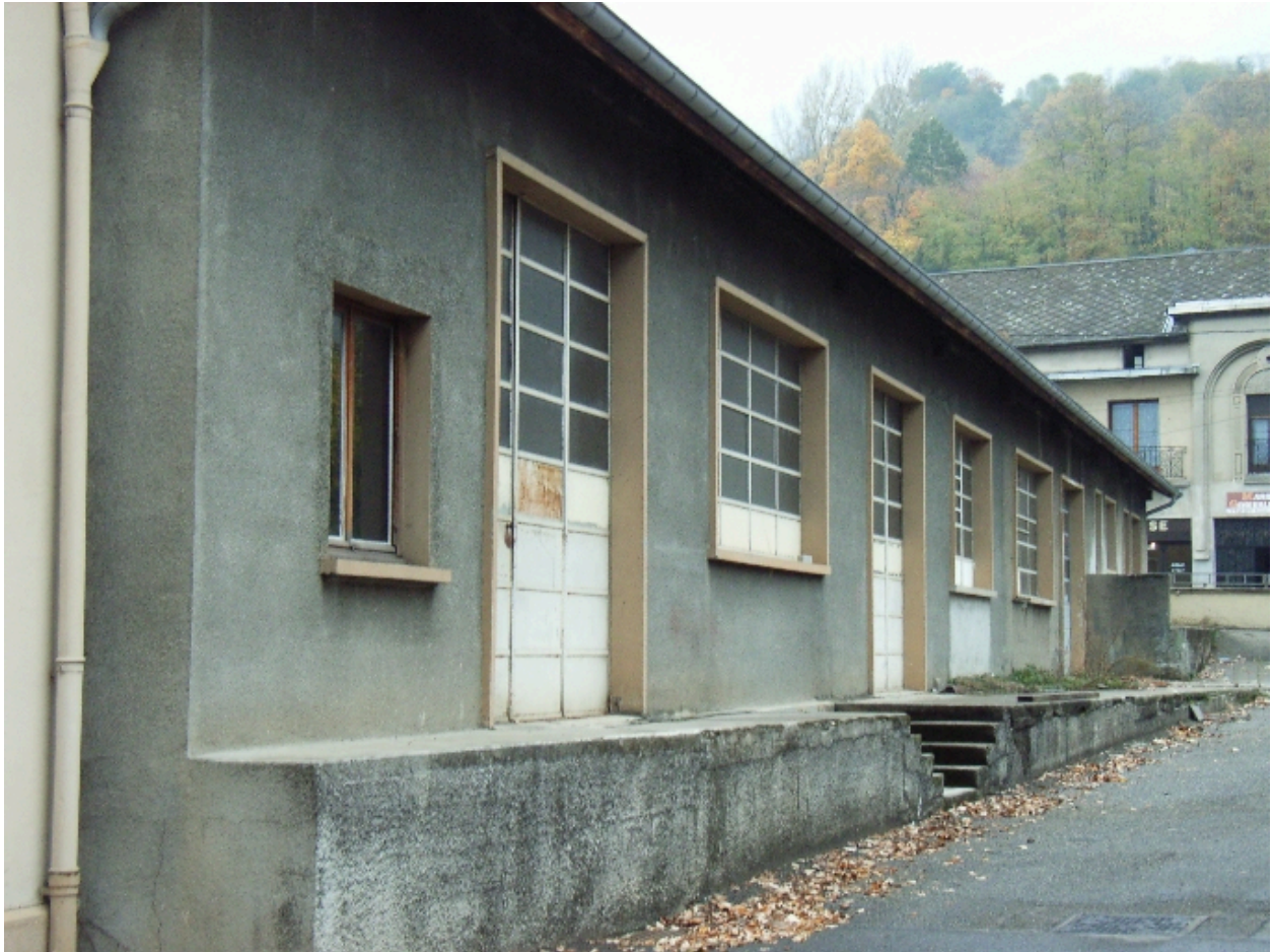
Bâtiment avec quai de déchargement, première cour
