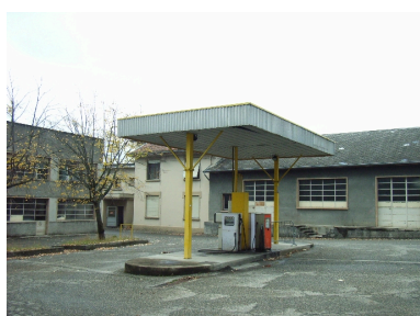
Station de carburant, première cour Phot. François Fouger IVR82_20087300910NUCA
