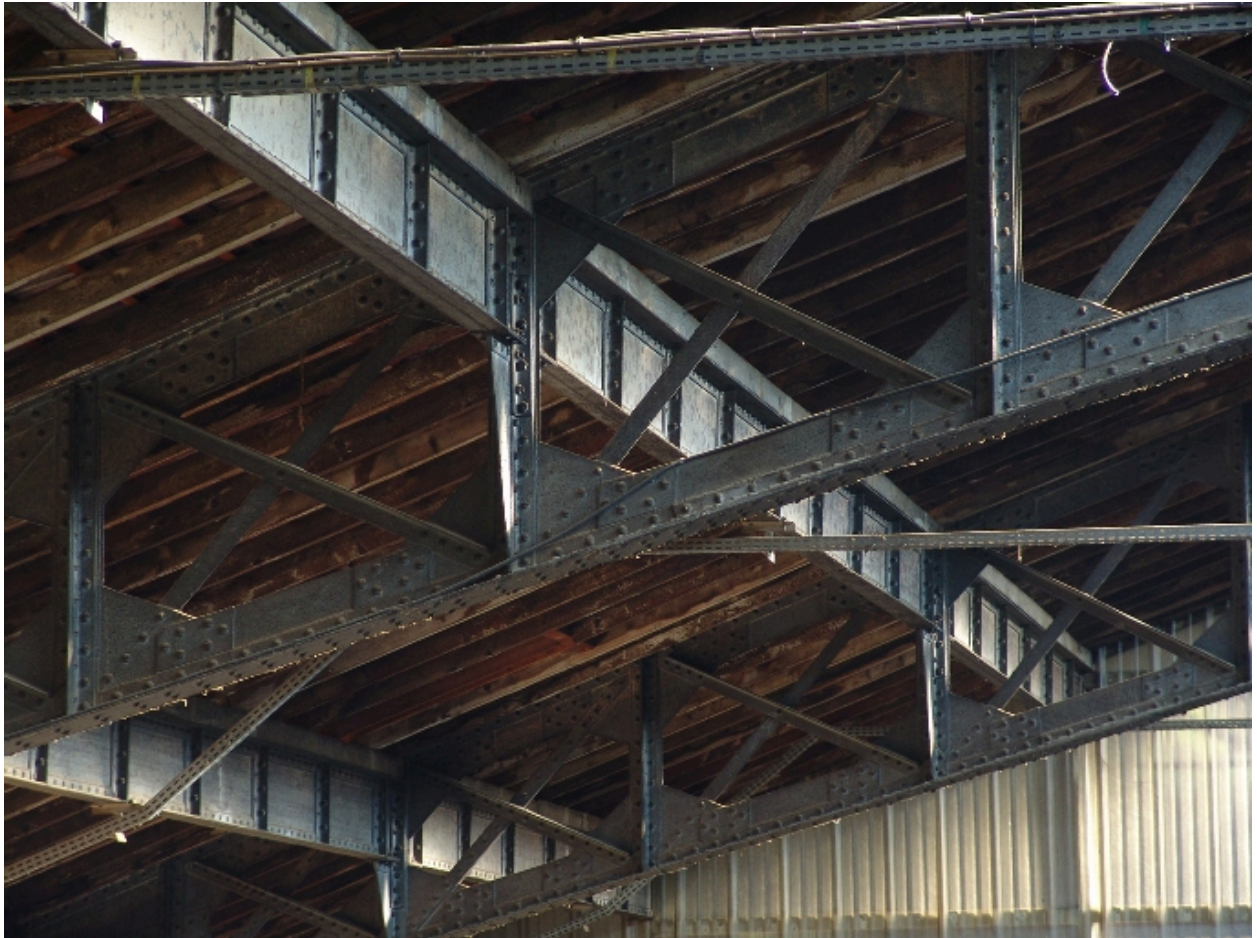
Charpente métallique de la grande halle
