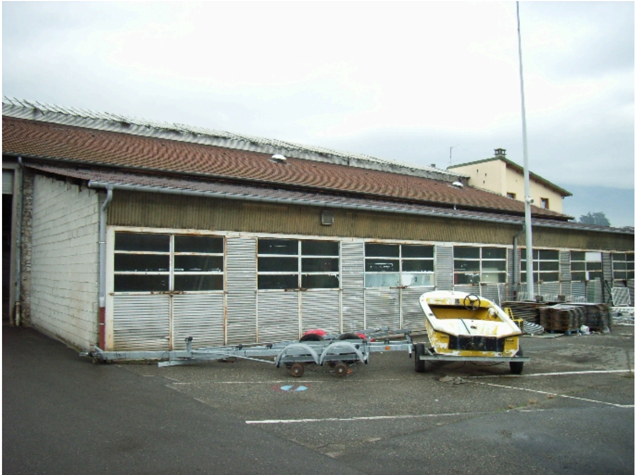
Bâtiment dans la cour postérieure
