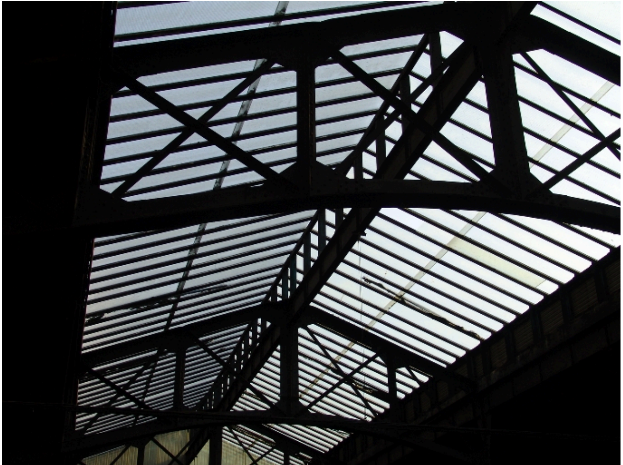
Verrière zénithale de la grande halle
