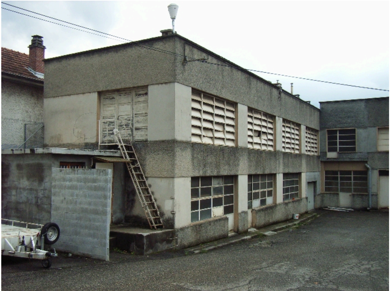
Bâtiment gauche, première cour
