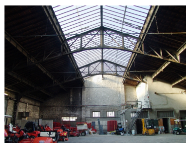
Vue intérieure de la grande halle Phot. François Fouger IVR82_20077300510NUCA
