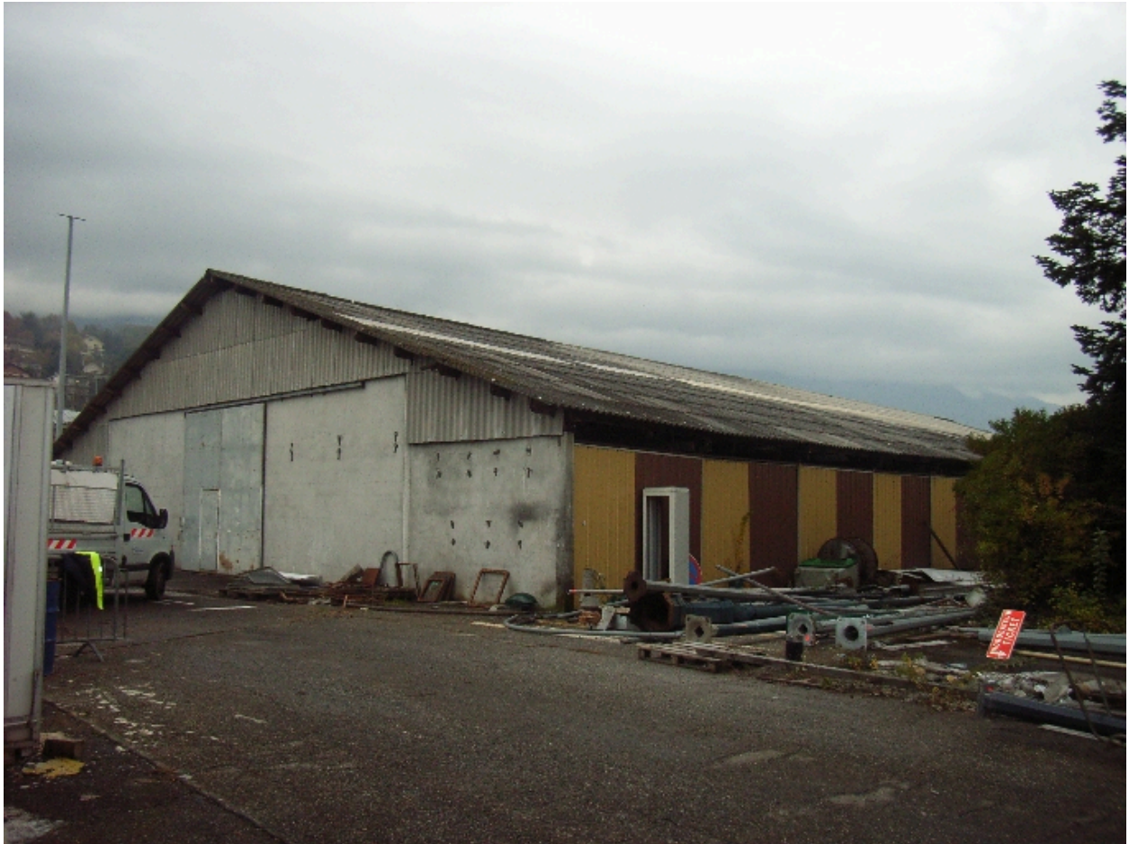
Hangar, deuxième cour
