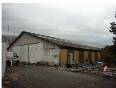
Hangar, deuxième cour Phot. François Fouger IVR82_20087300912NUCA
