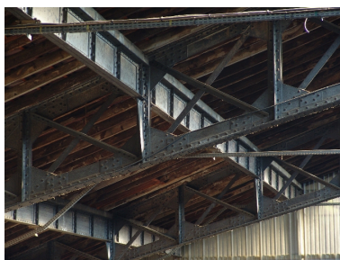
Charpente métallique de la grande halle Phot. François Fouger IVR82_20077300505NUCA
