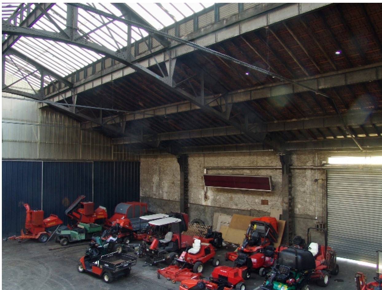
Entrée de la grande halle
