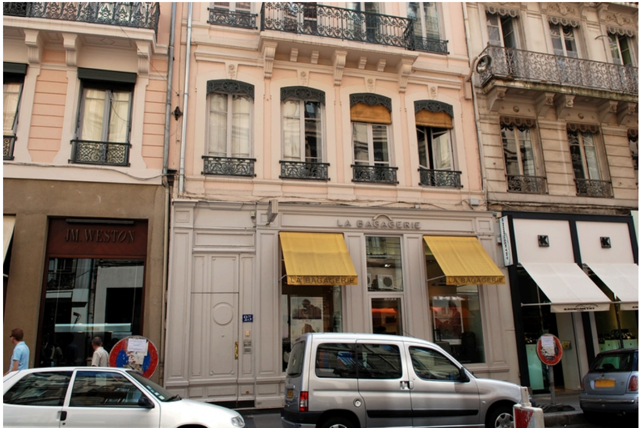
Elévation antérieure : le rez-de-chaussée
