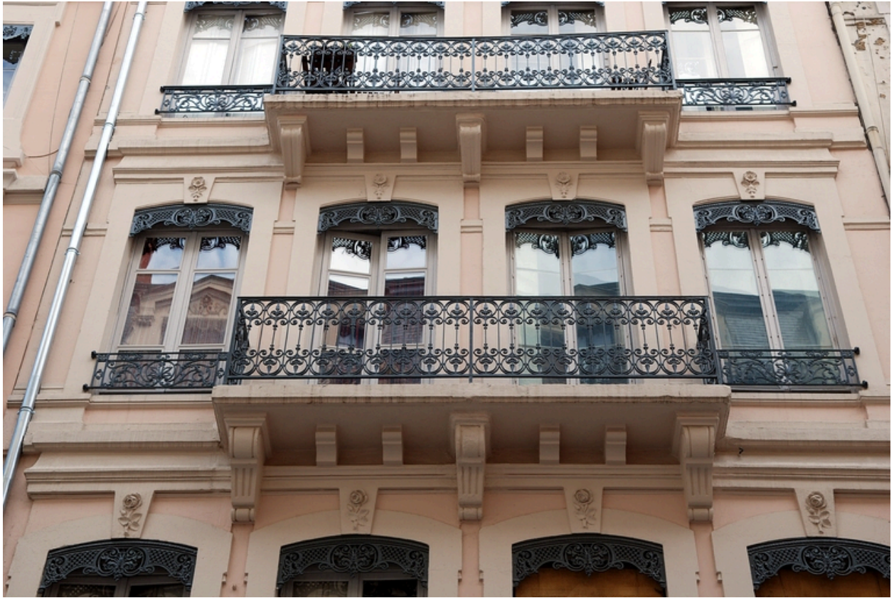
Elévation antérieure : détail
