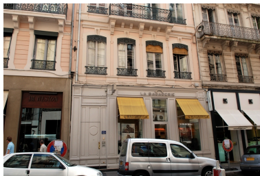
Elévation antérieure : le rez-de-chaussée Phot. Véronique Belle IVR82_20096905005NUCA
