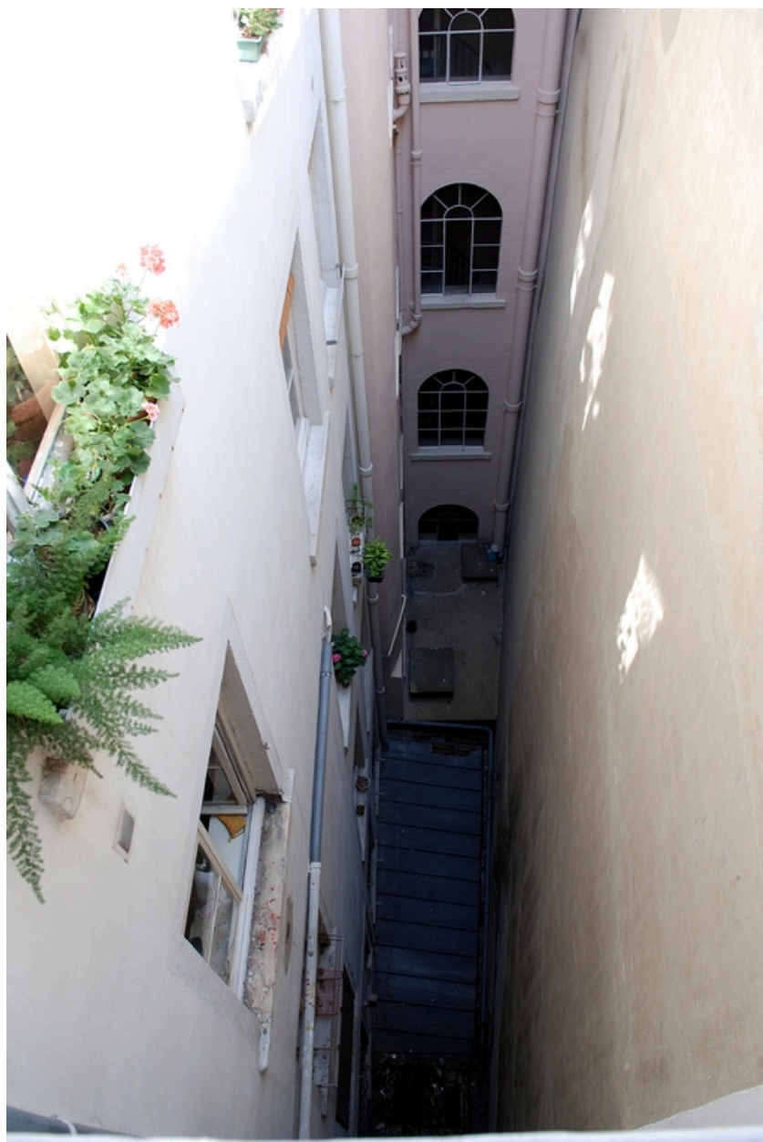
La cour : vue en plongée depuis le 27 rue Gasparin
