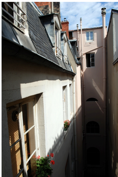
Elévations sur cour Phot. Véronique Belle IVR82_20096905008NUCA
