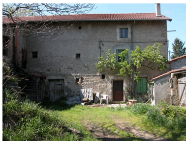
Vue générale Phot. Thierry Monnet IVR82_20114202010NUCA
