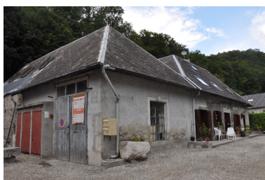
Vue d'un bâtiment présent sur le site Phot. Yannick Milleret IVR82_20127301719NUCA
