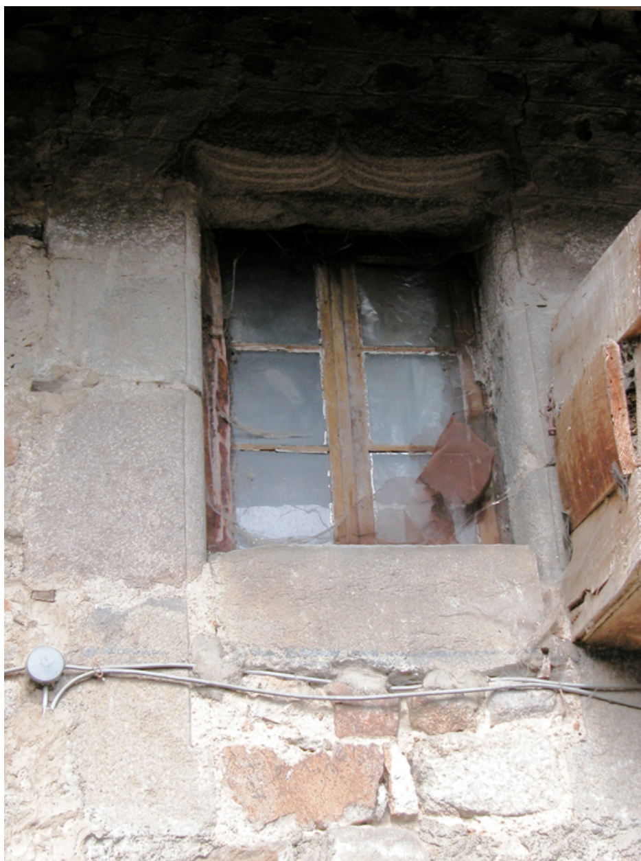
Détail de la fenêtre du rez-de-chaussée surélevé du logis.
