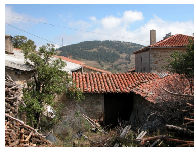
Vue du passage couvert sud-ouest ; à gauche, l'extrémité du logis (couvert en fibrociment), avec la bretagne qui dépasse à l'extérieur de la cour (à droite, toit à croupes du logis de la ferme IA42002338). Phot. Caroline Guibaud IVR82_20124201016NUCA
