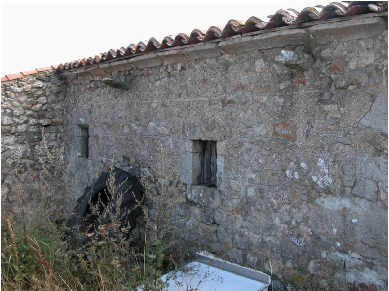
Vue de l'élévation arrière du logis.
