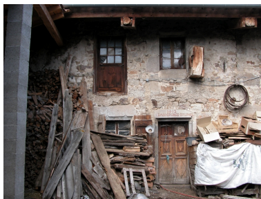
Vue d'ensemble de la façade sur cour du logis. Phot. Caroline Guibaud IVR82_20124201011NUCA
