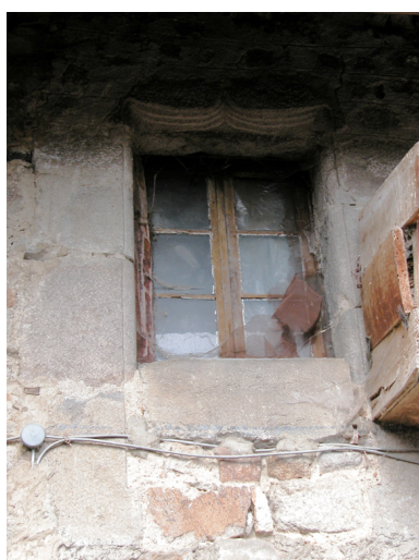
Détail de la fenêtre du rez-de-chaussée surélevé du logis. Phot. Caroline Guibaud
