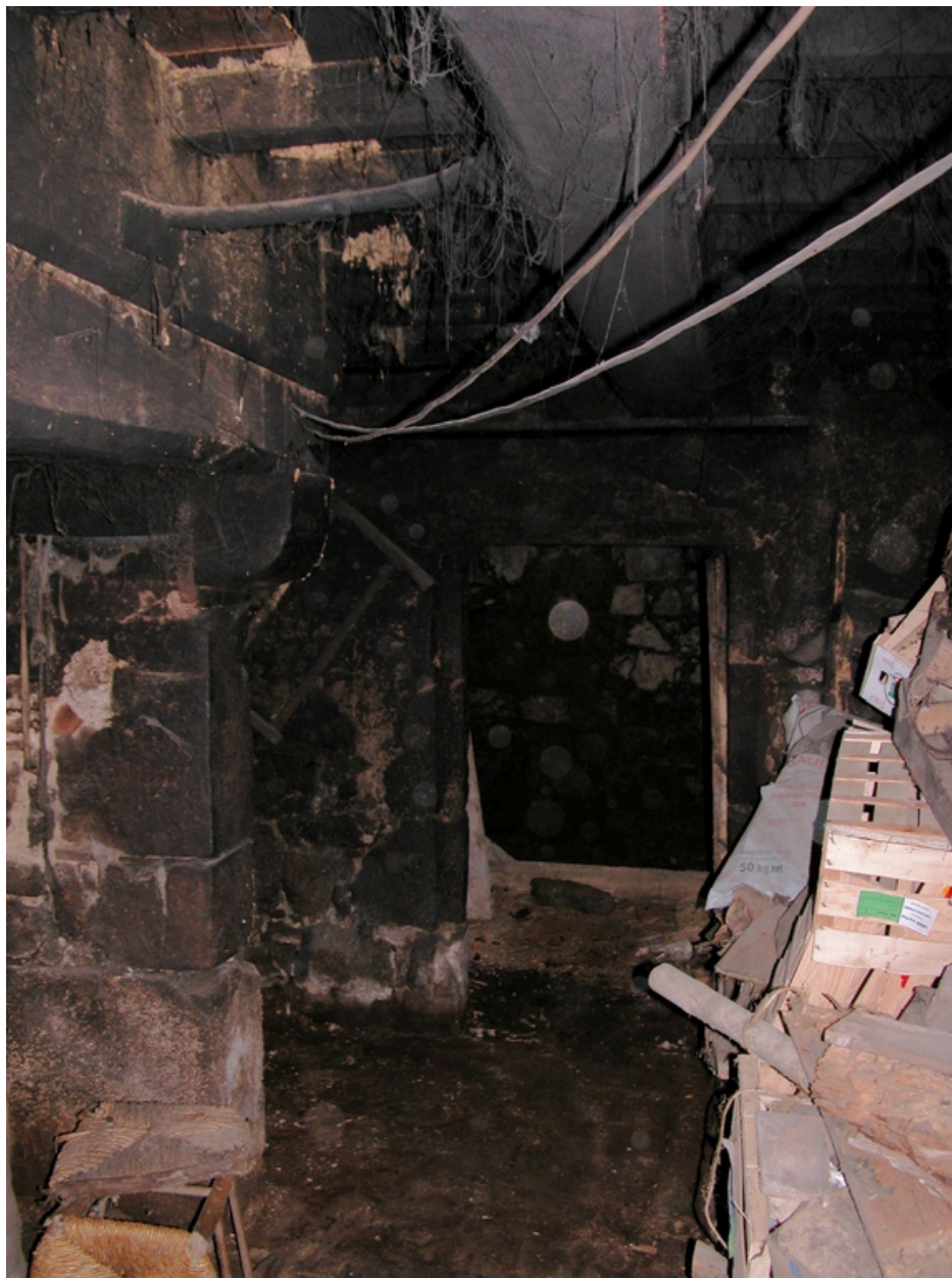
Vue intérieure de la cuisine : piédroit de la cheminée, porte de la cave à pommes de terre.
