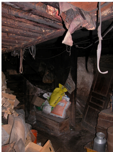
Vue intérieure de la cuisine : départ de l'escalier. Phot. Caroline Guibaud IVR82_20124201008NUCA
