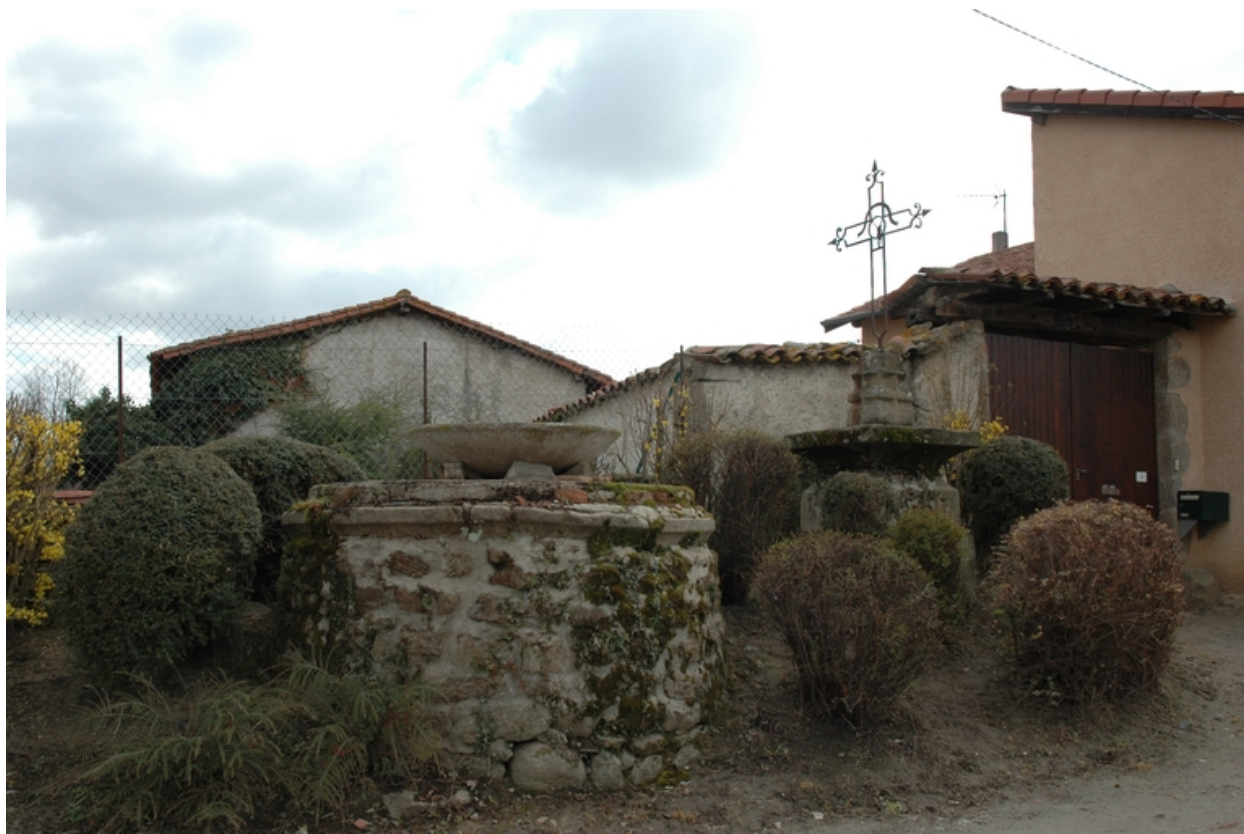
Vue générale, avec le puits.
