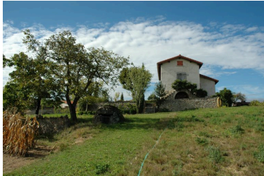
Vue générale Phot. Thierry Monnet IVR82_20134200330NUCA
