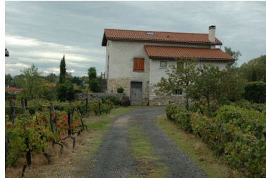
Vue d'ensemble du côté sud. Phot. Thierry Monnet IVR82_20134200331NUCA
