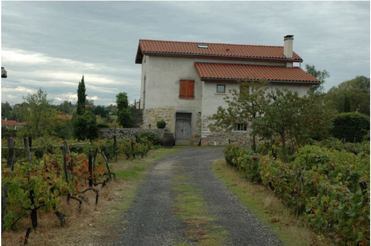
Vue d'ensemble du côté sud.
