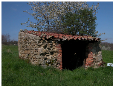
Vue d'ensemble. Phot. Thierry Monnet IVR82_20114202202NUCA
