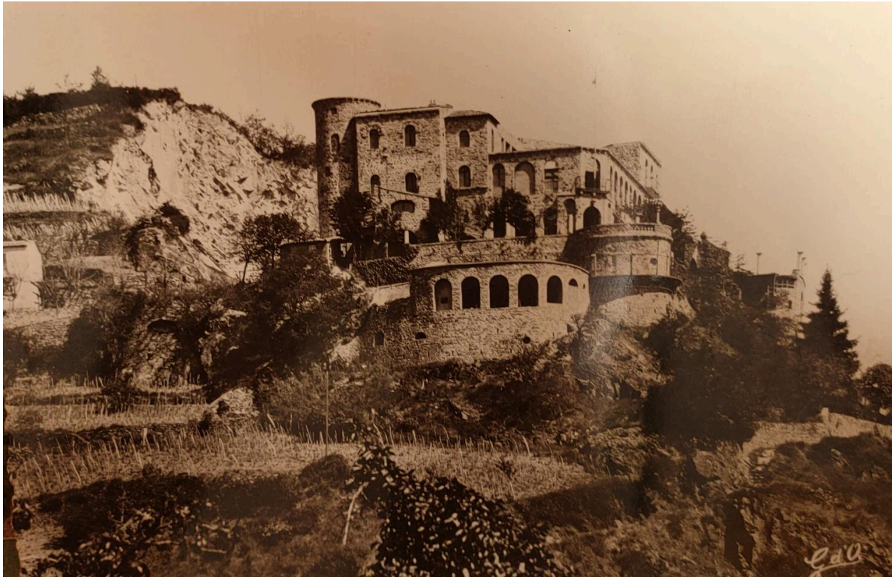
Vue du Paradis et de ses toits étagés, façade ouest, vers 1920.
