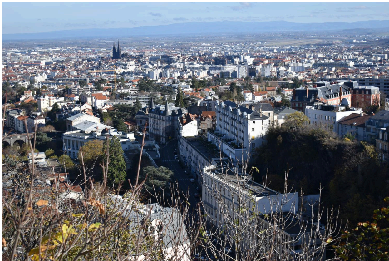
Ancien hôtel Royat-Palace avec les différents niveaux de terrasses.
