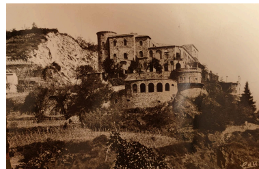
Vue du Paradis et de ses toits étagés, façade ouest, vers 1920. Repro. Isabelle Brown IVR84_20236300949NUCA
