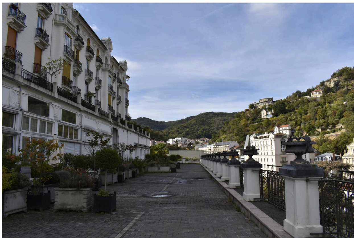
Panorama vers le Paradis depuis la première terrasse de l'ancien hôtel Royat-Palace.
