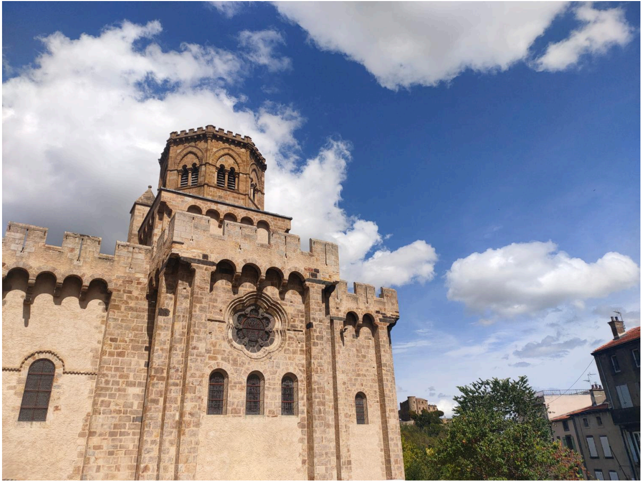
façade sud de l'église Saint-Léger et en arrière plan, façade sud du Paradis, sur le puy Chateix.
