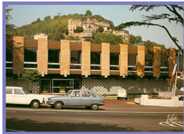
Entrée du nouvel hôtel de ville avec les travées reprenant la couleur de l'arkose et le Paradis en arrière plan (vers 1980). IVR84_20236300975NUCA
