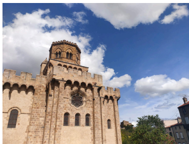
façade sud de l'église Saint-Léger et en arrière plan, façade sud du Paradis, sur le puy Chateix.
