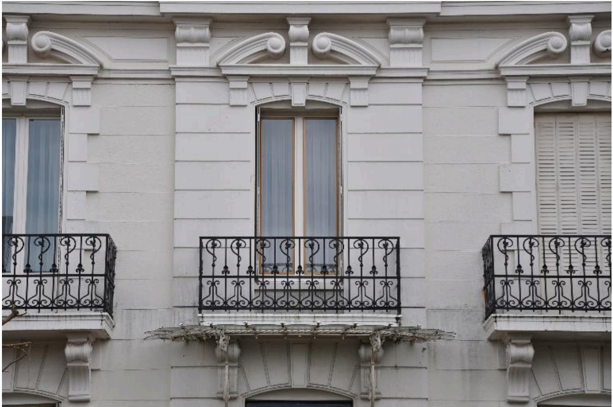
Détail des baies
