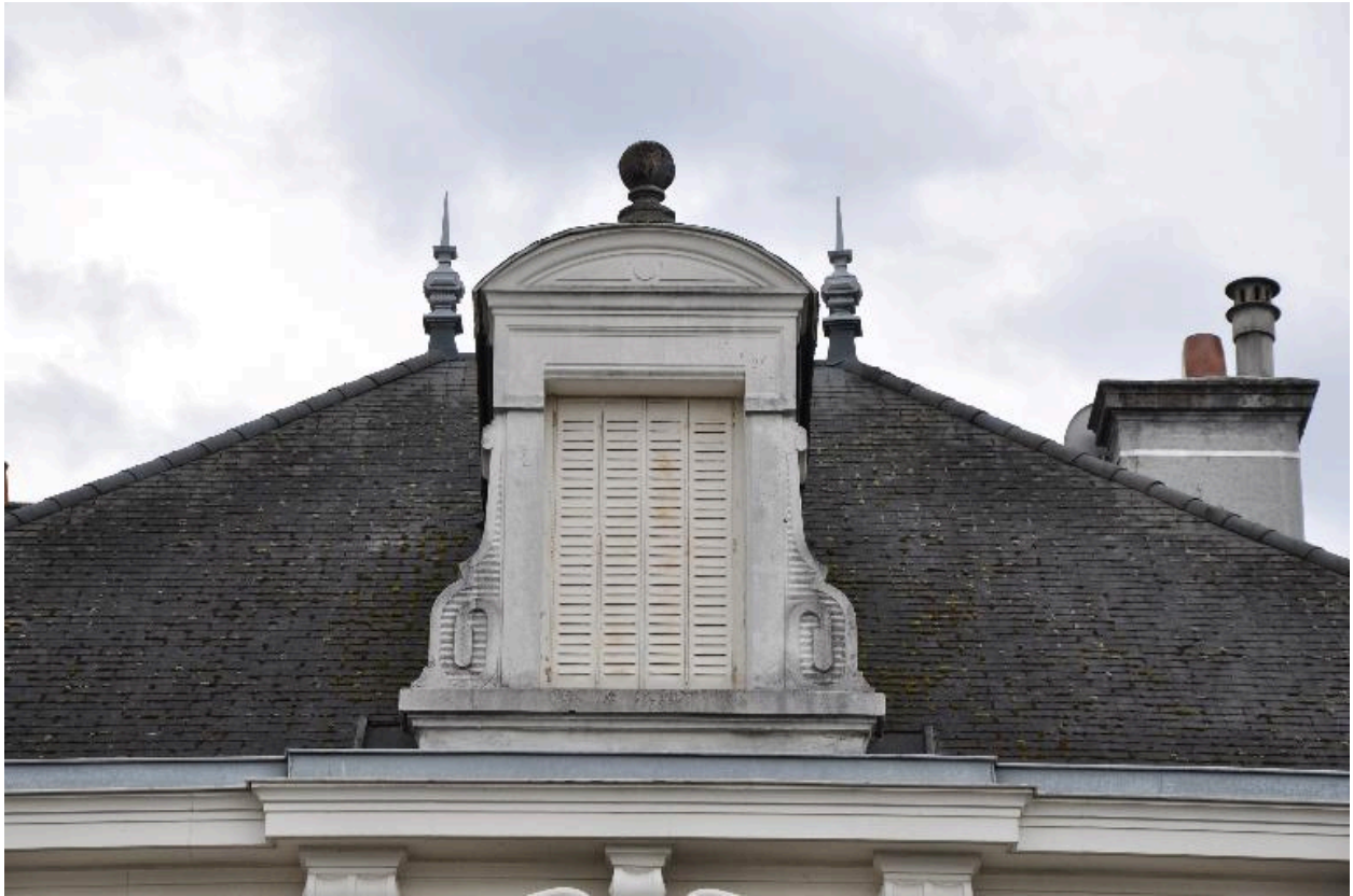
Détail d'une lucarne
