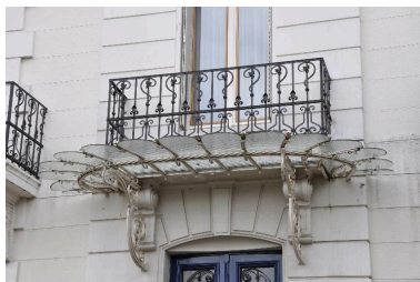
Marquise de la porte d'entrée Phot. Denys Harreau IVR82_20137300016NUCA
