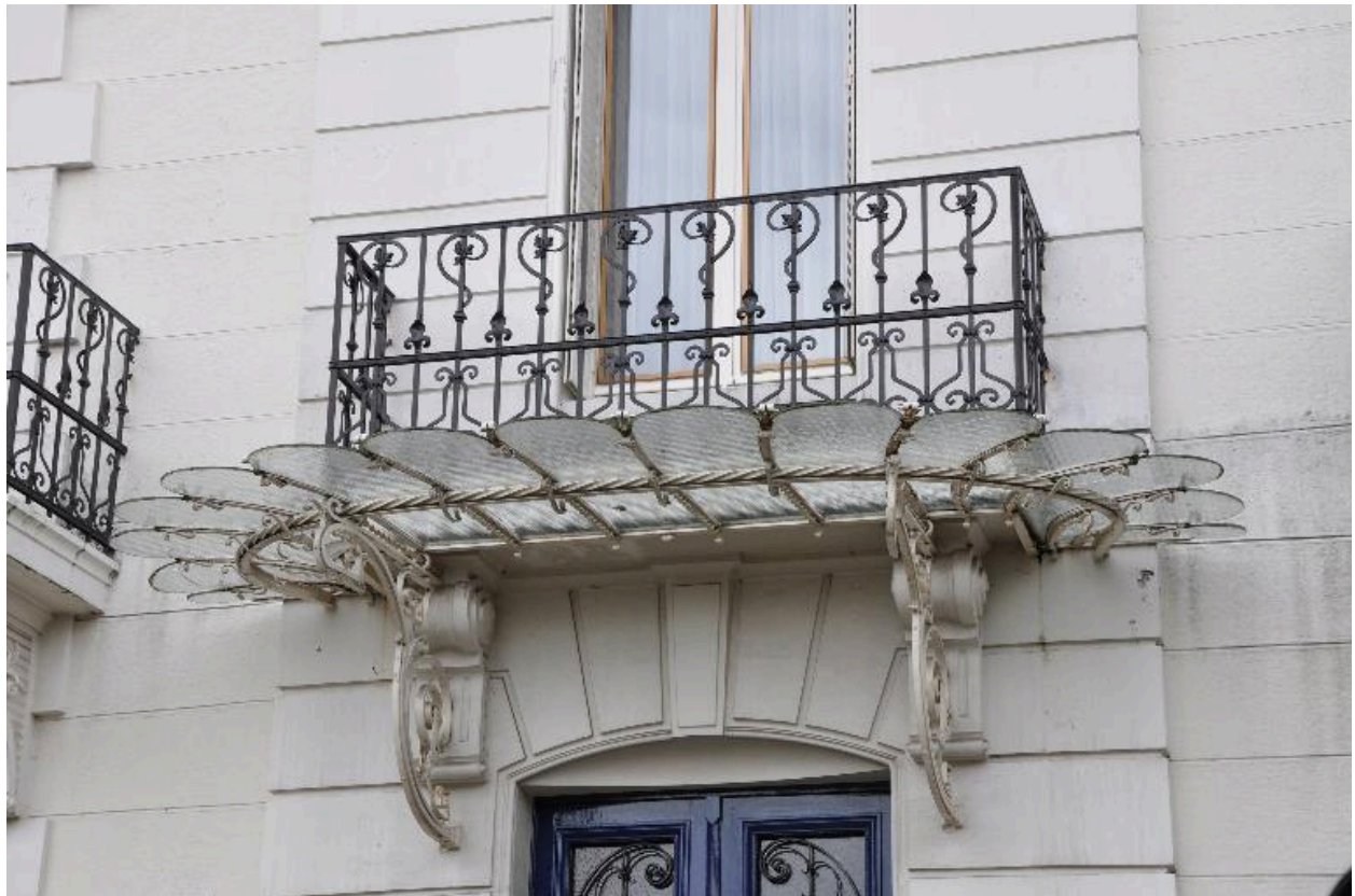
Marquise de la porte d'entrée
