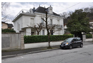
Vue de trois-quart Phot. Denys Harreau IVR82_20137300012NUCA
